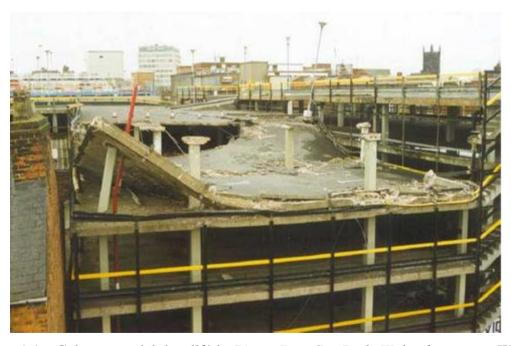
Figura 1.1 – Colapso parcial do edifício *Pipers Row Car Park*, *Wolverhampton* – Wood (1997).
