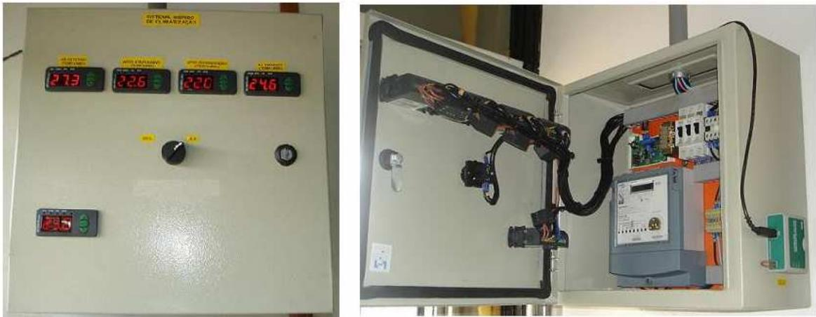
Figura 4.10 – Vista externa e interna do painel elétrico de controle
