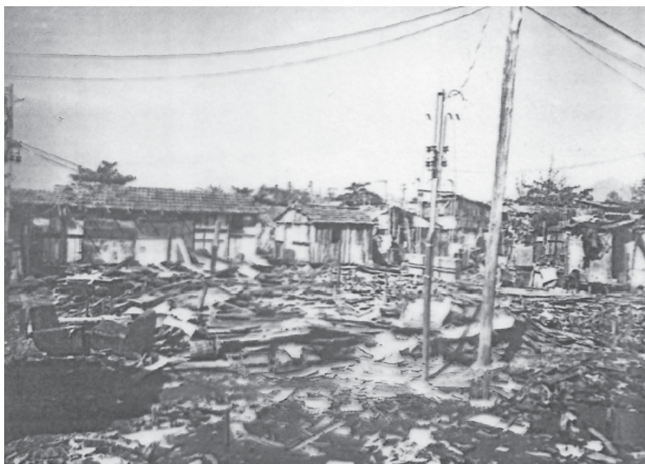
Figura 6 – Favela de Marcílio Dias com casas demolidas e remanescentes.
