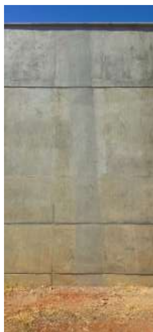
Figura 15: Acabamento após tratamento.
