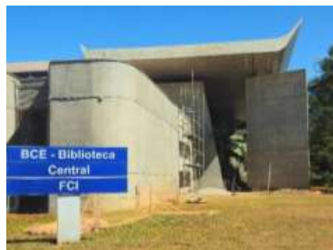
Figura 6: Brises e cobertura noroeste, após intervenção em 2025.
