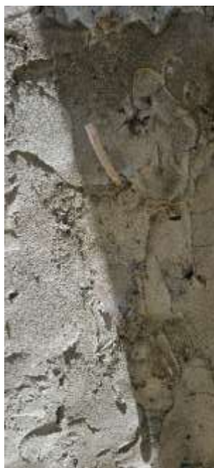
Figura 14: Detalhe do reparo com o bico de injeção de resina.
