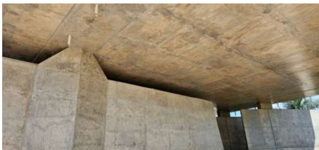
Figura 19: Fundo da laje de cobertura noroeste após recuperação e tratamento.
