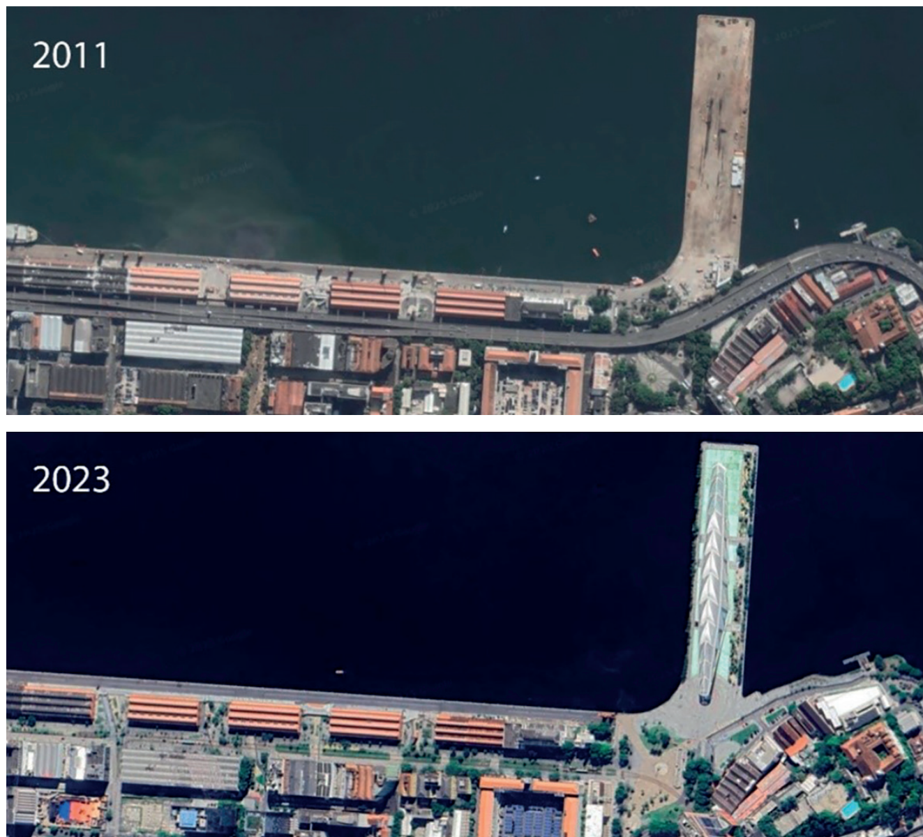
Figura 1: Vista de trecho do Elevado da Perimetral antes e após a demolição.
