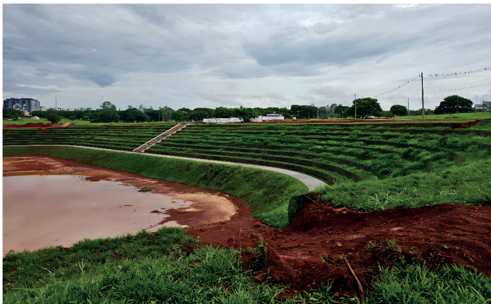
Figura 1 – Bacia de retenção do projeto Drenar DF: taludes e áreas recreativas gramadas.
