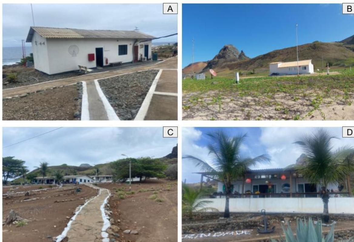
Figura 11 – Instalações do POIT
