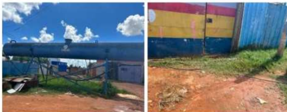
Figure 3 - Fontes de água em Santa Luzia: Estrutural, Distrito Federal, 2023.
