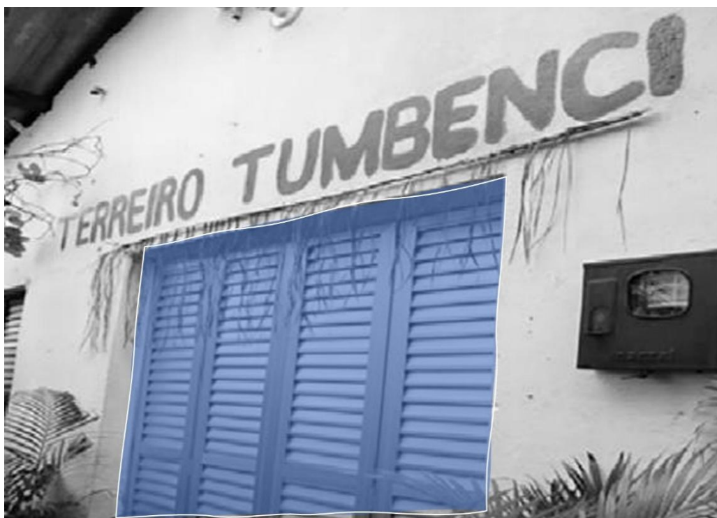
Figura 73 – Fachada Barracão - Entrada em destaque
