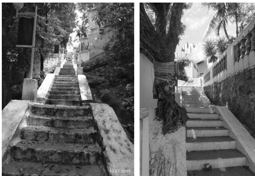
Figura 41 – Escadarias nas circulações principais, delimitadas por barreiras como muro de arrimo e talude que acompanham a topografia. Da esquerda para a direita: Ilê Axé Oxumarê (BA) e Casa Branca (BA).
