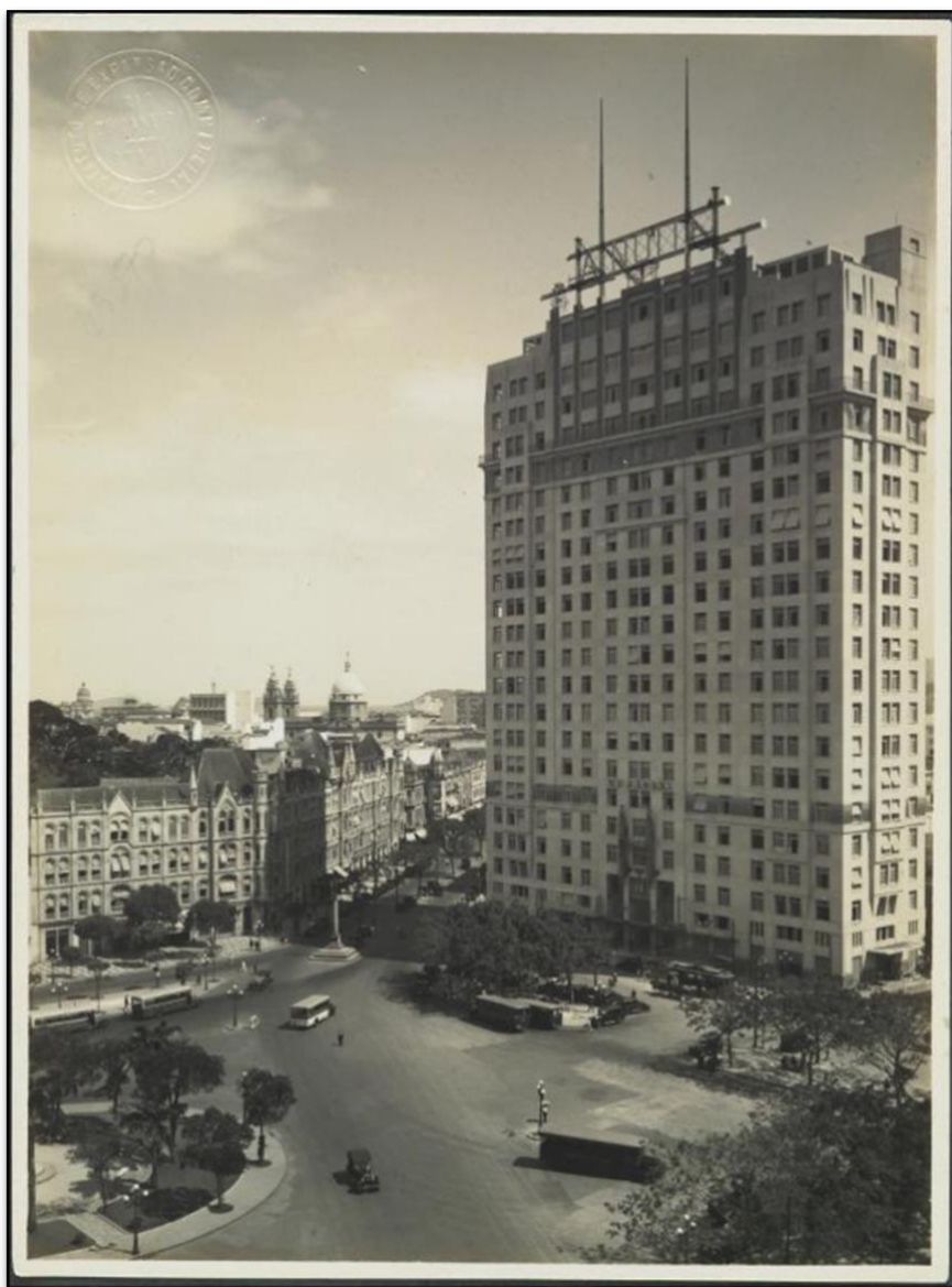
Figura 8: Edifício A Noite, Praça Mauá, Rio de Janeiro, [ca. 1929–1930]. Fonte: Brasiliana Fotográfica [s.d.].
