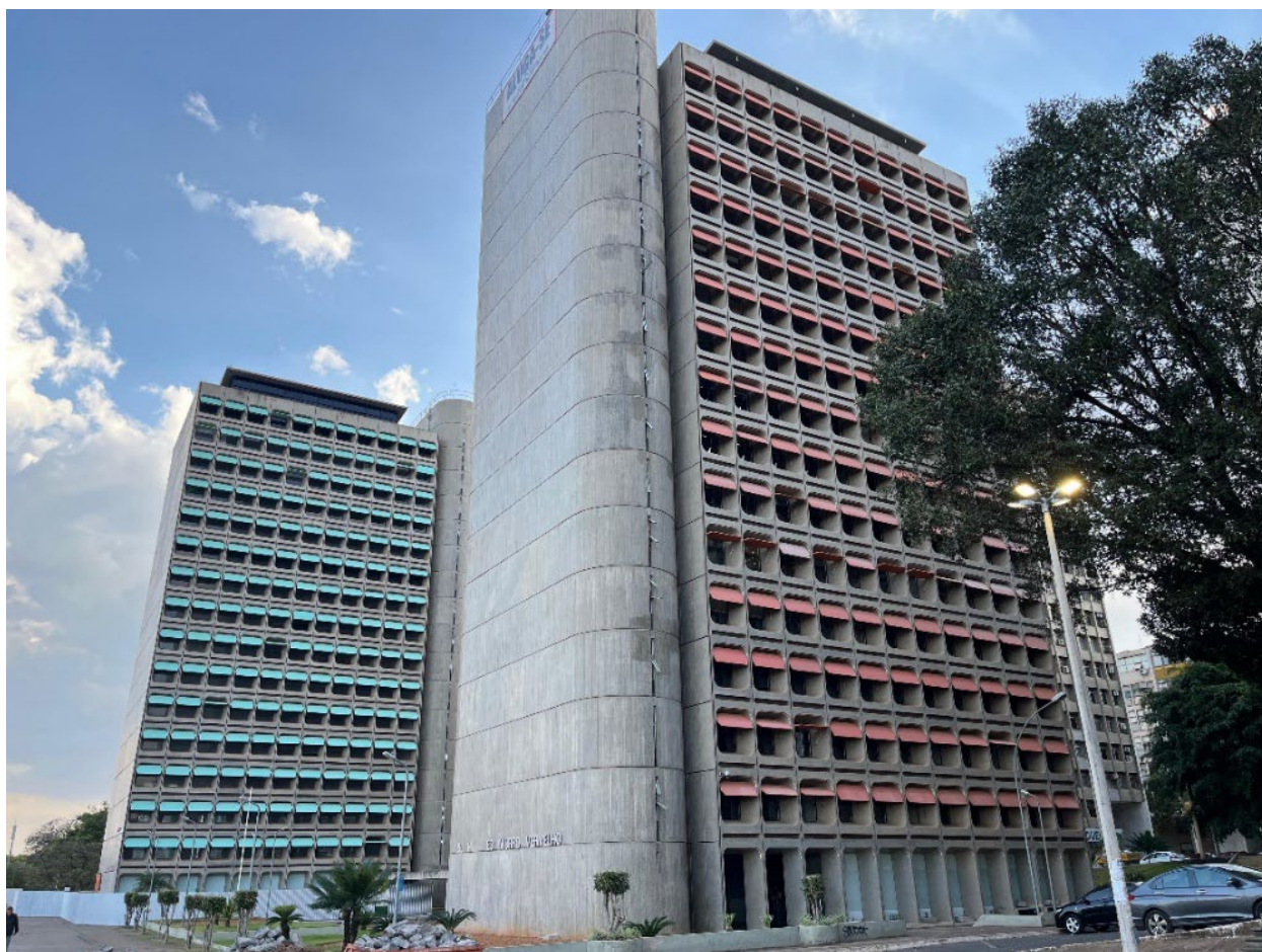
Figura 9. Edifícios Camargo Corrêa e Morro Vermelho. Foto da autora, 2025.
