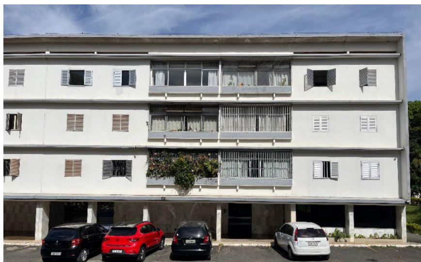
Figura 5. Edifício R2. Foto da autora, 2025.
