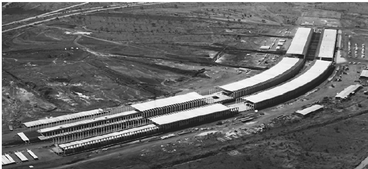
Figura 2. ICC em construção – ATOM/UnB.
