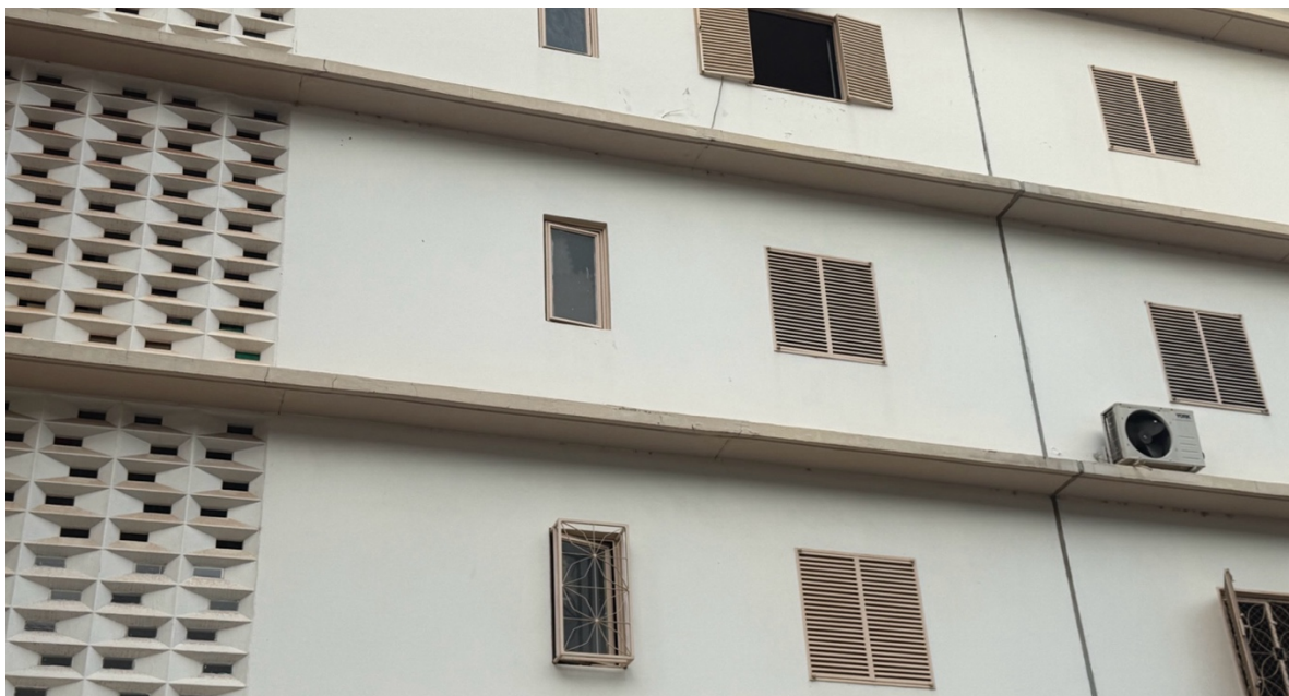
Figura 84 – Ampliação da fachada de um R2 70, com as juntas entre placas visíveis. Foto: autoria própria, 2026.
