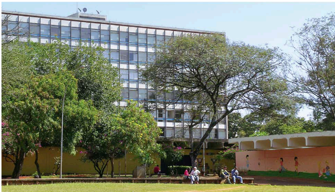
Figura 81 – Bloco de superquadra da SQN 302. Foto: Marcílio M. Ferreira, 2009.
