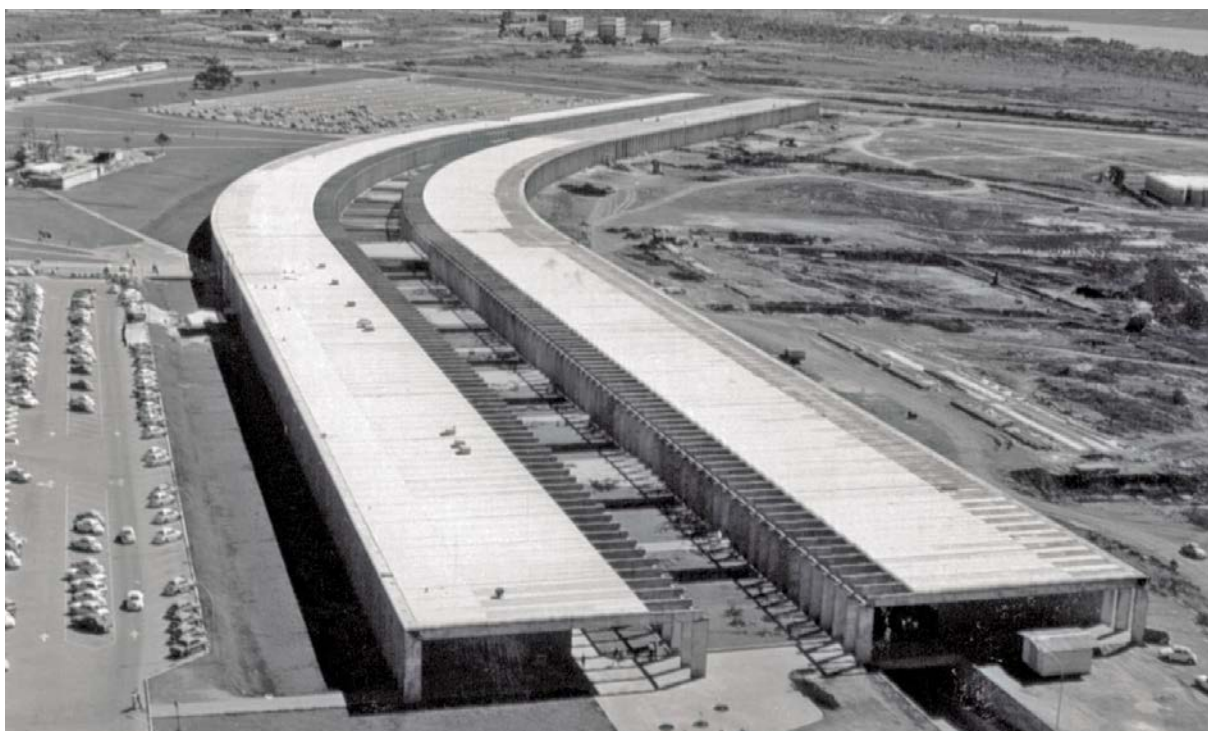
Figura 3 – Edifício do Instituto Central de Ciências (ICC). Autoria desconhecida, 1972. Fonte: Arquivo Público do Distrito Federal.
