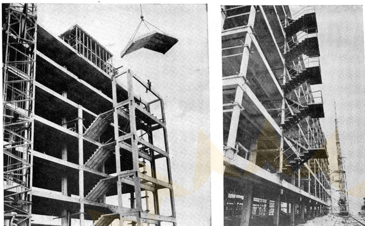
Figura 8 – Construção do Crusp, com peças pré-fabricadas. Foto: Revista Acrópole - ano 26, n. 303, 1964, p. 101.
