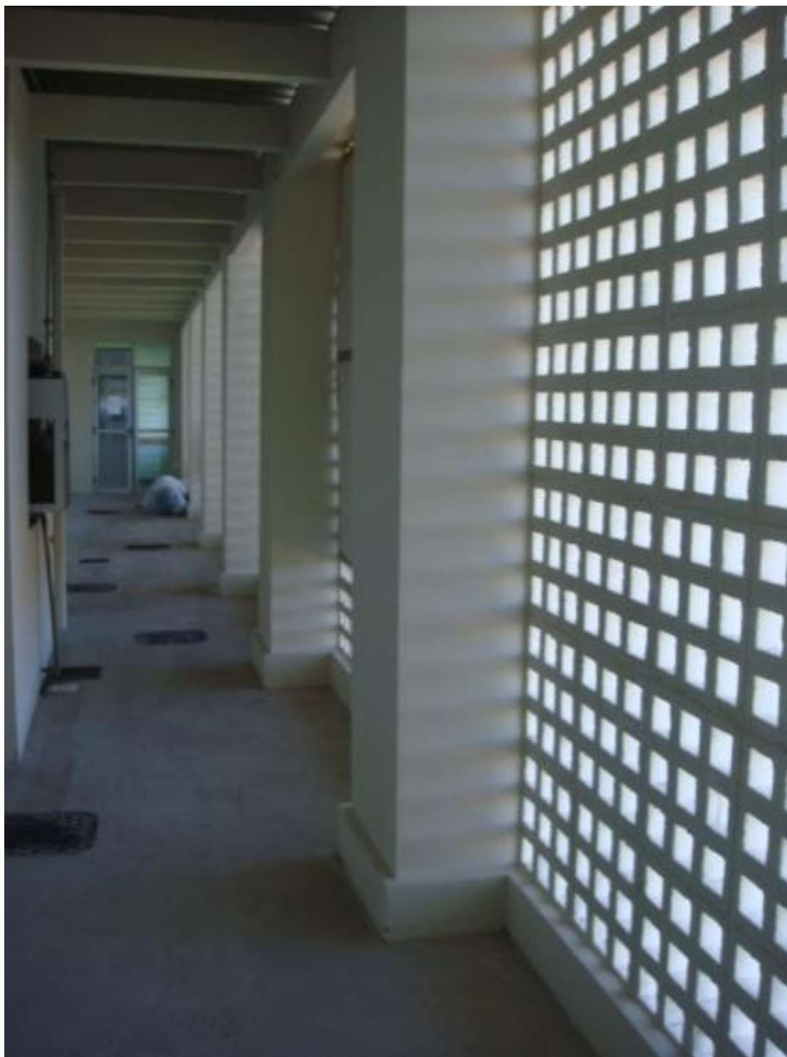
Figura 13: Detalhe de emprego de cobogós no HRPa.
