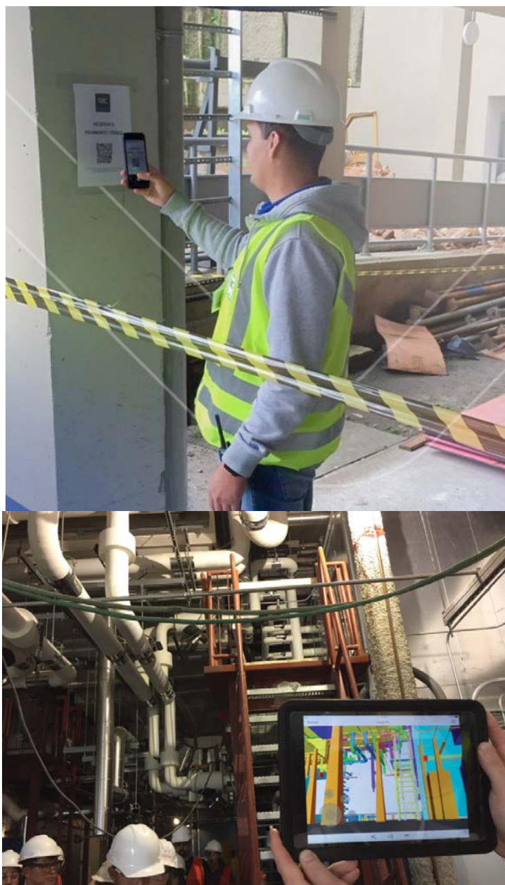
Figura 1 - Colaborador da RAC Engenharia utilizando o QR Code em obra e, à esquerda, imagem disponibilizada por (LEITE, 2019) demonstrando a utilização do modelo BIM para visualização 3D da obra.
