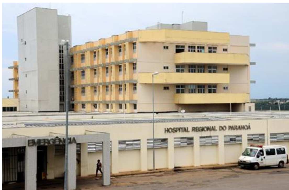
Figura 5: Hospital Regional do Paranoá.
