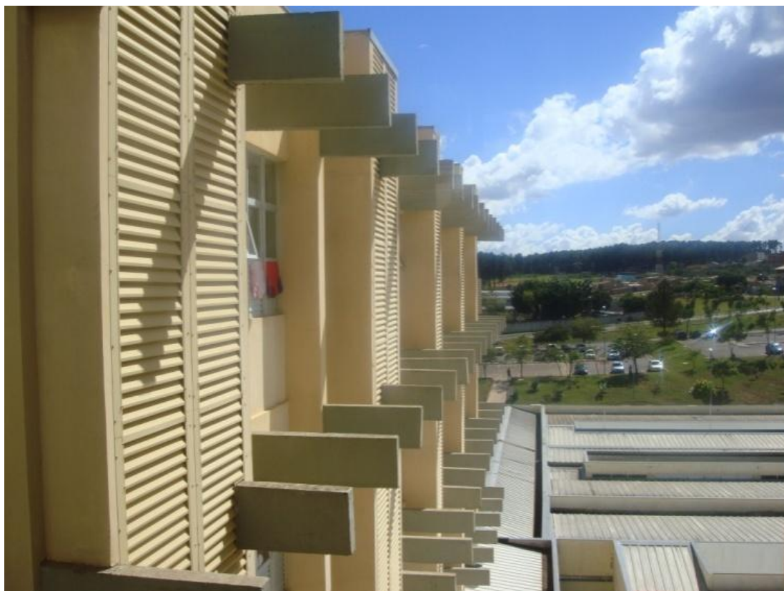
Figura 9: Detalhe dos Brises na fachada oeste da Unidade de Internação.
