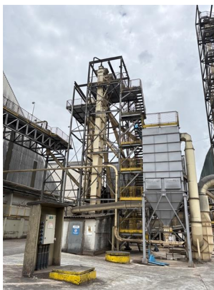
Figura 41. Vista do armazém de milho e sistema de despoeiramento
