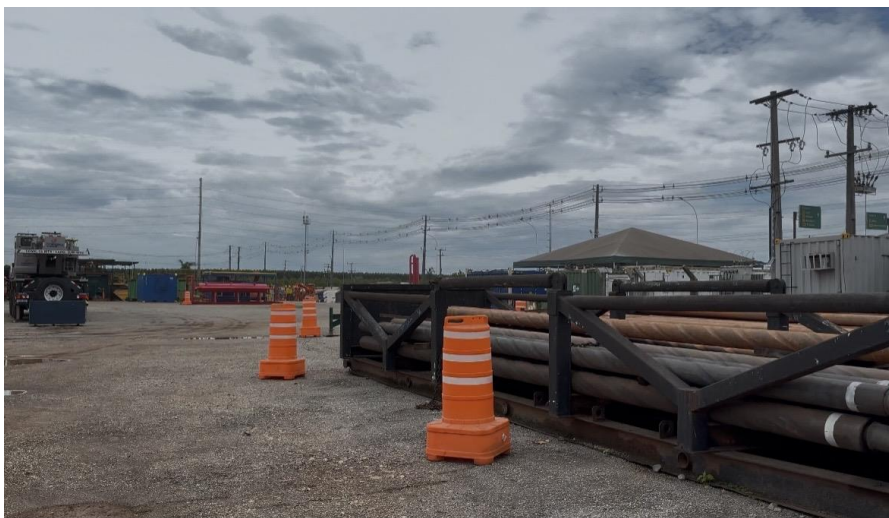
Figura 49. Tubulação da sonda de perfuração aguardando montagem
