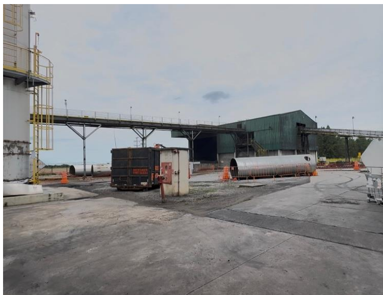
Figura 45. Galpão de cinzas da usina termelétrica a biomassa
