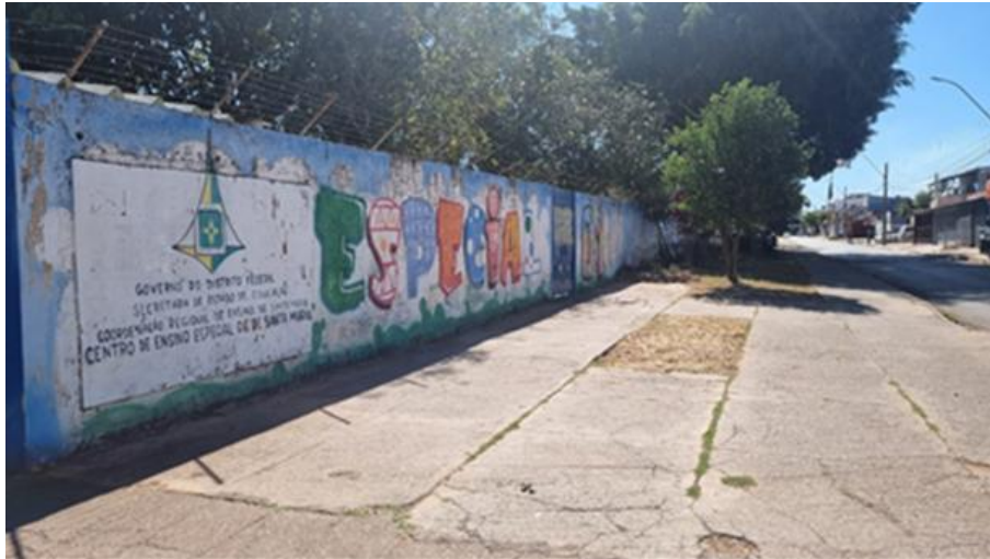
Figura 2 - Fachada do muro da escola
