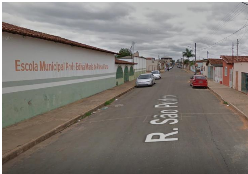
Figura 2 - Fachada do muro da escola
