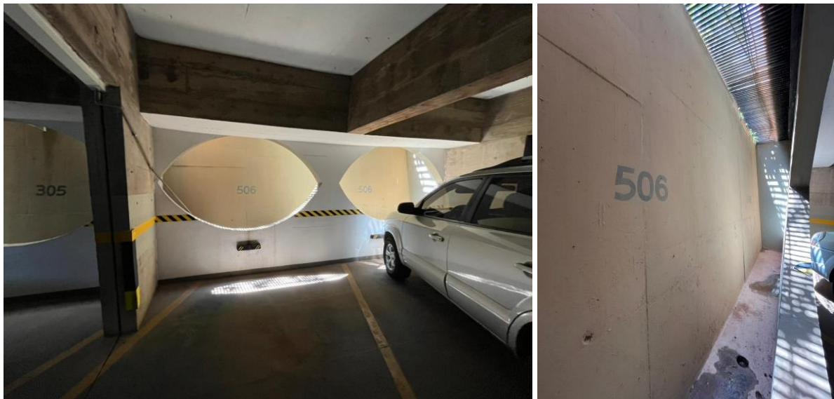
Figura 107 – À esquerda: Aberturas para entrada de luz e ventilação naturais na garagem. À direita: Detalhe da grelha e do ralo. Fonte: da autora.
