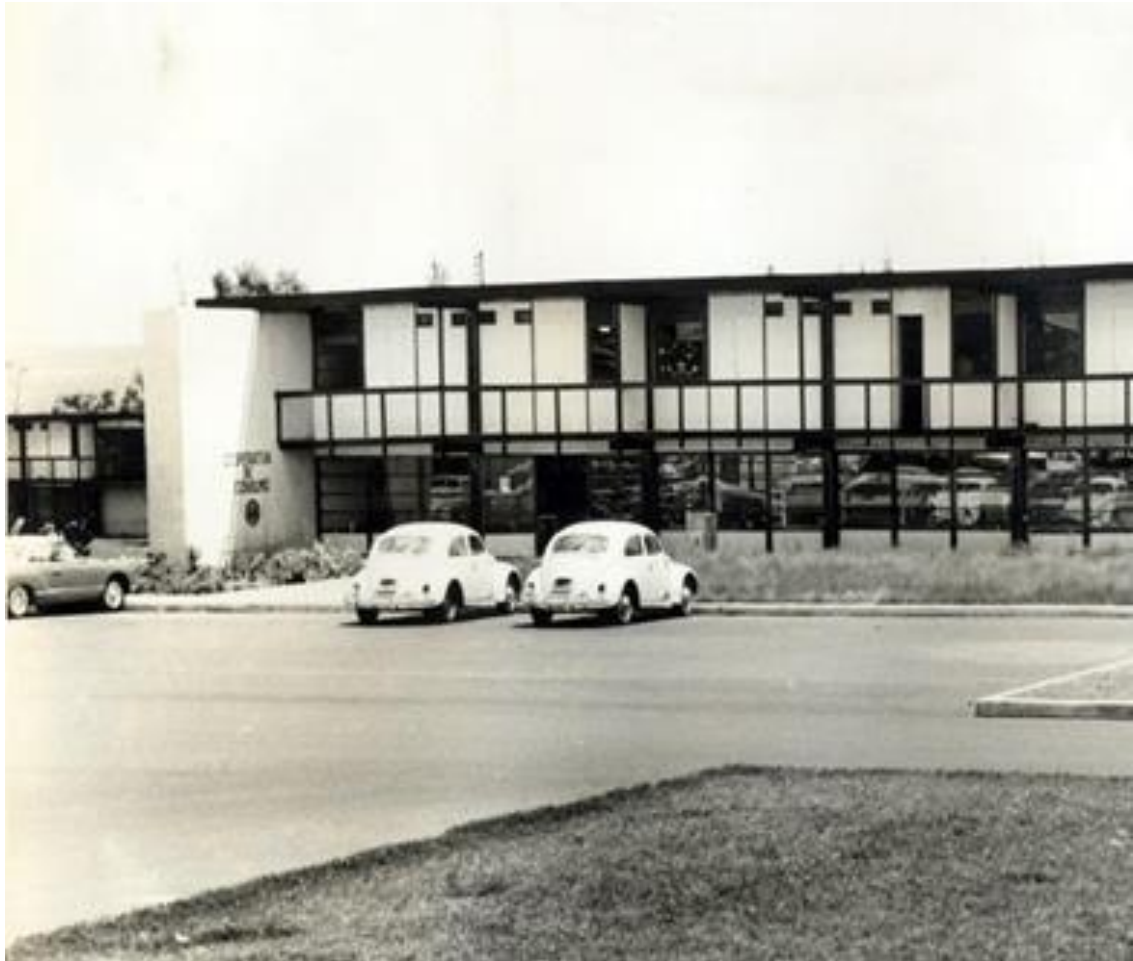
Figura 17 - Foto dos edifícios OCAI e OCAI em 1962I. Fonte: Cedoc / UnB
