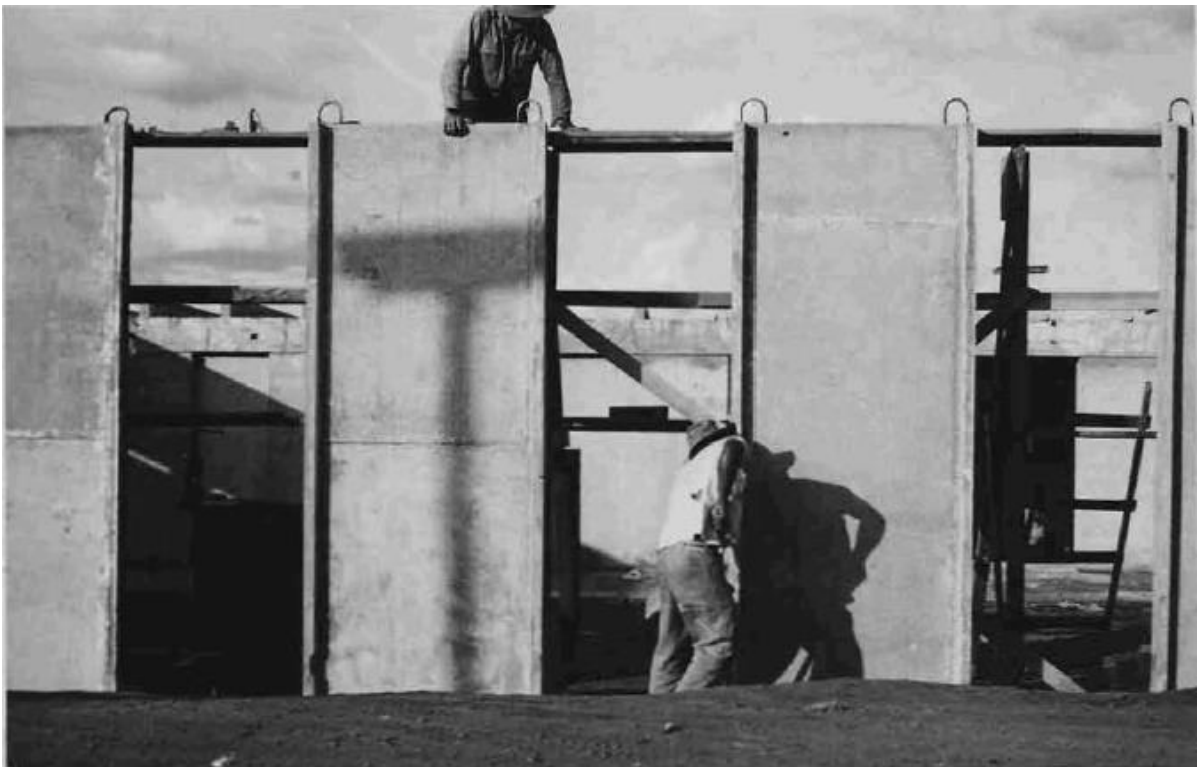
Figura 18 - Montagem dos painéis paredes na construção do SG1 (Instituto Central de Artes). Fonte: Pessina (1964, p.58).
