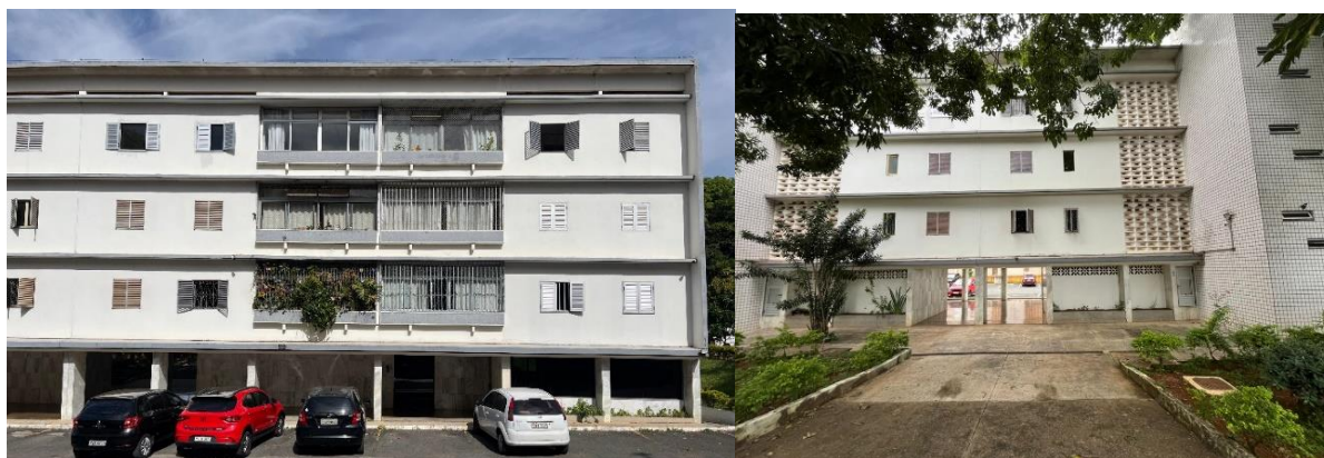
Figura 77 - Frente e fundos do bloco R2 (bloco H da SQS 416). Fonte: da autora (2025).
