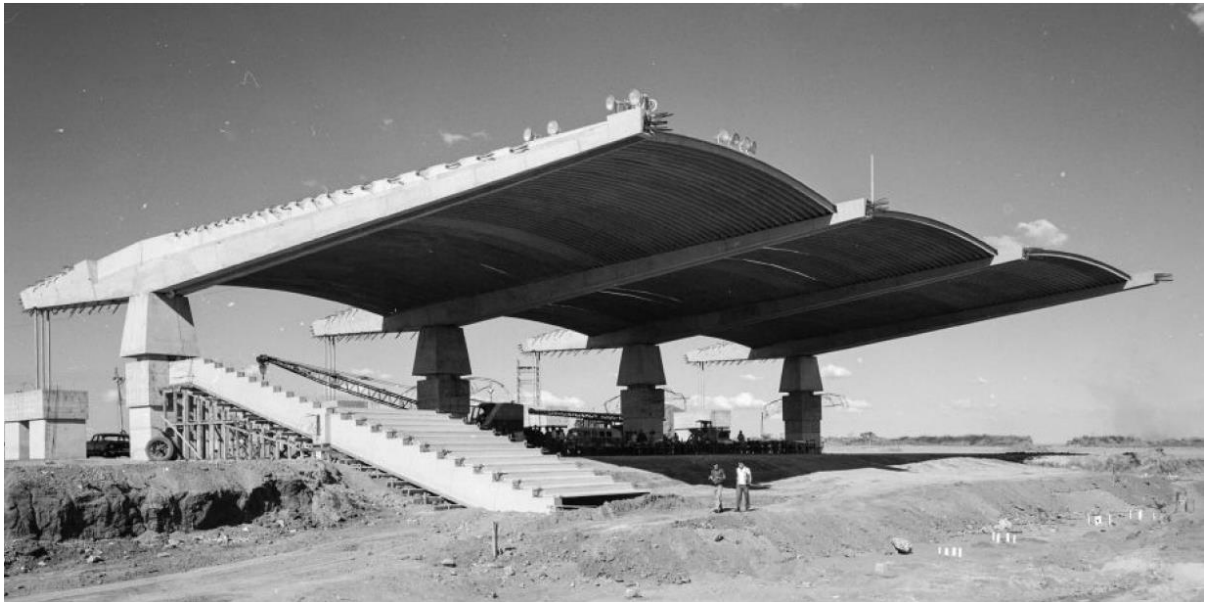
Figura 42 - Construção de módulos da arquibancada do estádio. Fonte: Instituto Moreira Sales (IMS).
