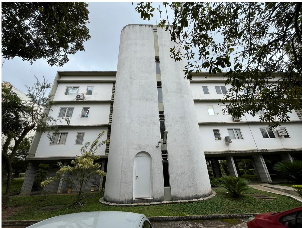
Figura 82 - Detalhe da caixa da escada do bloco de modelo R2-72. Fonte: da autora.
