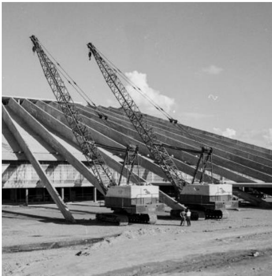
Figura 15 - Construção do Teatro Nacional. Operação das duas gruas da Rabello. Fonte: Instituto Moreira Salles. Foto de Marcel Gautherot.
