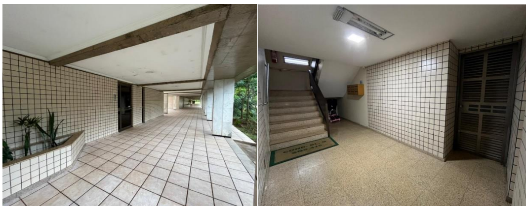
Figura 73 - Pilotis do térreo e porta de acesso ao depósito e armários hidráulicos do R2 - bloco G da SQS 416. Fonte: da autora.
