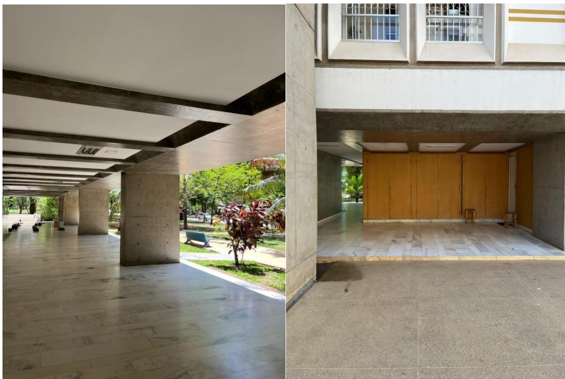
Figura 103 – À esquerda: Pilotis do térreo do R3. À direita: Foto dos armários hidráulicos no térreo. Fonte: da autora.
