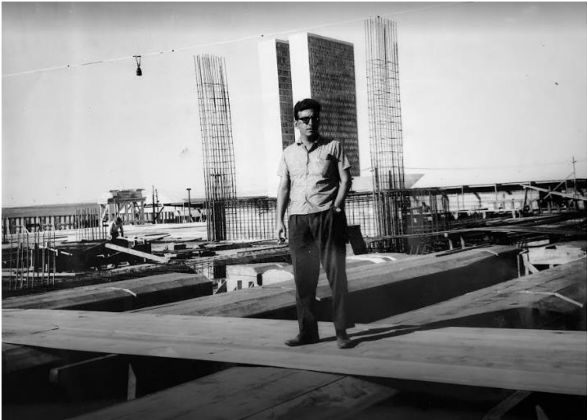
Figura 38 - Milton Ramos no canteiro de obras do Palácio do Itamaraty – Fonte: Acervo do Arquiteto Milton Ramos.
