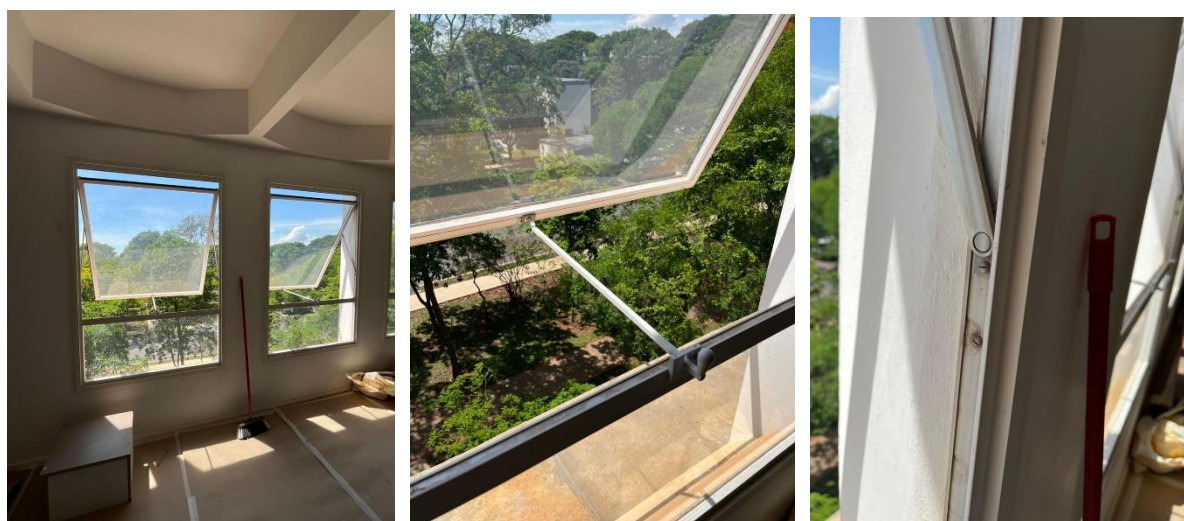
Figura 96 - À esquerda: Janelas da sala no R3. No centro: Detalhe da abertura da janela. À direita: Detalhe do chumbamento da esquadria. Fonte: da autora.
