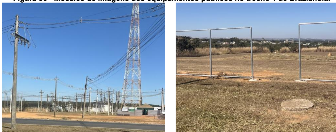
Figura 36 - Mosaico de imagens dos equipamentos públicos no trecho 1 de Brazlândia.
