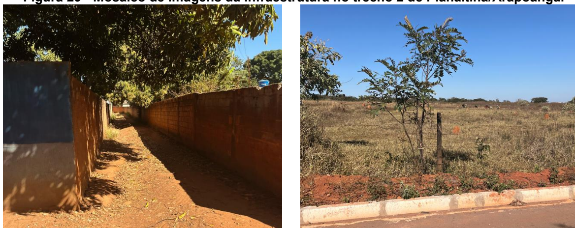
Figura 29 - Mosaico de imagens da infraestrutura no trecho 2 de Planaltina/Arapoanga.
