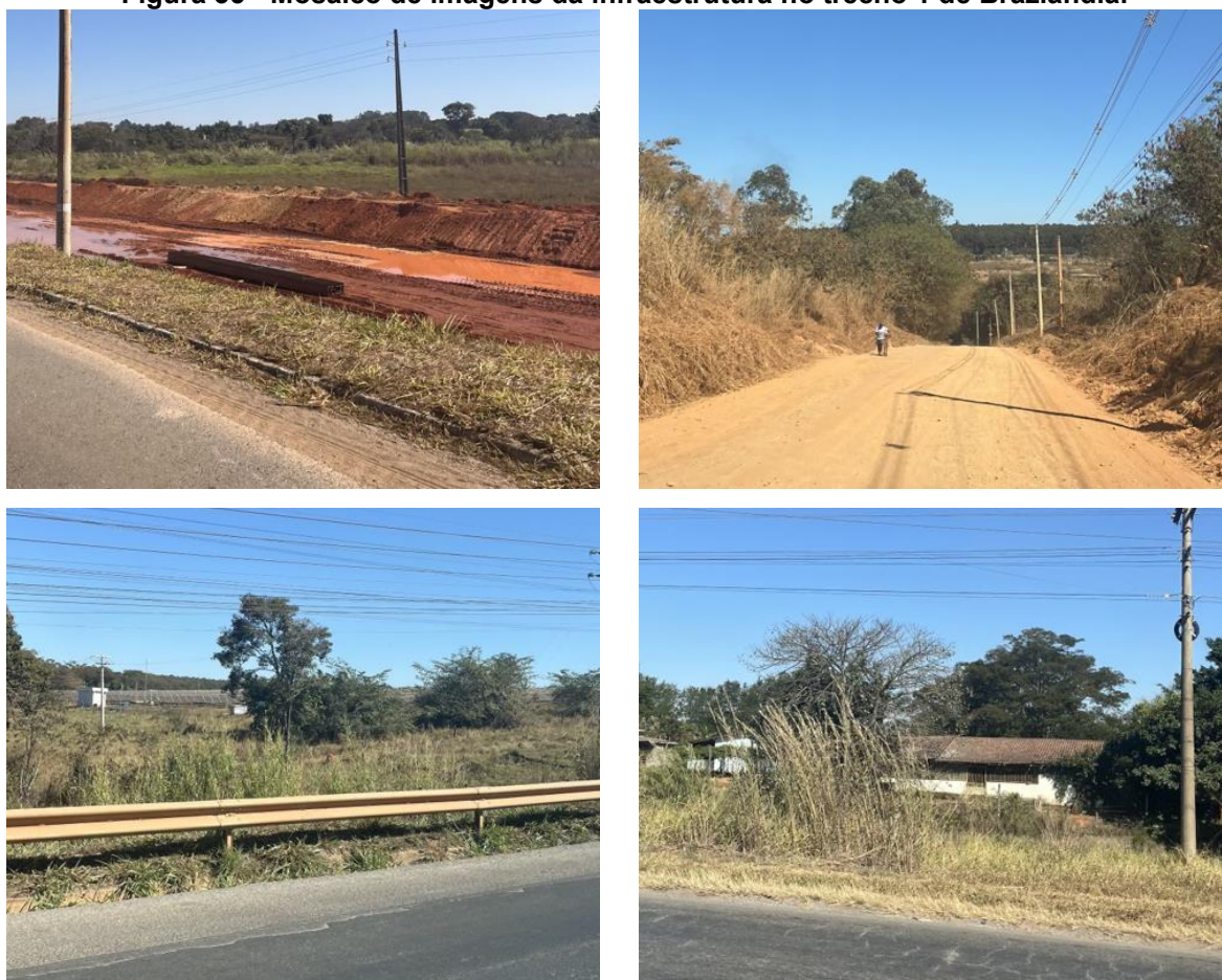
Figura 35 - Mosaico de imagens da infraestrutura no trecho 1 de Brazlândia.
