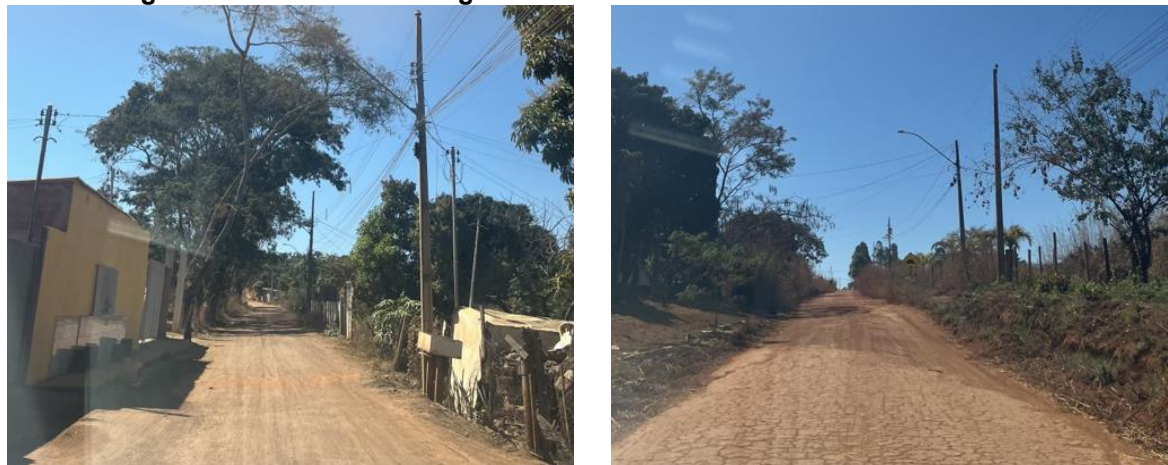
Figura 40 - Mosaico de imagens da infraestrutura no trecho 2 de Brazlândia.
