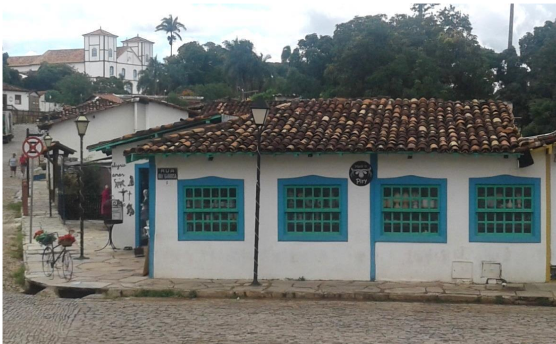
Figura 69 – Trecho da Rua do Bonfim com Rui Barbosa
