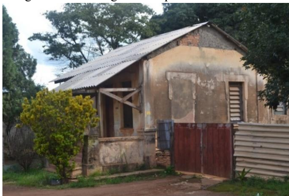
Figura 166 – Vestígios de arquitetura das ferrovias
