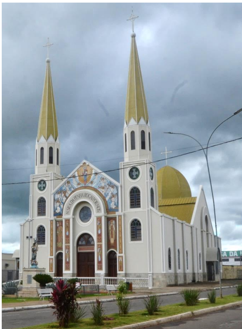
Figura 101 – Igreja Matriz N. S. da Penha, Composição da fachada
