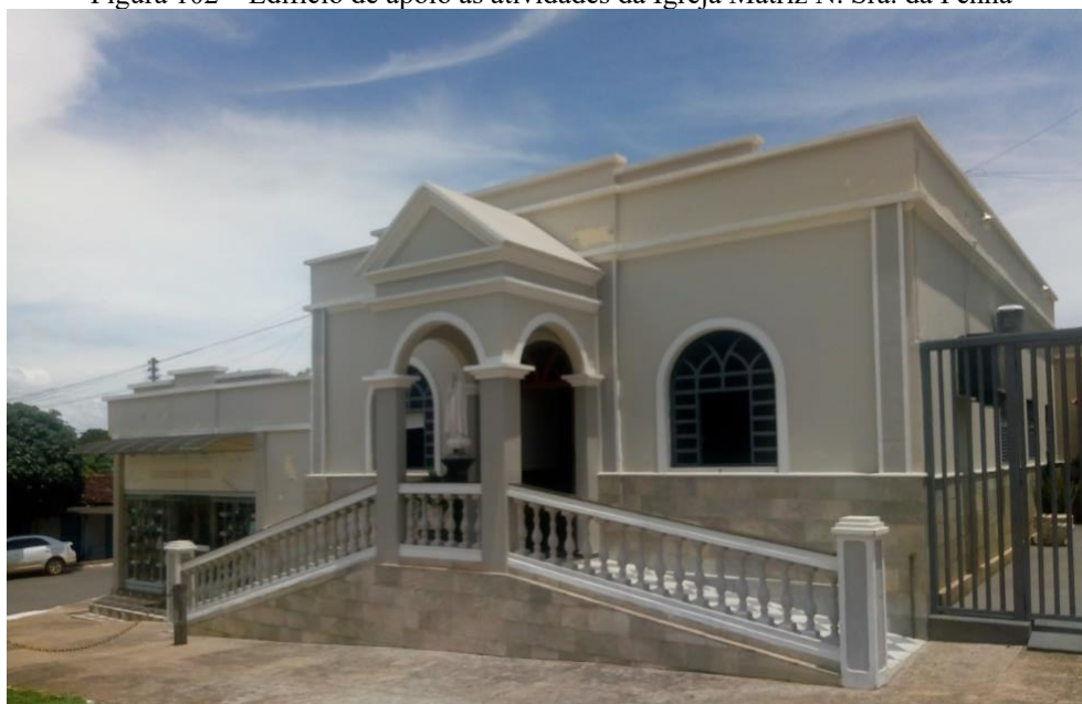
Figura 102 – Edifício de apoio às atividades da Igreja Matriz N. Sra. da Penha
