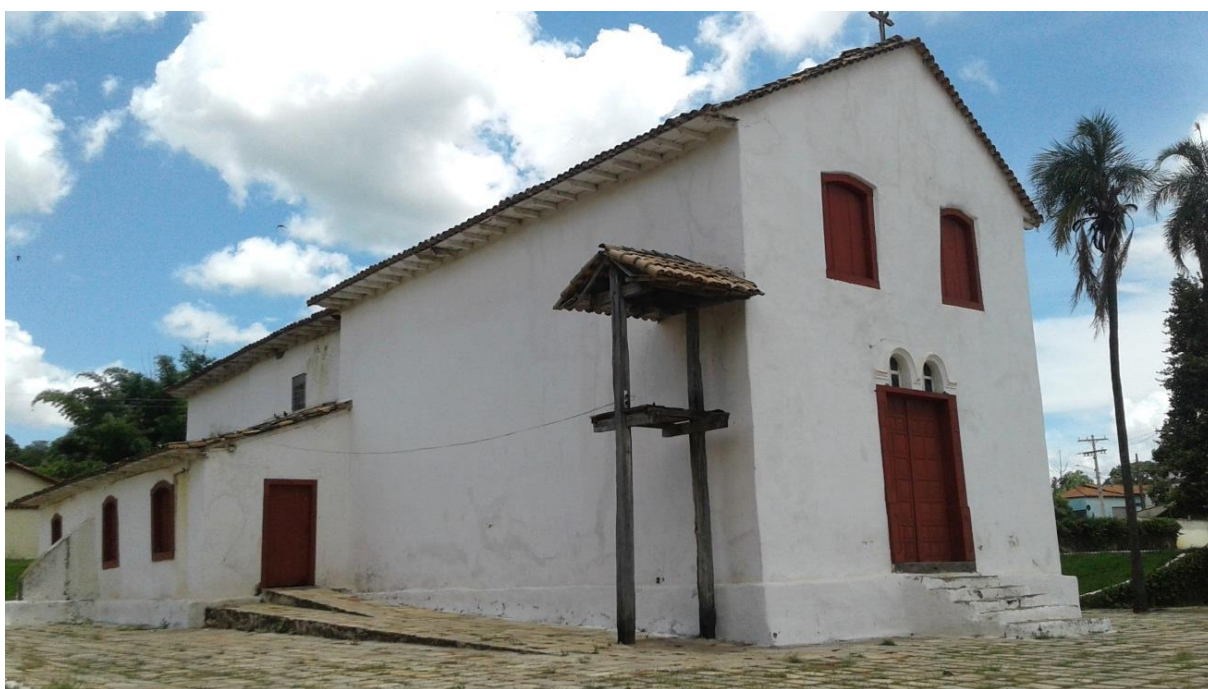
Figura 116 – Igreja de Nossa Senhora do Rosário dos Pretos
