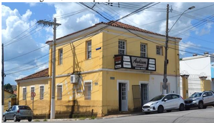
Figura 251 – Composição Geral do edifício
