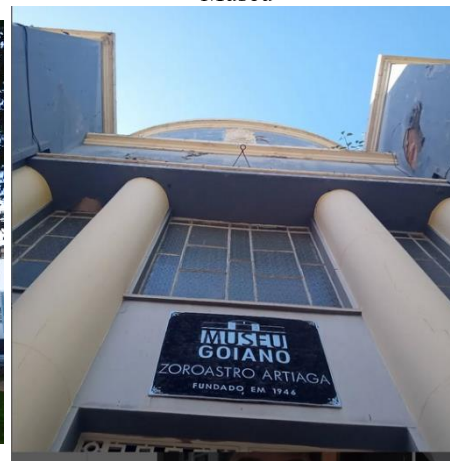
Figura 280 – Elementos da fachada do Museu
