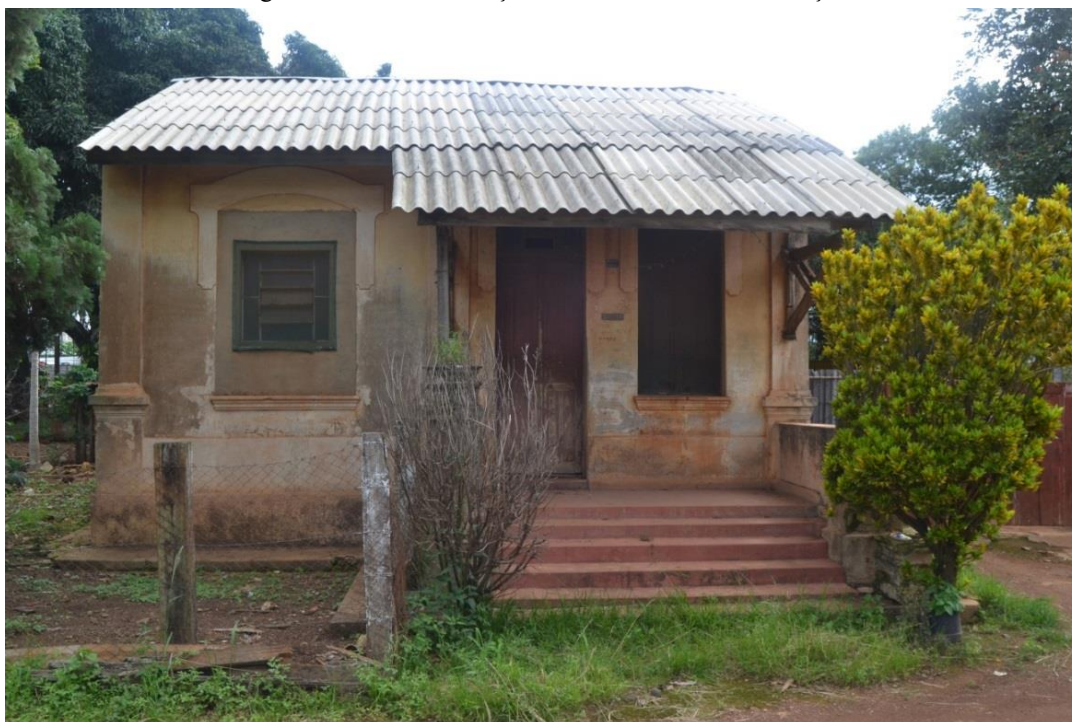
Figura 165 – Atual situação da Casa do Chefe da Estação
