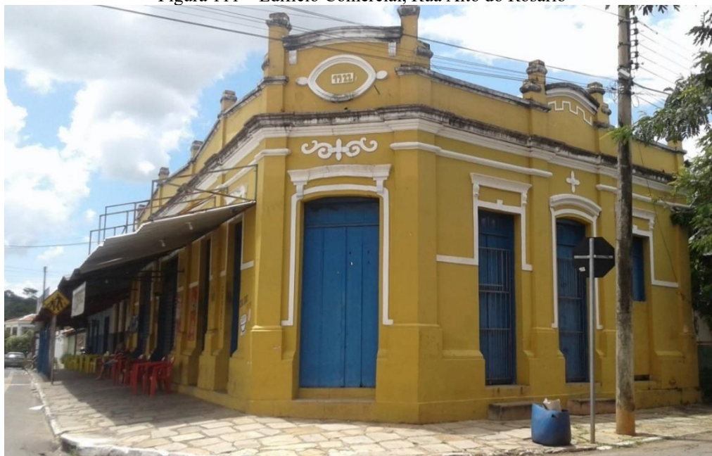
Figura 111 – Edifício Comercial, Rua Alto do Rosário
