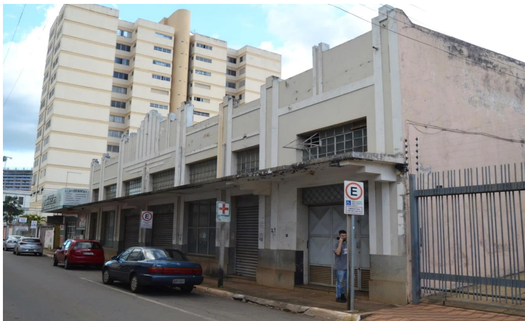
Figura 155 – Edifício com platibanda ornamentada – Rua Coronel Aquiles de Pina
