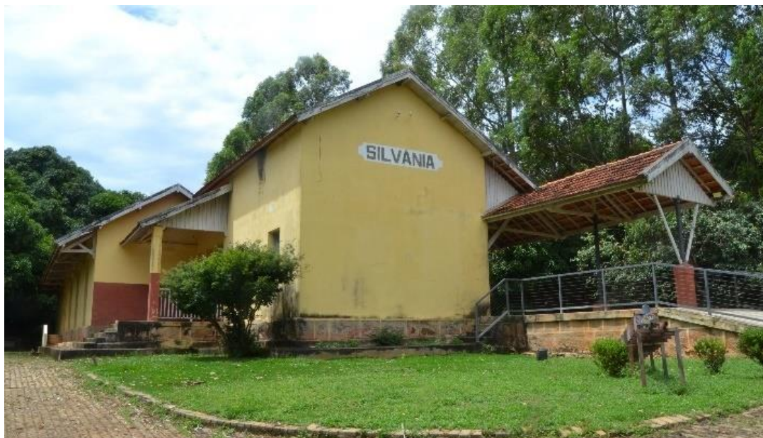
Figura 186 – Conjunto arquitetônico frontal
