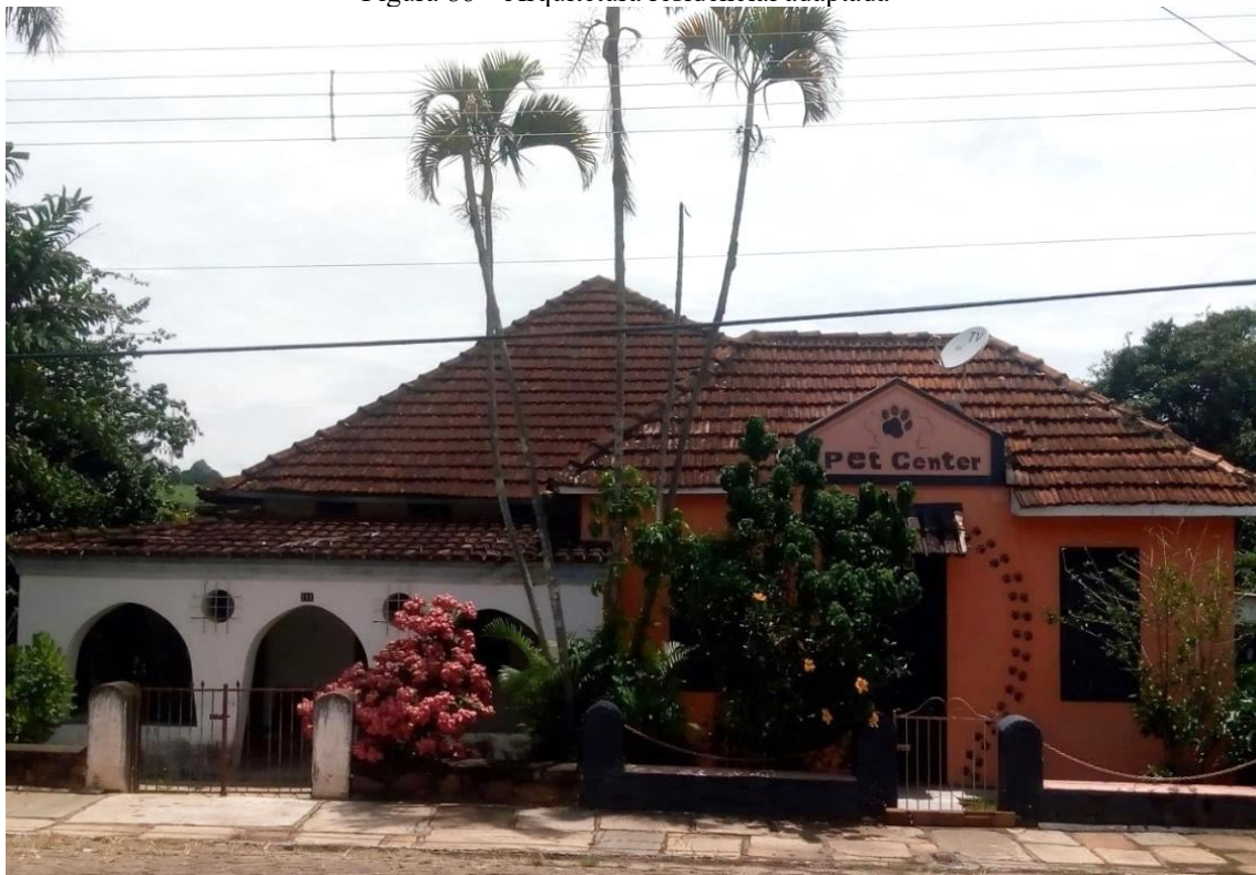
Figura 86 – Arquitetura residencial adaptada
