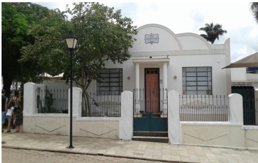
Figura 62 – Transformações, abandono do vernacular
