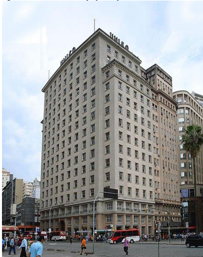
Figura 22 – Edifício União, projetado por Arnaldo Gladosch em 1940
