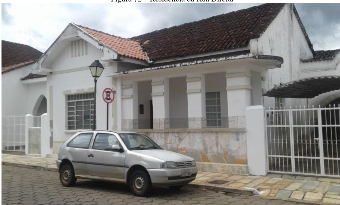
Figura 72 – Residência da Rua Direita
