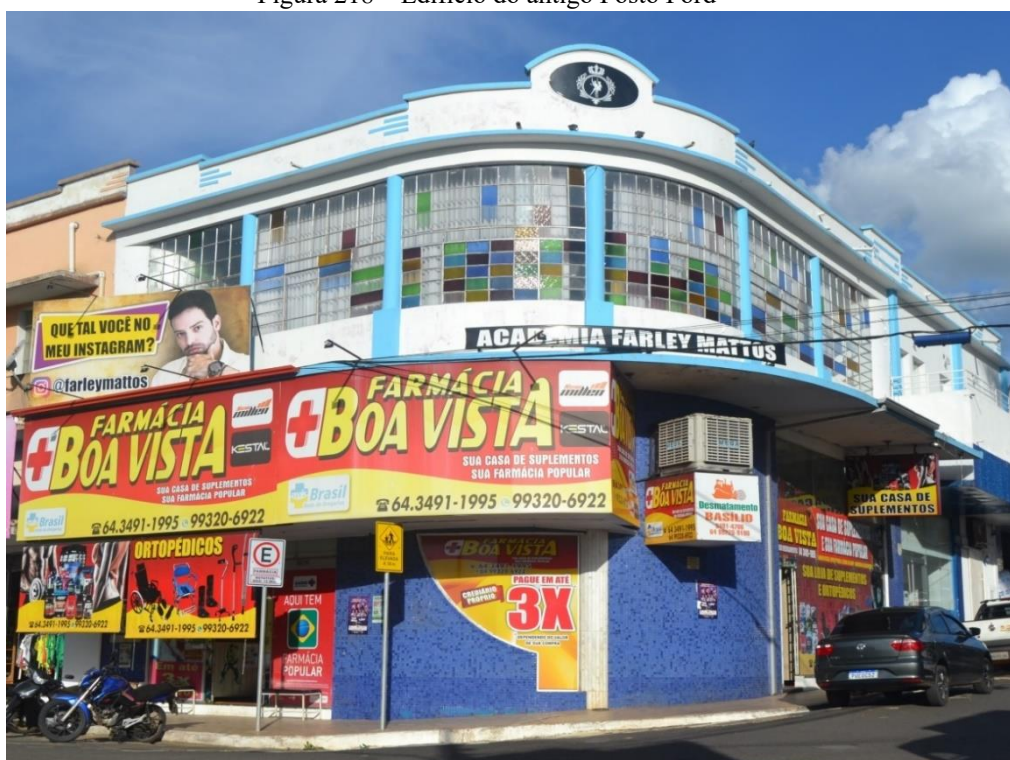
Figura 218 – Edifício do antigo Posto Ford
