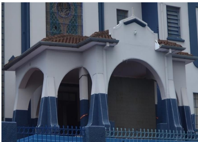
Figura 254 – Frontão, pilares e cobertura de área de acesso
