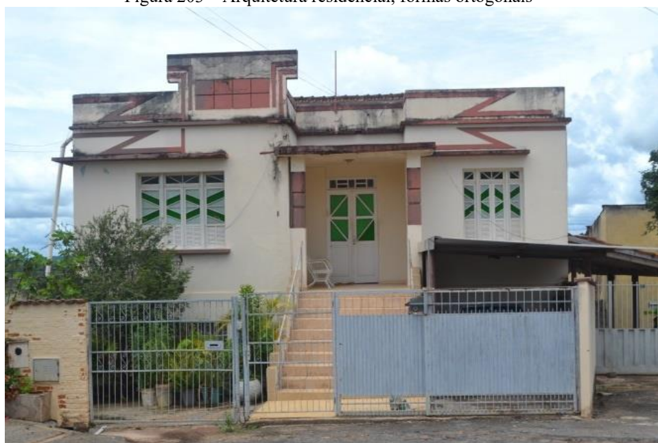
Figura 203 – Arquitetura residencial, formas ortogonais
