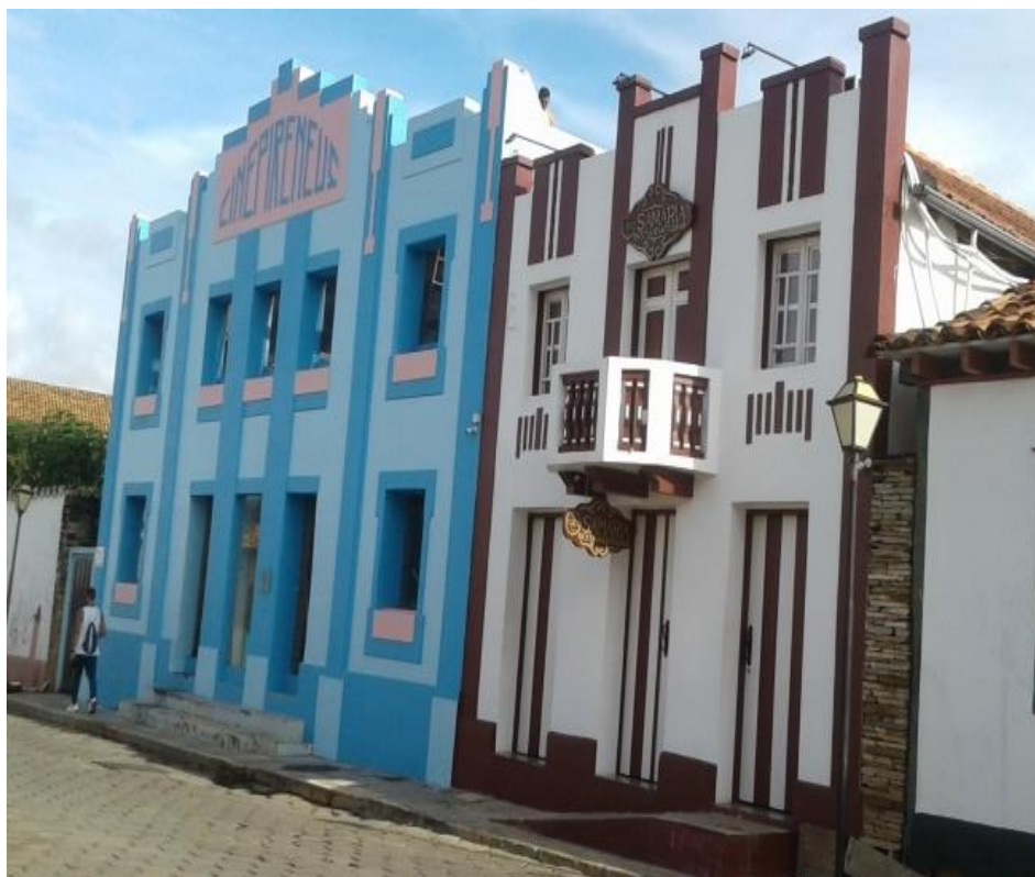
Figura 71 – Cineteatro Pireneus e edifício vizinho, imagem atual
