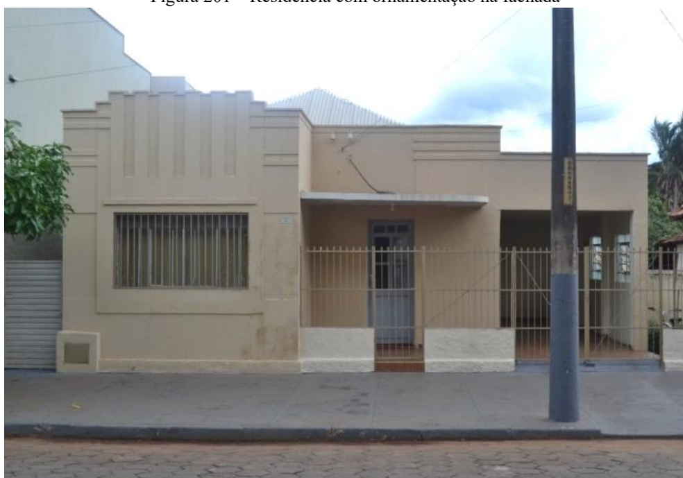
Figura 201 – Residência com ornamentação na fachada
