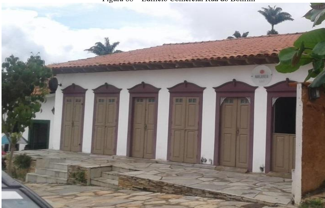
Figura 68 – Edifício Comercial Rua do Bonfim
