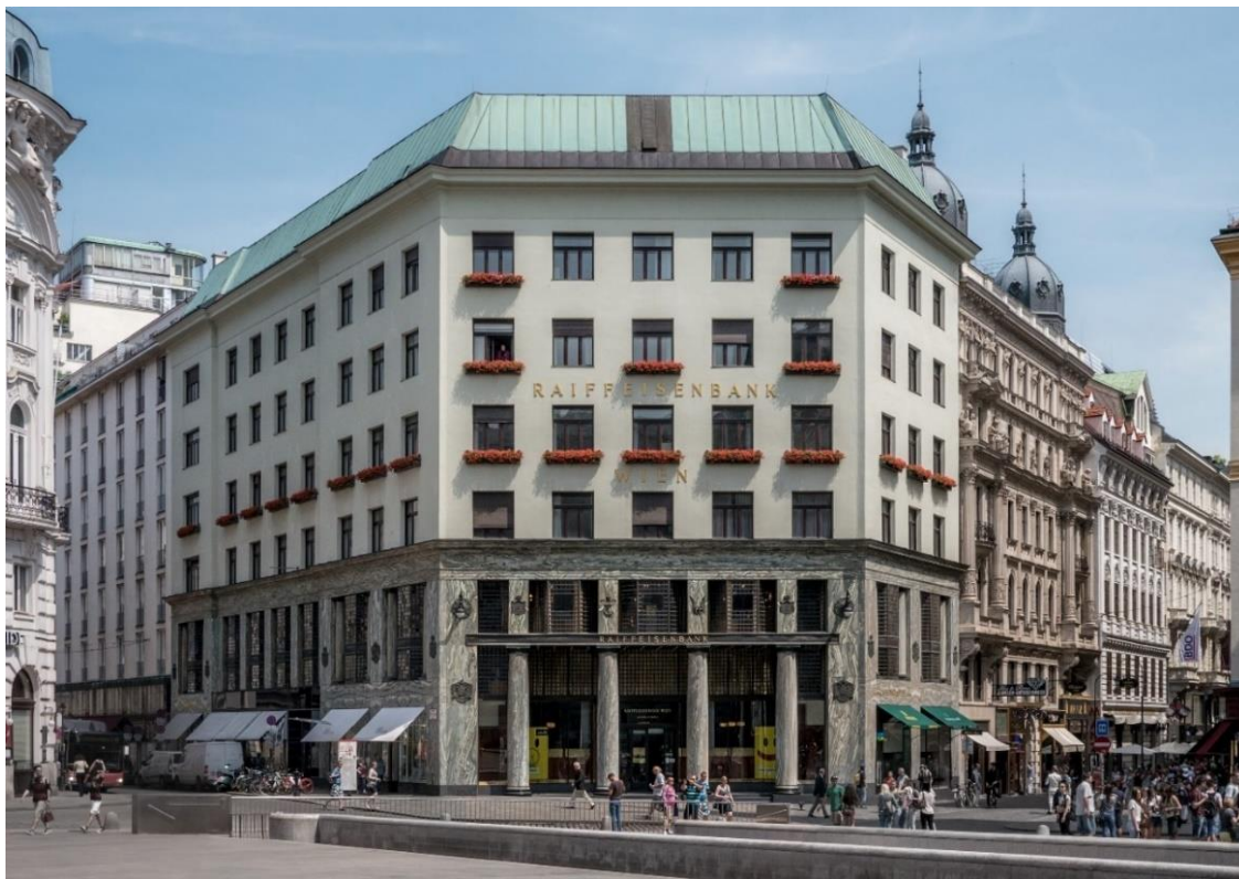
Figura 21 – Looshaus, projetado por Adolf Loos, entre 1909 e 1911
