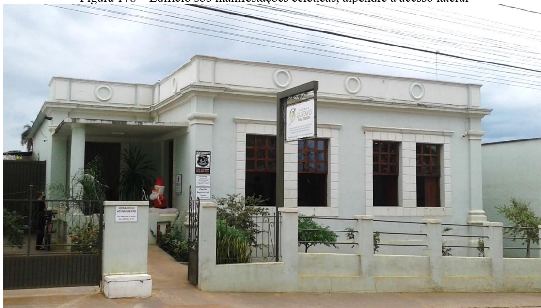
Figura 178 – Edifício sob manifestações ecléticas, alpendre a acesso lateral
