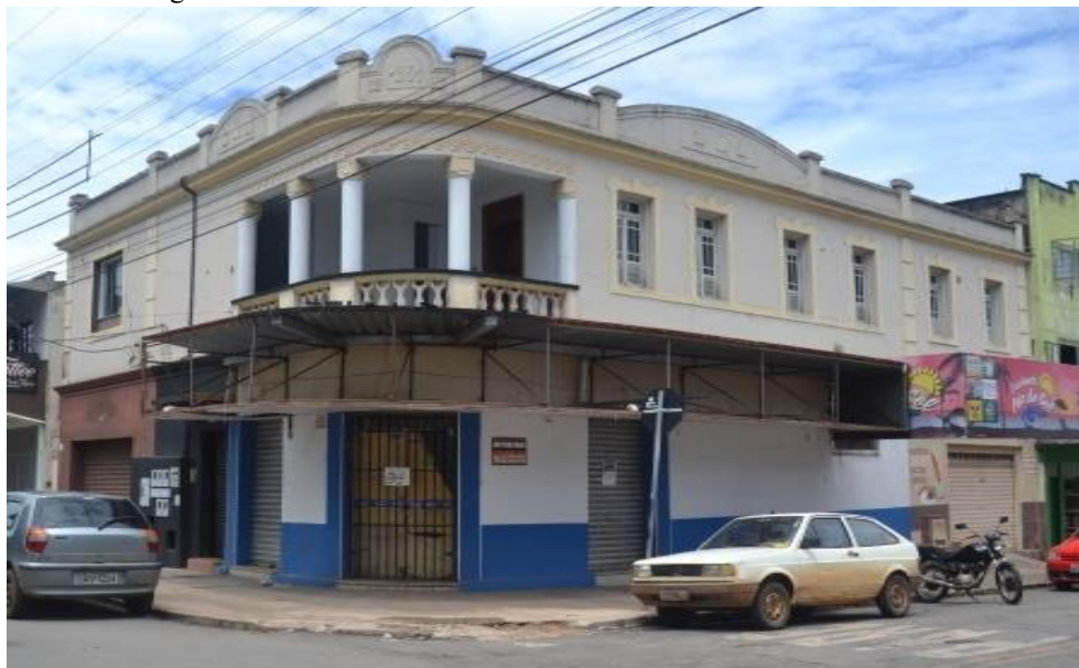
Figura 197 – Edifício com características ecléticas em Pires do Rio
