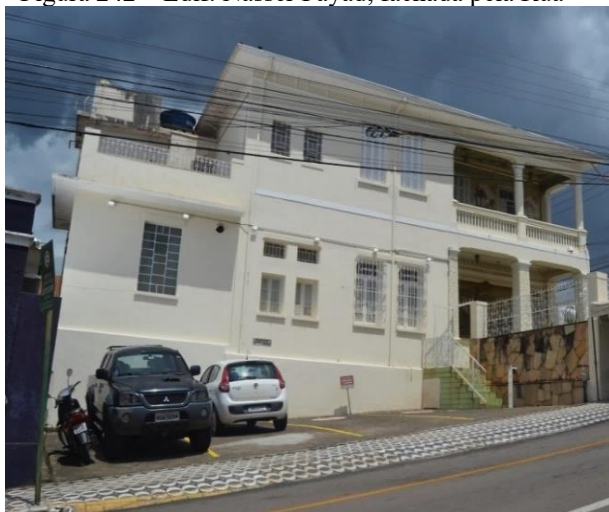
Figura 242 – Edif. Nasser Fayad, fachada pela Rua
