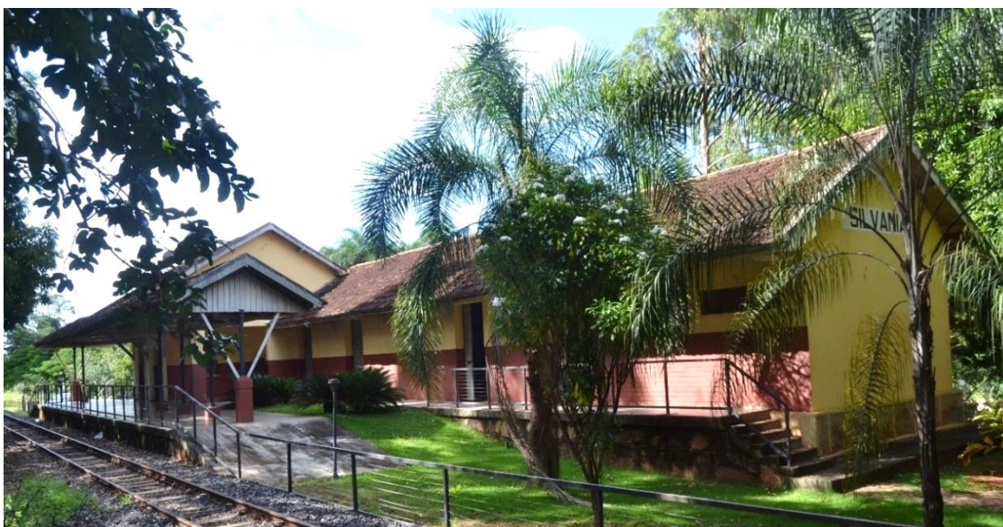
Figura 188 – Conjunto arquitetônico com vista lateral
