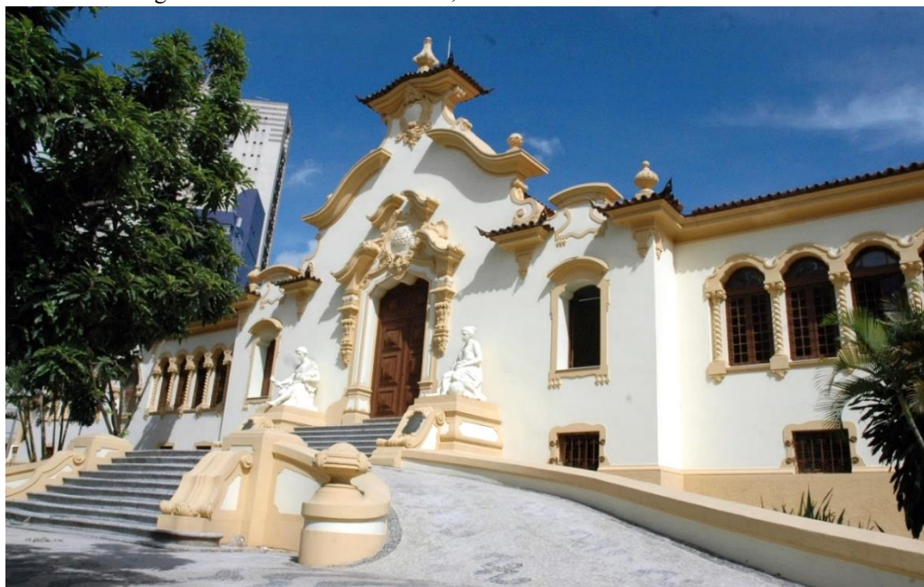
Figura 16 – Fachada neocolonial, Escola Pedro II – Belo Horizonte/MG
