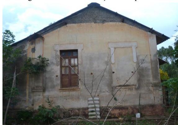
Figura 167 – Desconstrução da arquitetura
