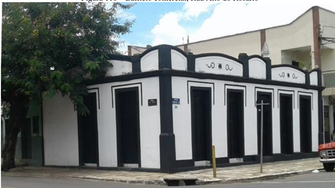
Figura 110 – Edifício comercial, Rua Alto do Rosário
