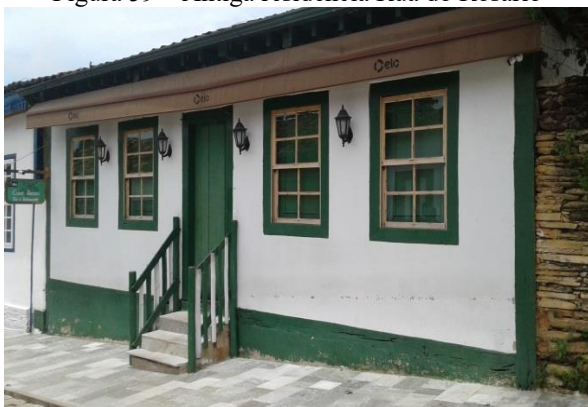
Figura 59 – Antiga residência Rua do Rosário
