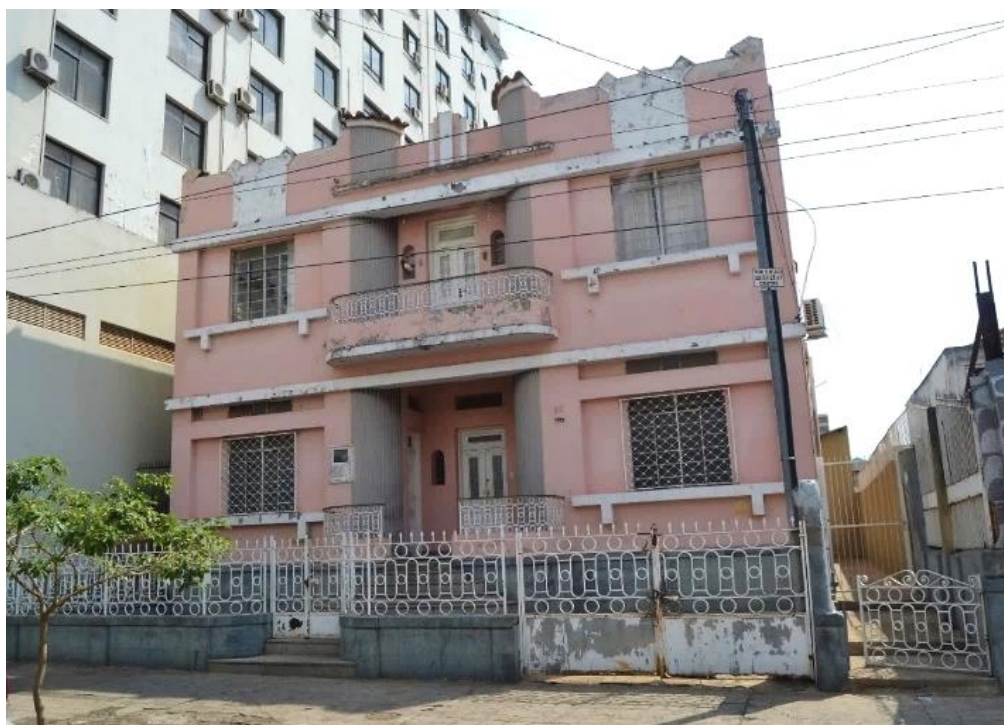
Figura 287 – Residência arquitetura eclética
