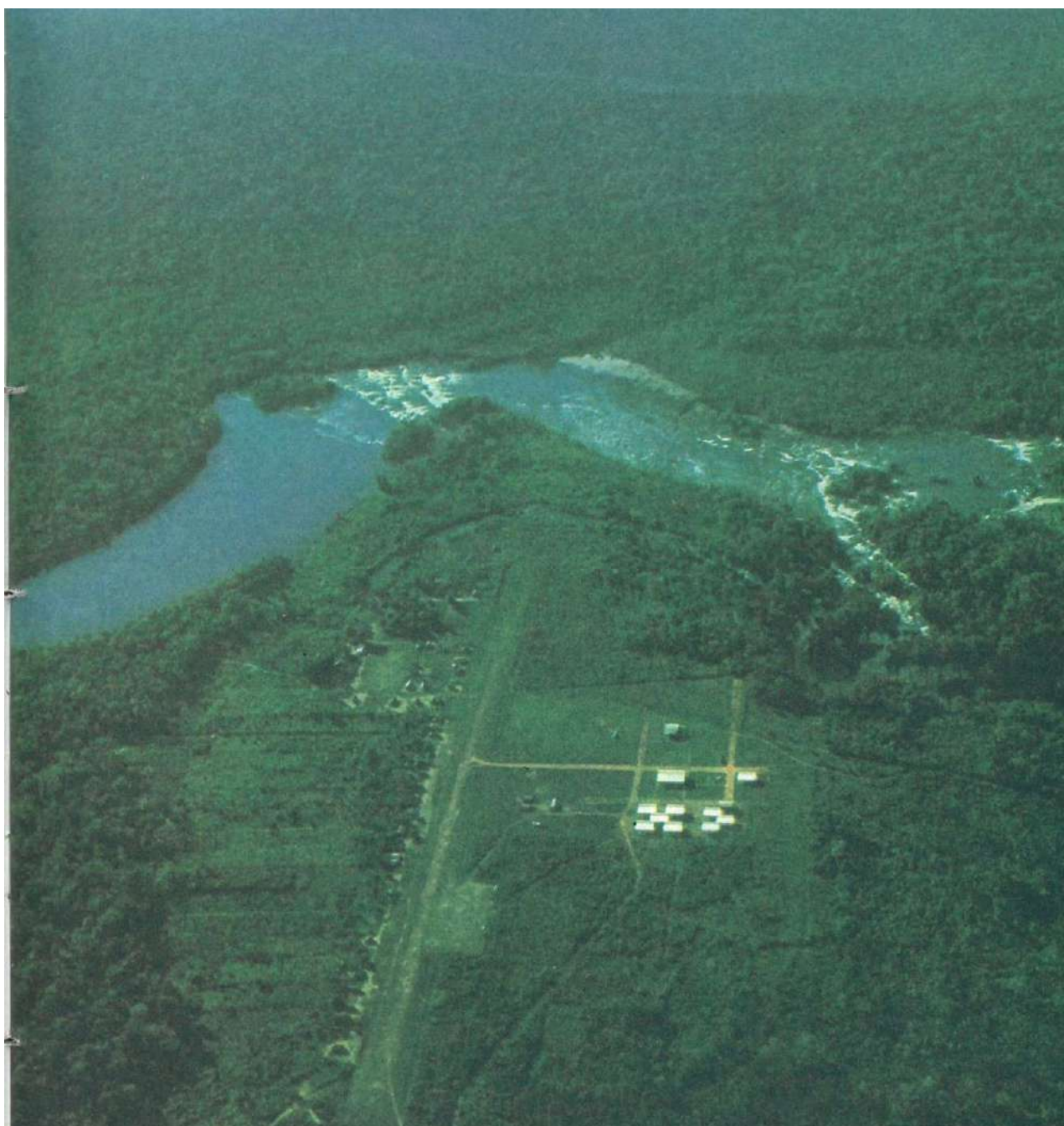
Figura 74 - Vista aérea da Cidade Científica, com pista de pouso e implantação das primeiras edificações. Fonte: Revista Planejamento & Desenvolvimento, v.2, n.15, set.1974, p. 44.
