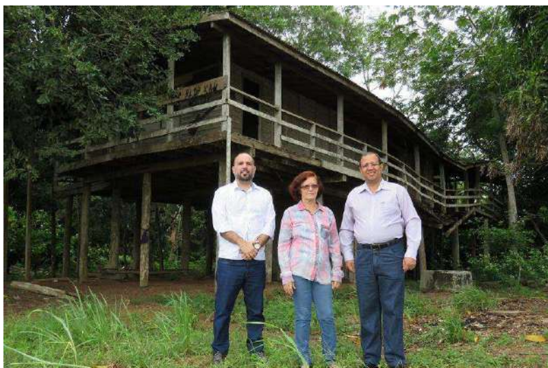
Figura 90 – Técnicos da Secretaria Estadual de Cultura do Mato Grosso em frente à ruína da única edificação em madeira remanescente da Cidade Científica de Humboldt, em 2016. Fonte: https://www.aripuana.mt.gov.br/imprensa/noticia/n-a/432 .
