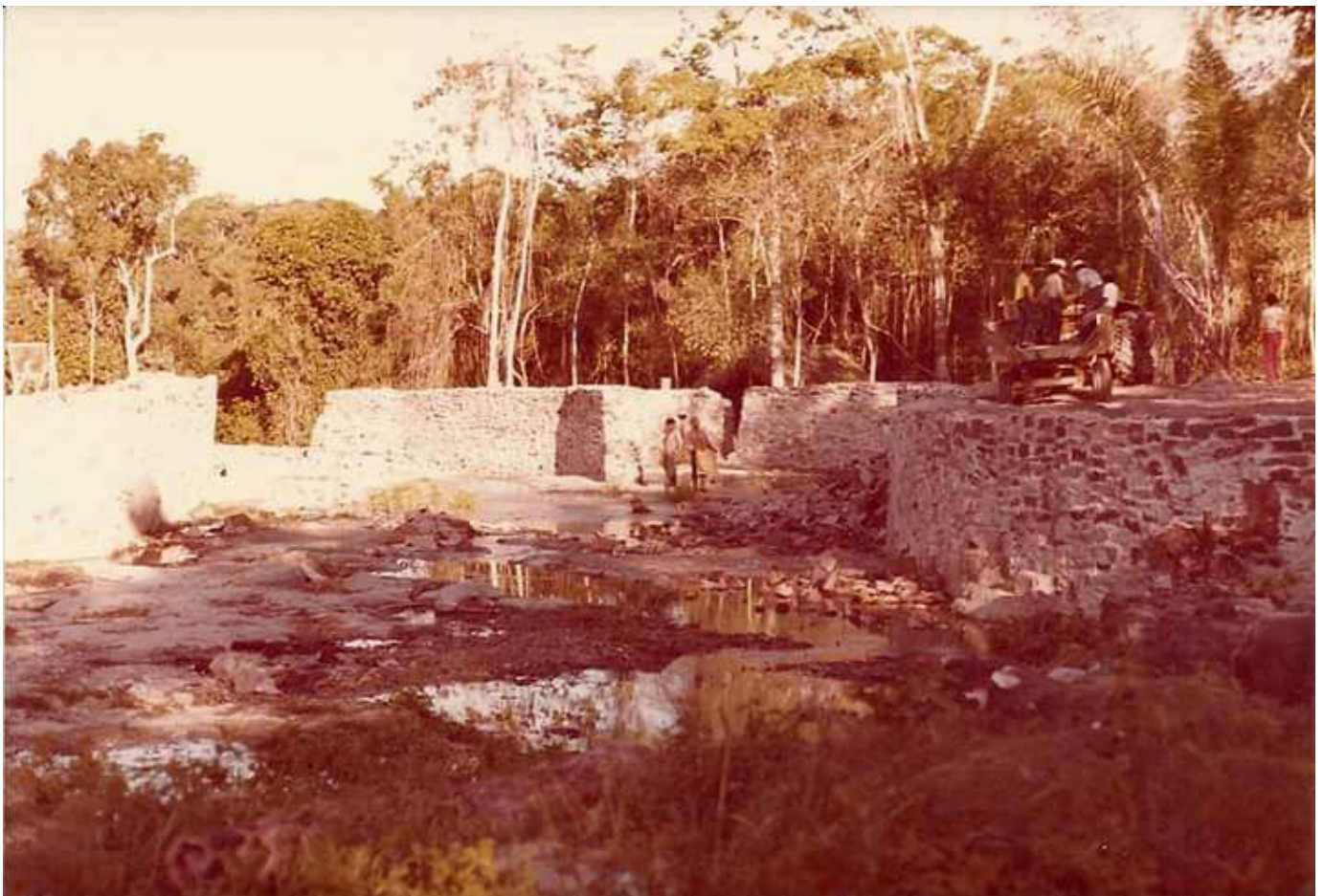
Construção de represa para o Projeto Humboldt
