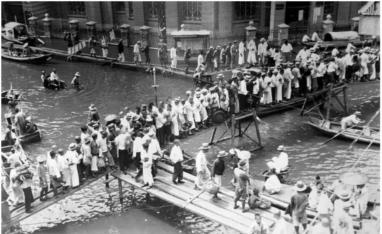
Imagem 12: A Ponte de Madeira no Cruzamento da Estrada Norte 1417
