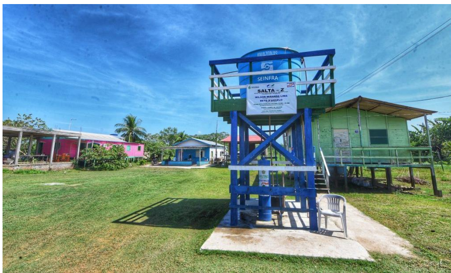
Figura 3.9 - Sistema Salta-z instalado em Manacapuru (AM) pela Secretaria de infraestrutura do estado do Amazonas.
