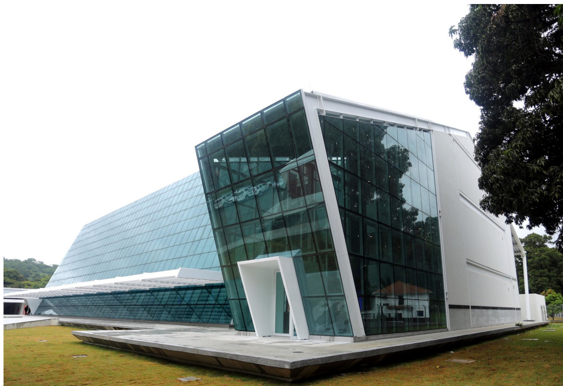
Figura 15 – Instalações do COPE-S, no Rio de Janeiro - RJ
