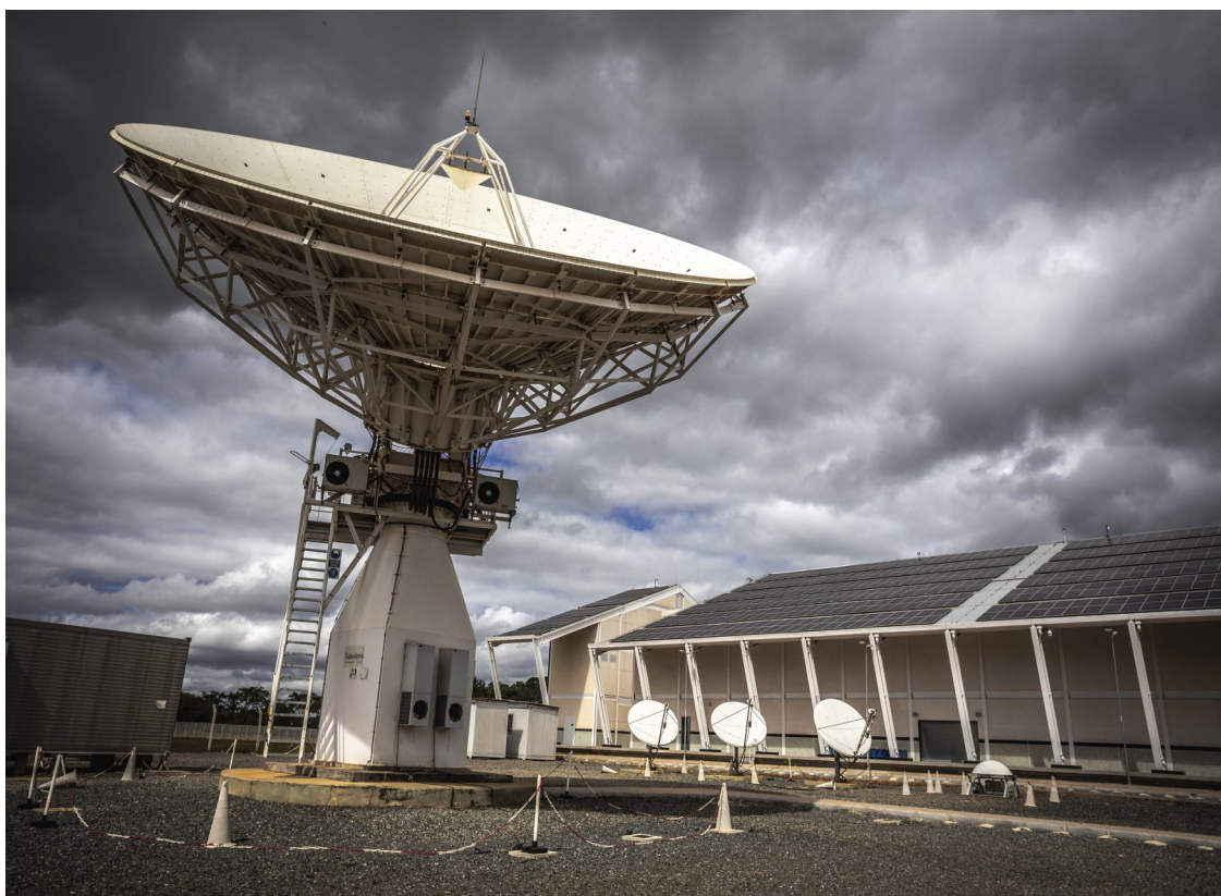
Figura 14 – Antena do COPE, responsável pela comunicação com o SGDC, operada no Segmento Terrestre sob coordenação conjunta do Ministério da Defesa e da Telebras.
