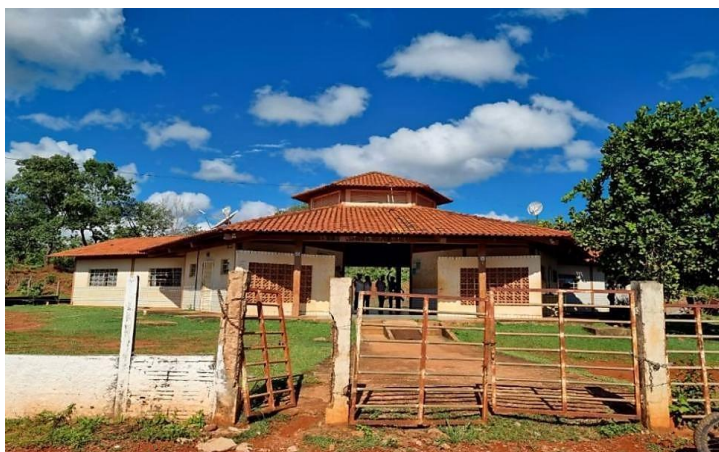
Figura 20- Estrutura atual da Escola Municipal Tinguizal - Extensão Kalunga II
