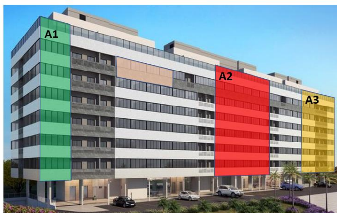
Figura 26 - Subdivisão de uma fachada em amostras individuais
