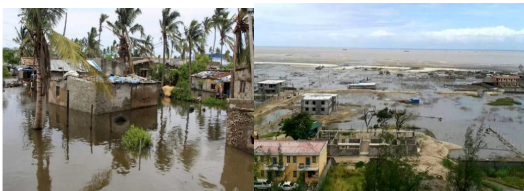
Figura 18 - Instalação de residências na planície de inundação
