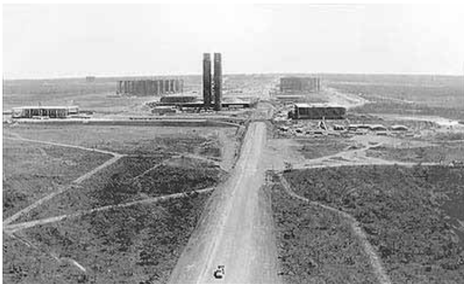
Construção da Praça dos Três Poderes. S/d. Autor: não identificado. Fonte: ArPDF
