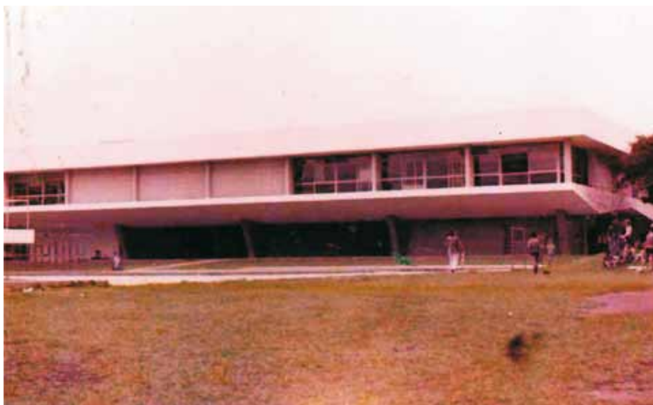
Fotografia 1 – O prédio principal da Escola Parque 307/308 Sul, na década de 1960.
