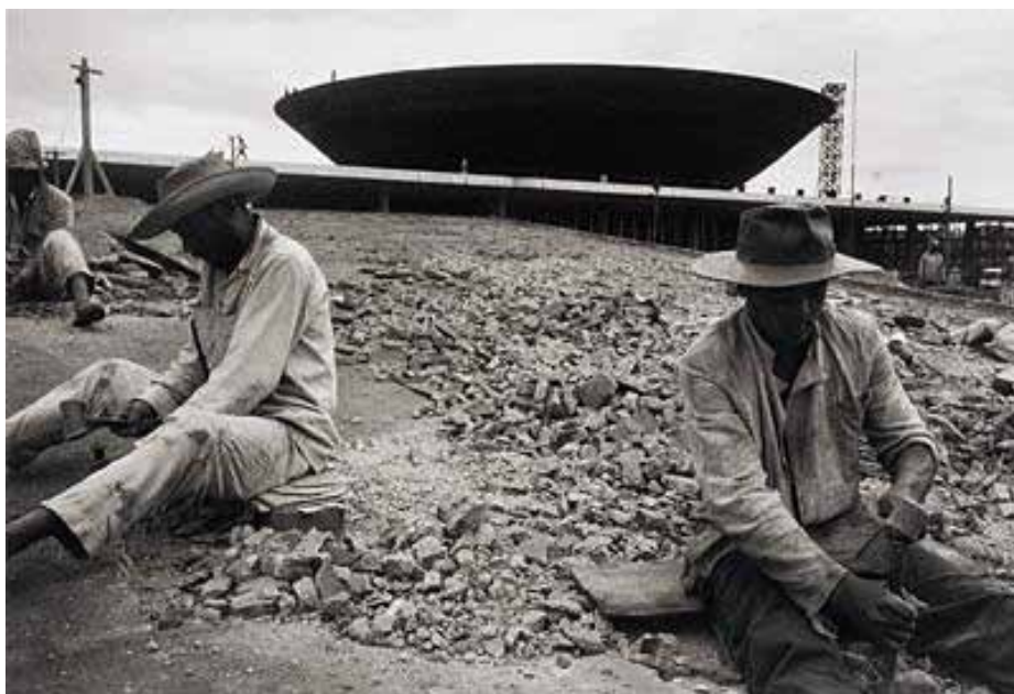
Operários na construção, 1959. Autor: não identificado. Fonte: ArPDF
