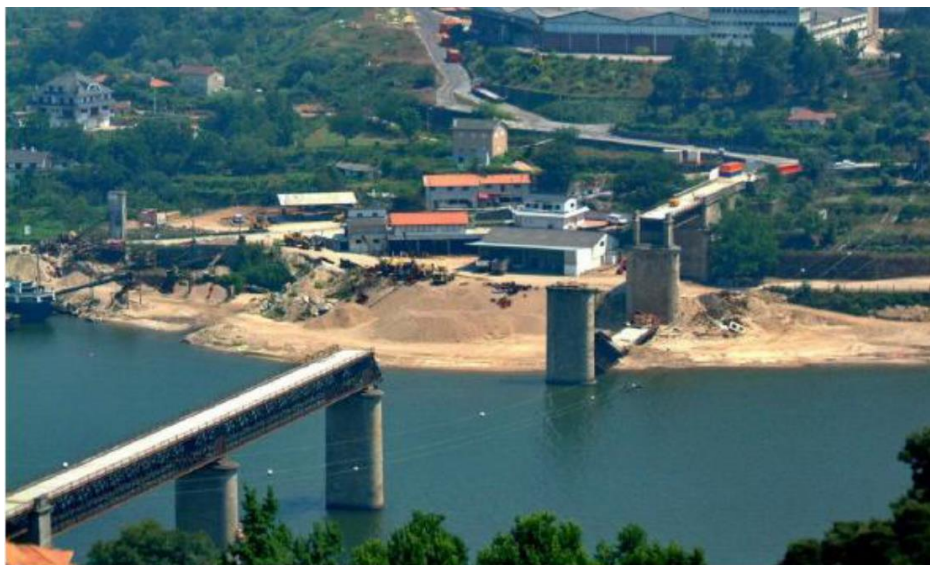
Figura 1.1 – Ponte Hintze Ribeiro após o colapso.
