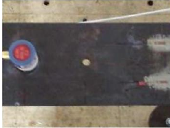
Figura 4.49 – Viga de aço sob impacto de martelo, contendo dano provocado por furo de 12mm.
