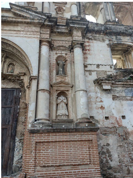
137. Construções colonias com partes derrubadas pelo terremoto de 1773.
