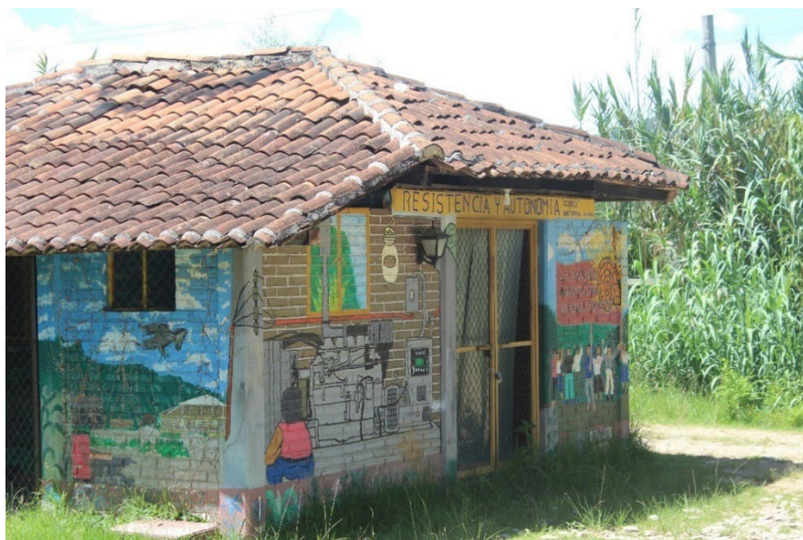
74. Casa do gerador de luz.
