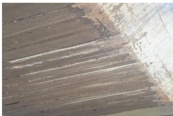
Figura 2.14 – Exemplo de abrasão. (Fonte: PAVONI, 2019)
