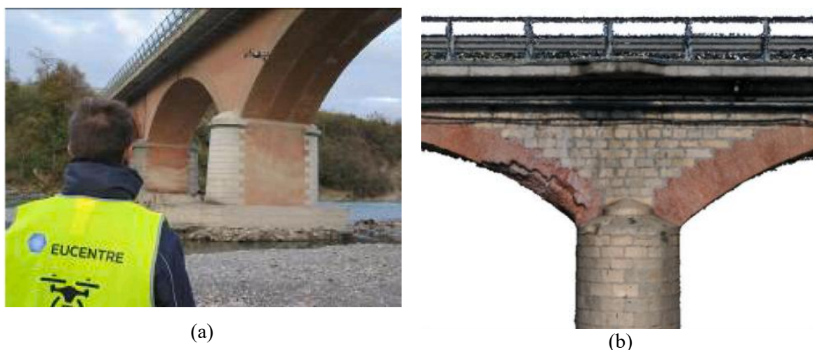
Figura 1.3 – Inspeção de ponte por aerofotogrametria com auxílio de drone. (a) Inspeção. (b) Modelo gerado.
