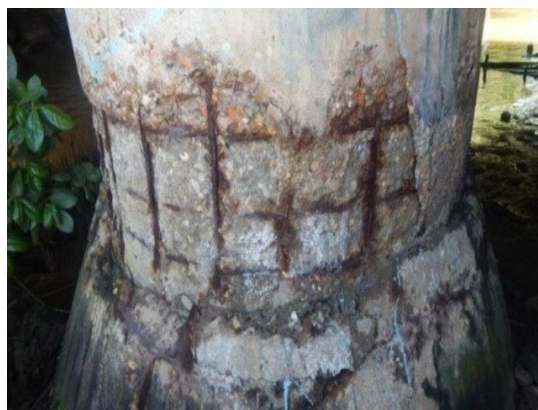
Figura 2.8 – Exemplo de corrosão de armadura. (Fonte: OLIVEIRA, 2020)
