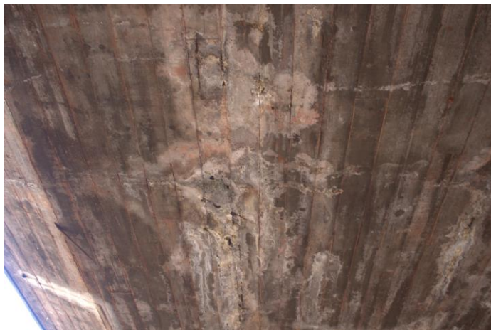
Figura 4.28 Exemplo de patologia do tabuleiro da OAE1 entre os pilares 1 e 4. (Fonte: autor)
