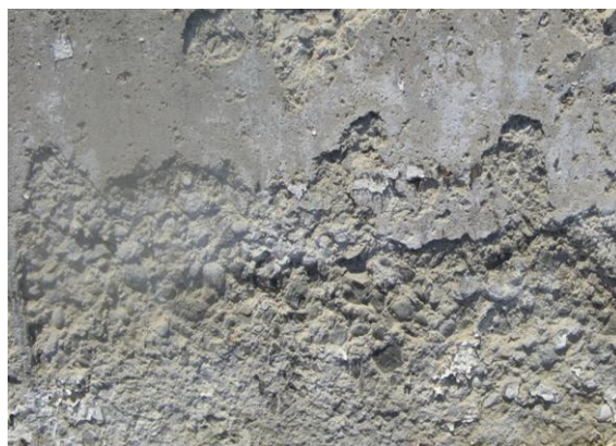
Figura 2.9 – Exemplo de desagregação. (Fonte: KARNAK, 2024)
