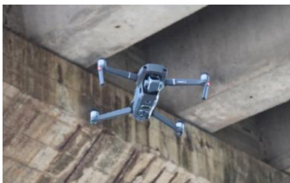
Figura 2.3 – Uso de drone para inspecionar abaixo do tabuleiro. (Fonte: MANDIROLA et al. , 2022)
