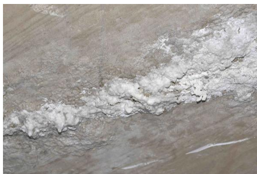
Figura 2.11 – Exemplo de eflorescência. (Fonte: ECIVIL, 2016)
