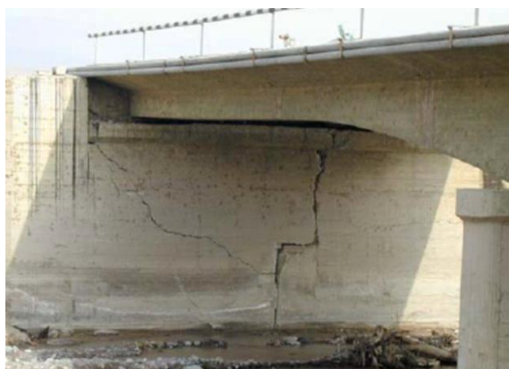
Figura 2.12 – Exemplo de fissura. (Fonte: PAPATZANI, 2002)
