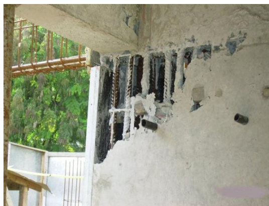
Figura 2.13 – Exemplo de falha de concretagem. (Fonte: DRYPLAN, 2016)
