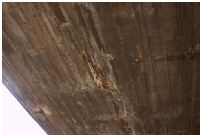
Figura 4.29 Exemplo de patologia do tabuleiro da OAE1 entre os pilares 4 e 7. (Fonte: autor)
