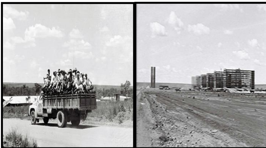
Figura 1 – Candangos indo para o trabalho na construção de Brasília
