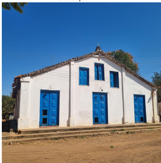
Figura 5: Foto da Igreja de Nossa Senhora do Rosário, atualmente fechada por falta de manutenção
