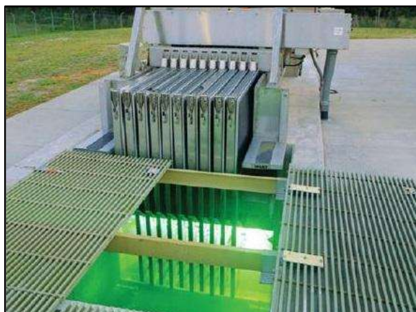
Figura 20 - Desinfecção ultravioleta em funcionamento
