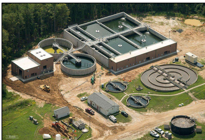
Figura 27 - Tratamento terciário com a tecnologia Remoção Biológica de Nutrientes (RBN)
