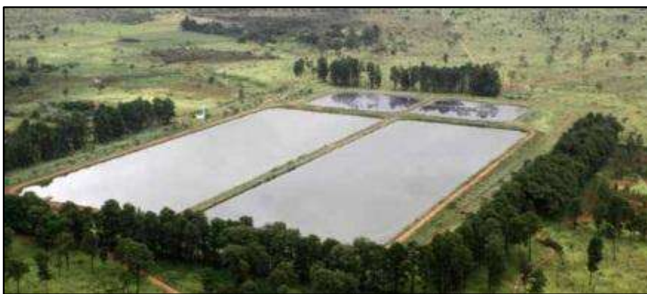
Figura 15 - ETE Brazlândia composta por duas lagoas anaeróbicas e duas lagoas facultativas em duas linhas paralelas
