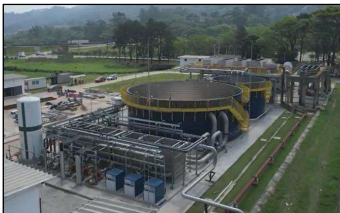
Figura 28 - Tratamento terciário com a tecnologia Biorreator com Membranas (BRM)
