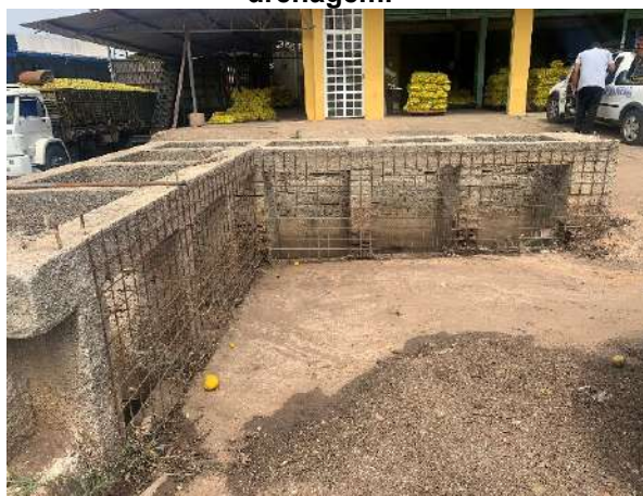
Figura 69 - Gradeamento entrada sistema drenagem.
