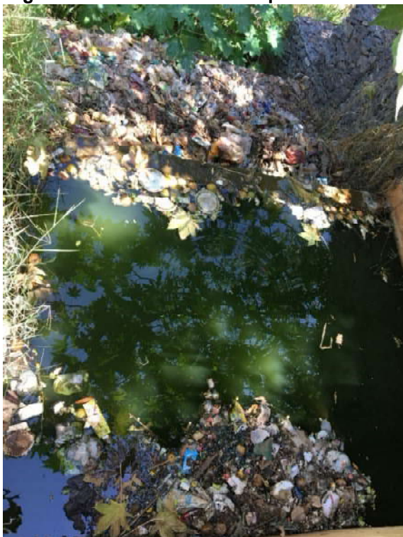
Figura 34 - Resíduos no dissipador de saída
