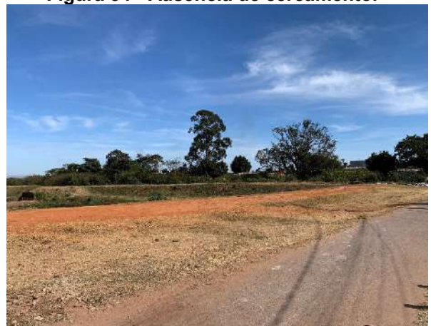
Figura 54 - Ausência de cercamento.
