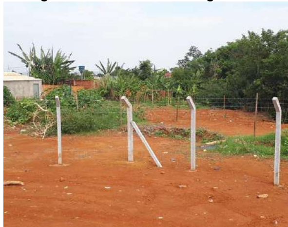
Figura 19 - Cercamento da lagoa nº 5.
