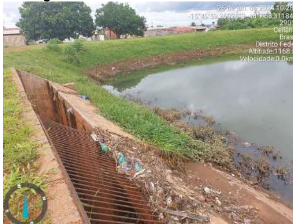
Figura 55 - Gradeamento danificado.
