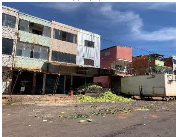
Figura 90 - Resíduos espalhados no interior da Feira.
