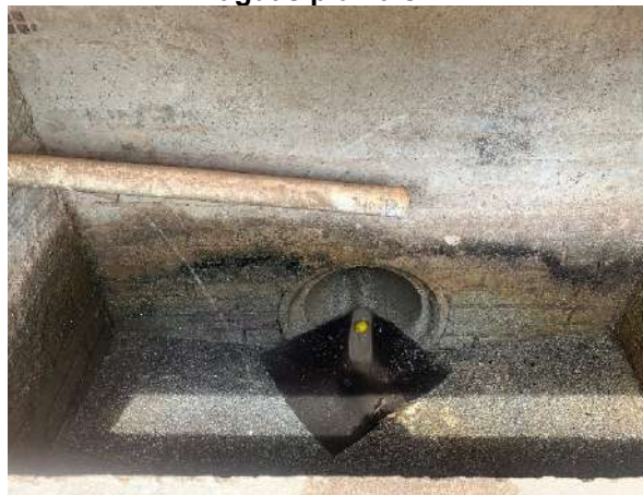
Figura 72 - Início do sistema drenagem de águas pluviais.
