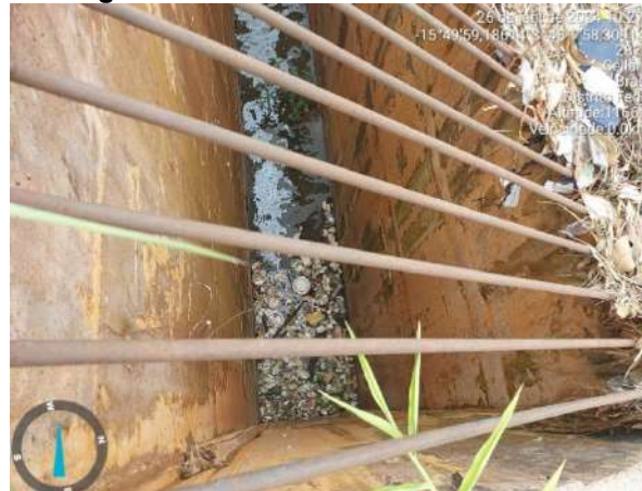
Figura 56 - Gradeamento danificado.
