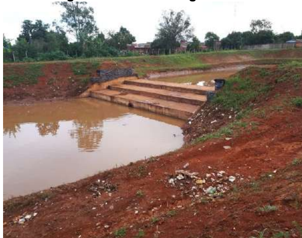
Figura 18 - Interior lagoa nº 5.
