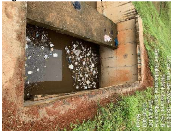
Figura 59 - Resíduos dissipador de entrada.
