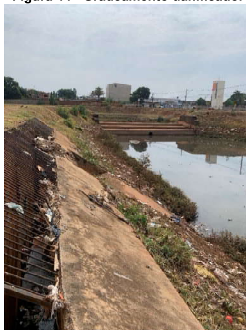
Figura 44 - Gradeamento danificado.
