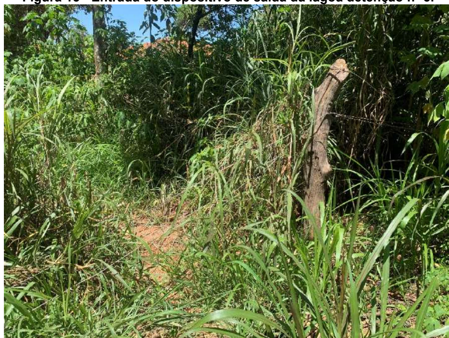
Figura 15 - Entrada do dispositivo de saída da lagoa detenção nº 5.
