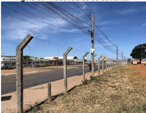
Figura 53 - Ausência de cercamento.
