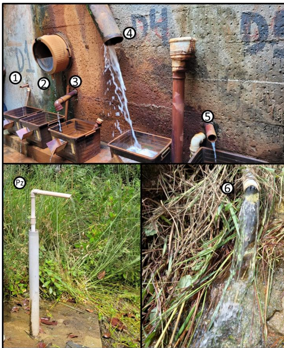
Figura 21. Drenos (1 a 5) amostrados na galeria de passagem. Piezômetro (Pz) e dreno do poço (6) amostrados.
