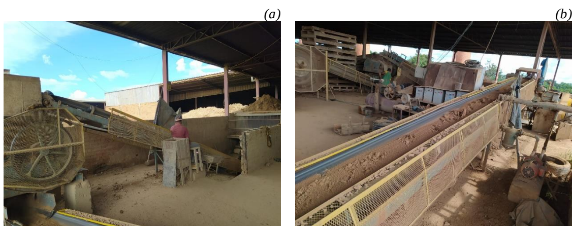
Figura 66: Material saindo da caixa alimentadora e seguindo por correia transportadora até o desintegrador (a) e material seguindo do desintegrador até o misturador na Empresa A (b).
