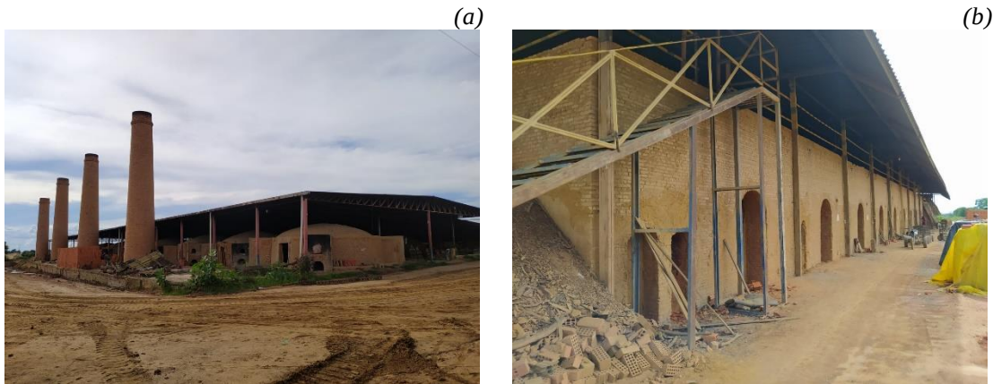
Figura 71: Fornos tipo abóboda (a) e forno tipo cedan da Empresa Cerâmica A (b).
