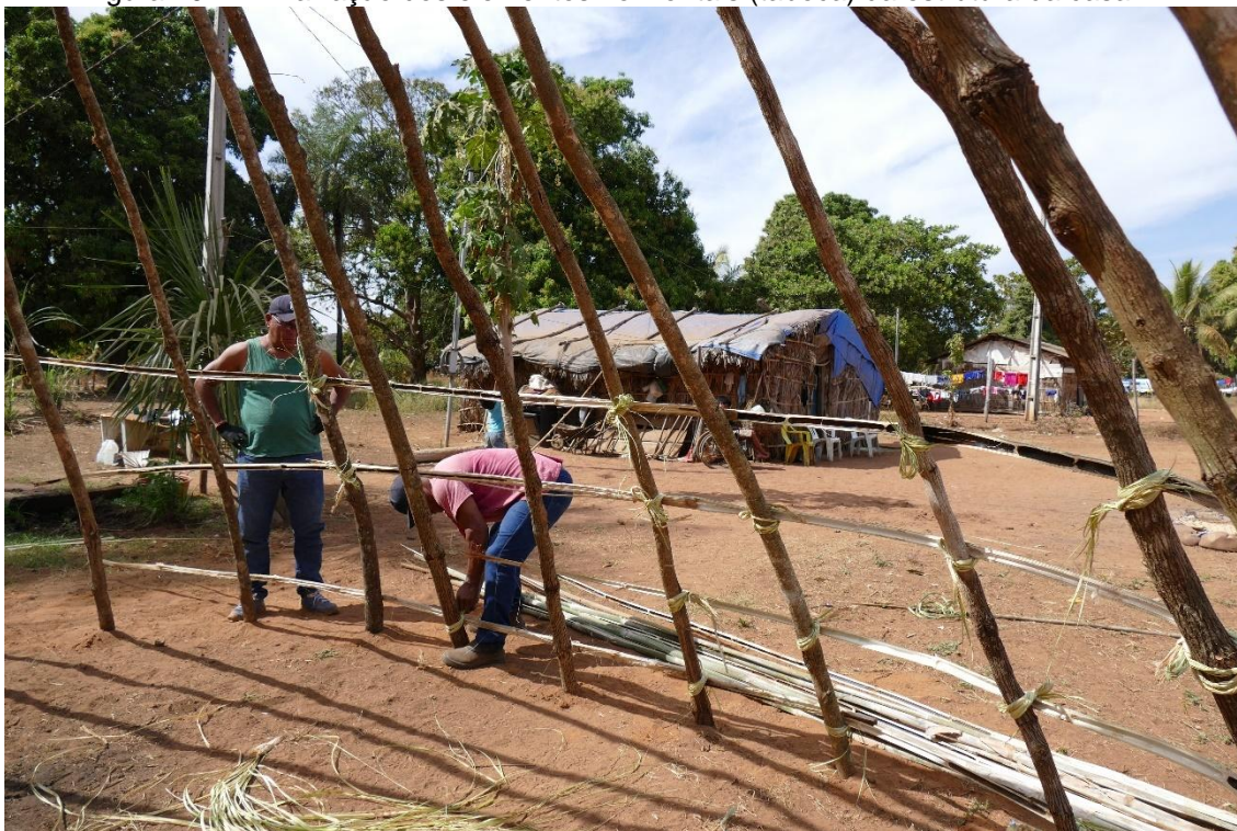
Figura 70 — Amarração dos elementos horizontais (taboca) da estrutura da casa Rí
