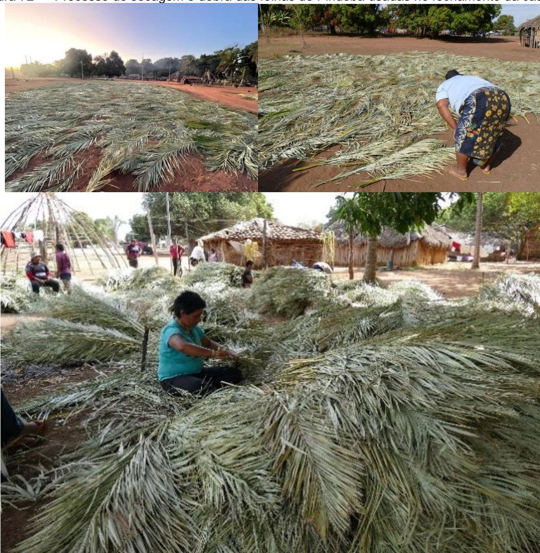
Figura 72 — Processo de secagem e dobra das folhas de Pindoba usadas no fechamento da casa Rí
