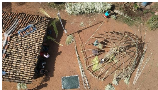
Figura 75 — Primeiras missões para captura de imagens: Finalização da montagem dos elementos verticais tensionados (a). Início da colocação dos elementos horizontais (b)
