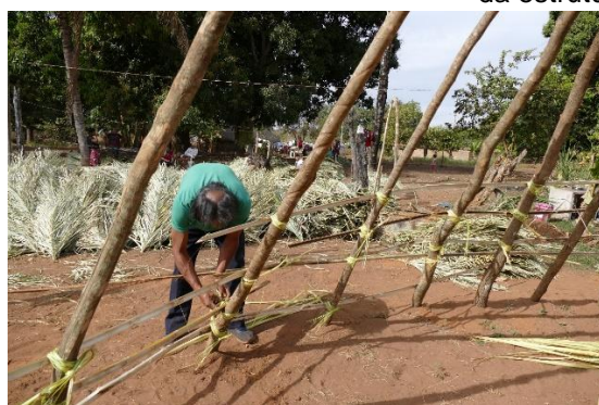
Figura 69 — Documentação por vídeo da execução do nó de amarração dos elementos horizontais da estrutura
