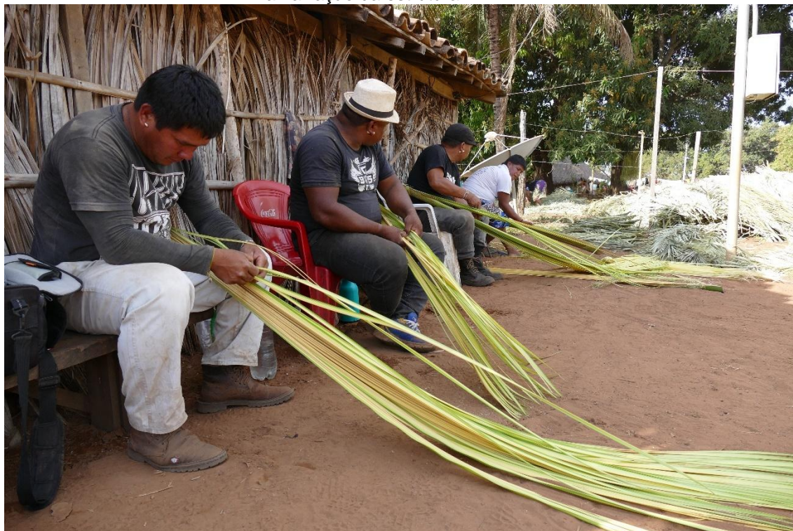
Figura 66 — Jovens executando o processo de tratamento dos brotos para serem usados na amarração da estrutura
