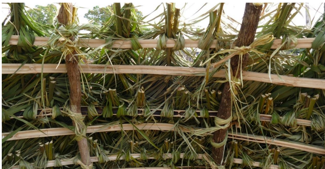
Figura 77 — Elementos de fechamento internos a serem aparados como acabamento
