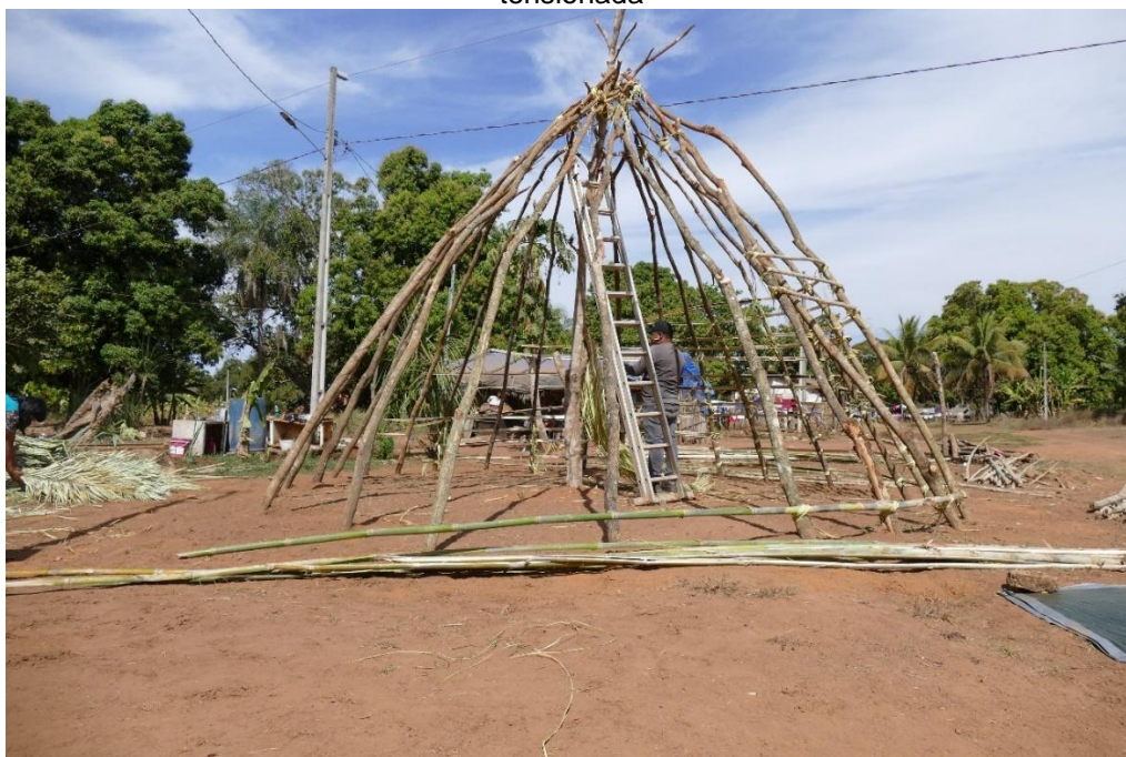
Figura 63 — Processo de montagem da estrutura da casa Rí: Curvamento e amarração da estrutura tensionada
