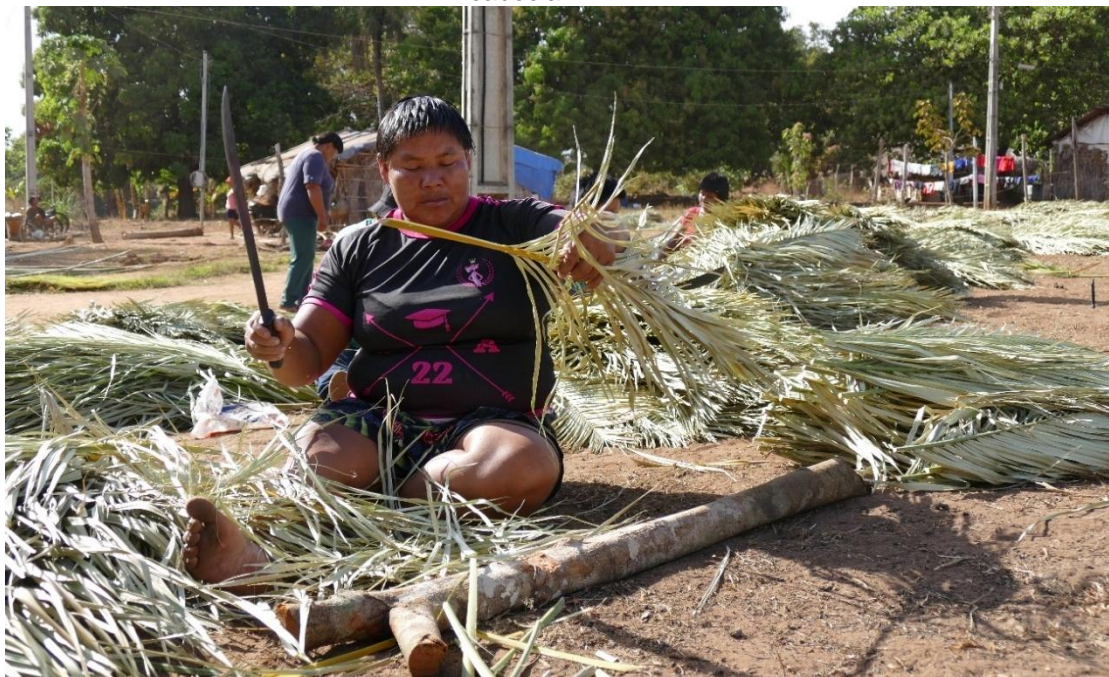
Figura 74 — Mulher A'uwẽ realizando o tratamento da palha para a aplicação da técnica de fixação cabocla
