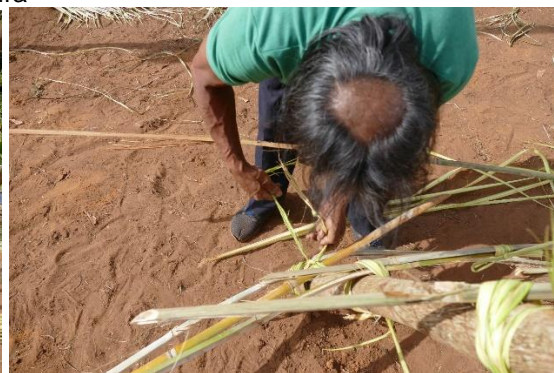
Figura 69 — Documentação por vídeo da execução do nó de amarração dos elementos horizontais da estrutura
