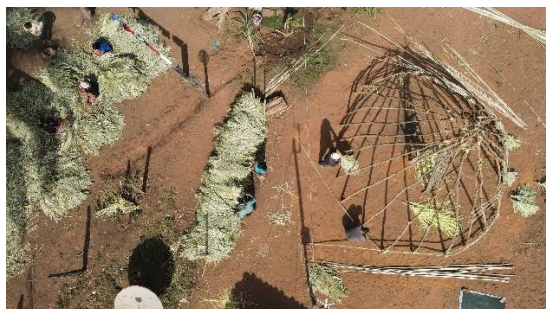
Figura 75 — Primeiras missões para captura de imagens: Finalização da montagem dos elementos verticais tensionados (a). Início da colocação dos elementos horizontais (b)
