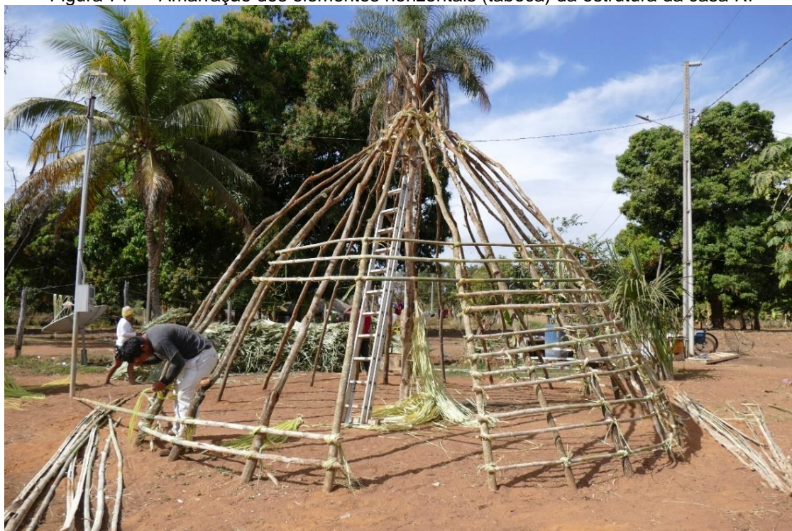
Figura 71 — Amarração dos elementos horizontais (taboca) da estrutura da casa Rí
