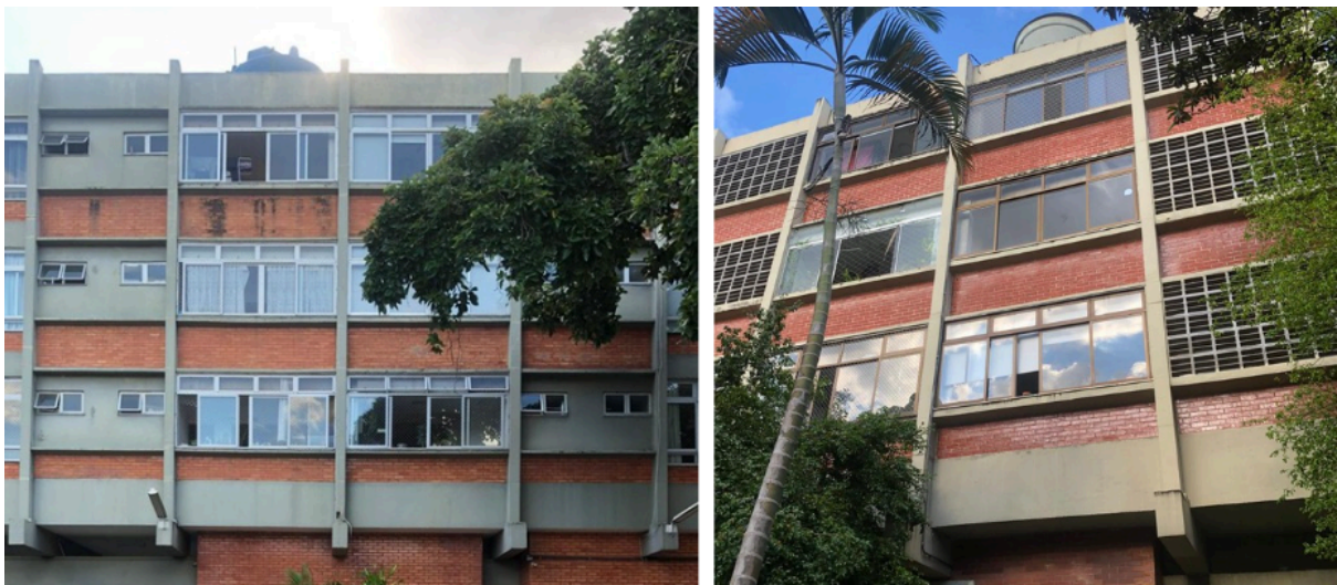
Figura 96. Detalhe das caixas d’água aparentes nas fachadas dos Blocos A e G da SQN 410. Autoria própria, 2024.
