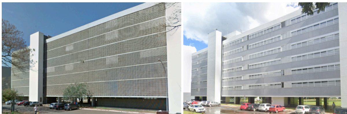
Figura 57. Antes e depois da reforma da fachada posterior dos blocos da SQN 302. Fonte: Google Street View, 2011; 2020.
