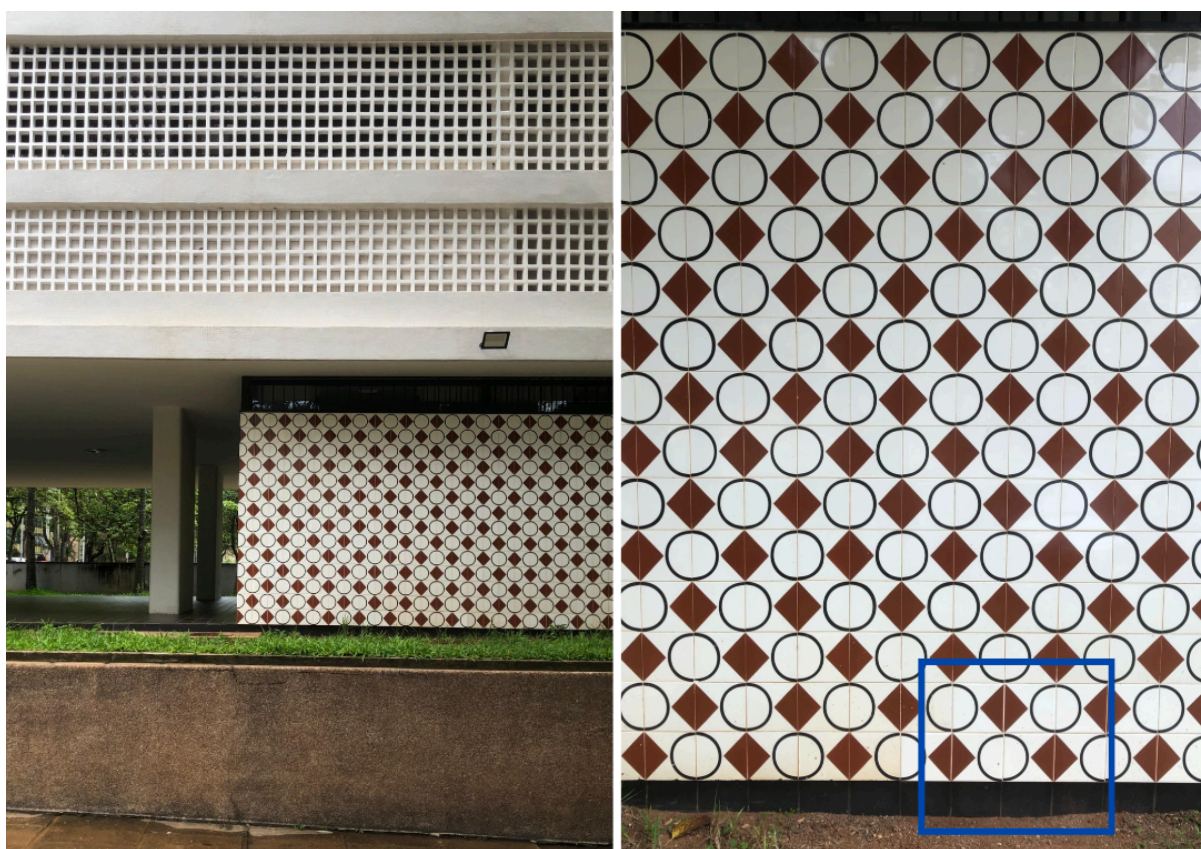
Figura 51. Fachada Posterior do Bloco H da SQS 308 e detalhes do painel de azulejo reparado. Autoria própria, com marcações destacando as novas peças inseridas, 2024.
