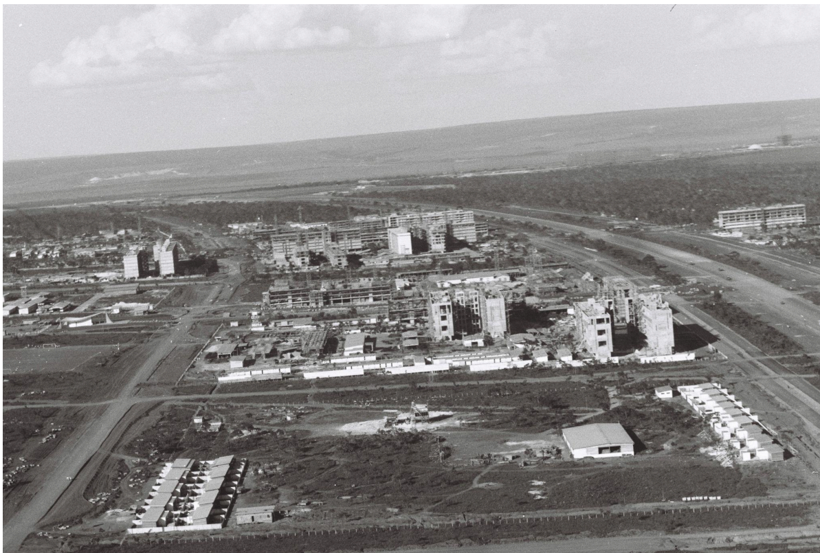
Figura 7. Construção das SQS 108, 107, 307, 106 e 206 (1958-1960). Fonte: Fundo Novacap, ArPDF.
