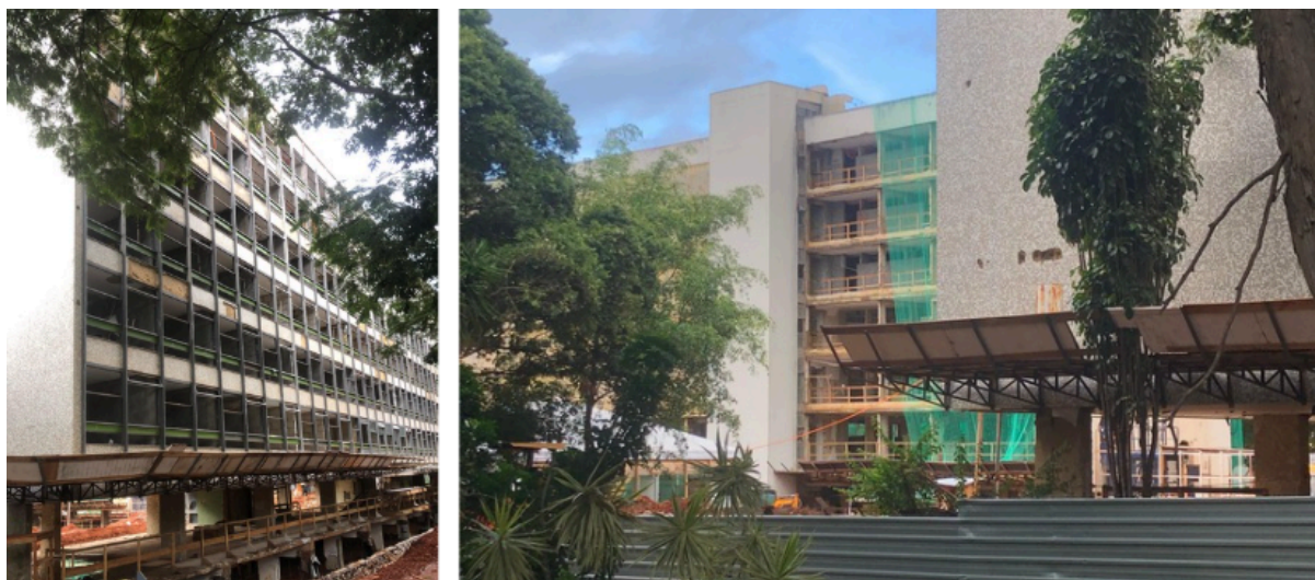
Figura 58. Reforma completa dos blocos K e L da SQN 202. Fonte: Autoria própria, 2025.
