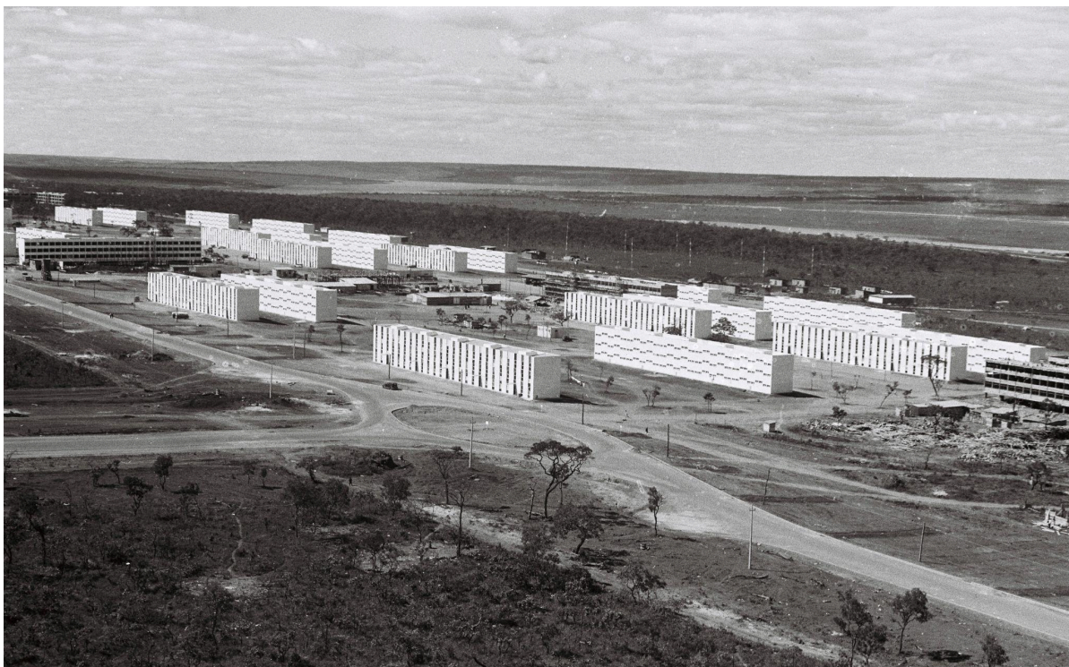
Figura 8. Construção das superquadras 411/412 e 413 Sul (1958-1960). Fonte: Fundo Novacap, ArPDF.
