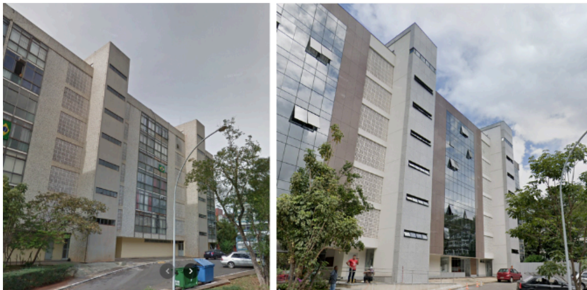
Figura 61. Antes e depois da reforma da fachada posterior do Bloco B da SQS 110.
