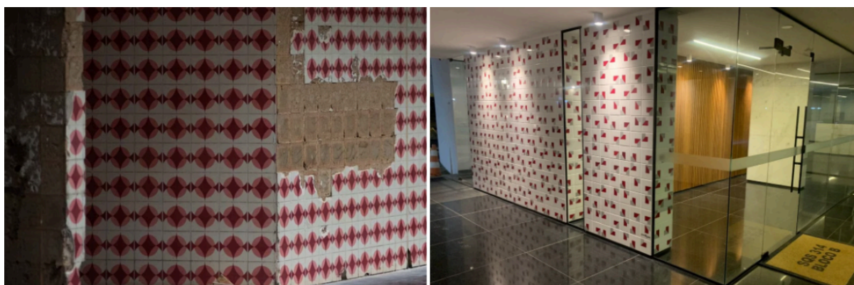
Figura 62. Antes e depois da reforma de pilotis do Bloco B da SQS 314.
