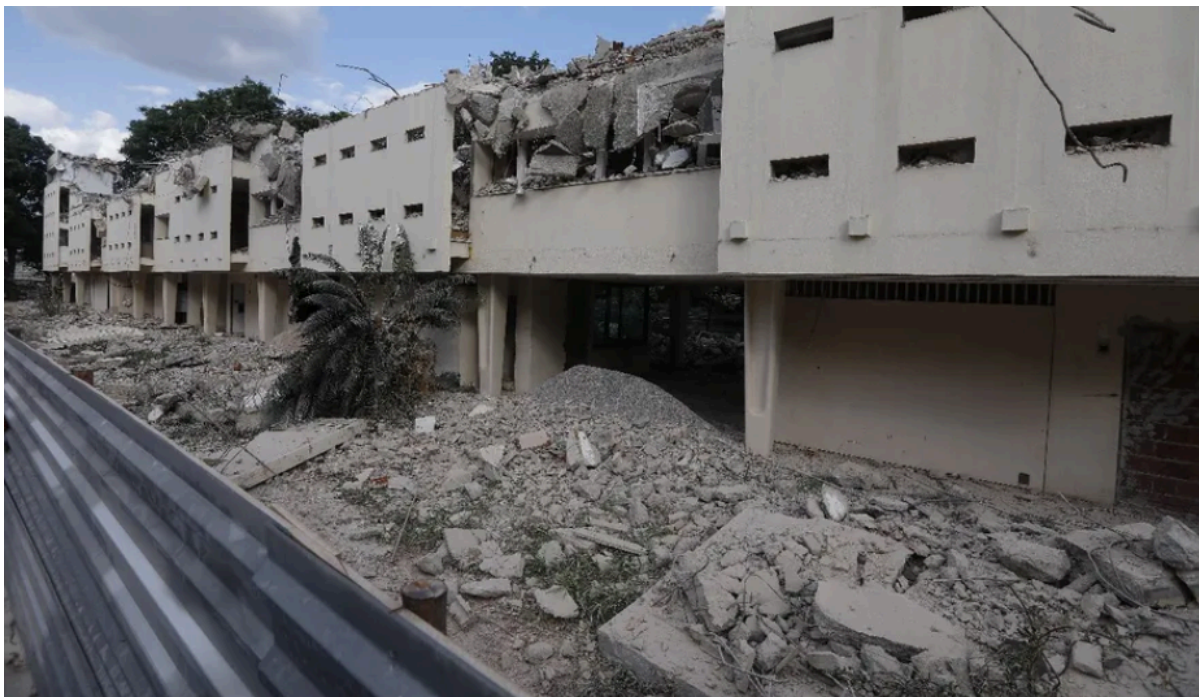
Figura 63. Demolição do Bloco S da SQS 403. Fonte: O Globo. Autor: Cristiano Mariz, 2023.
