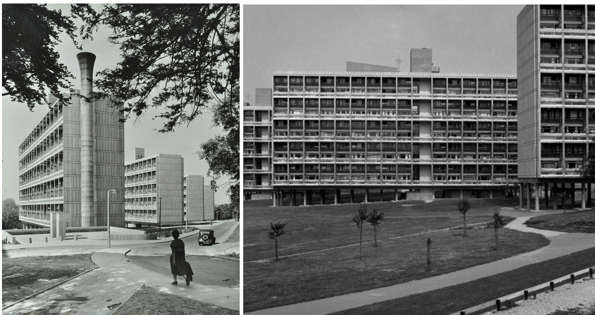
Figura 25. Slab Blocks de Alton West, Reino Unido.
