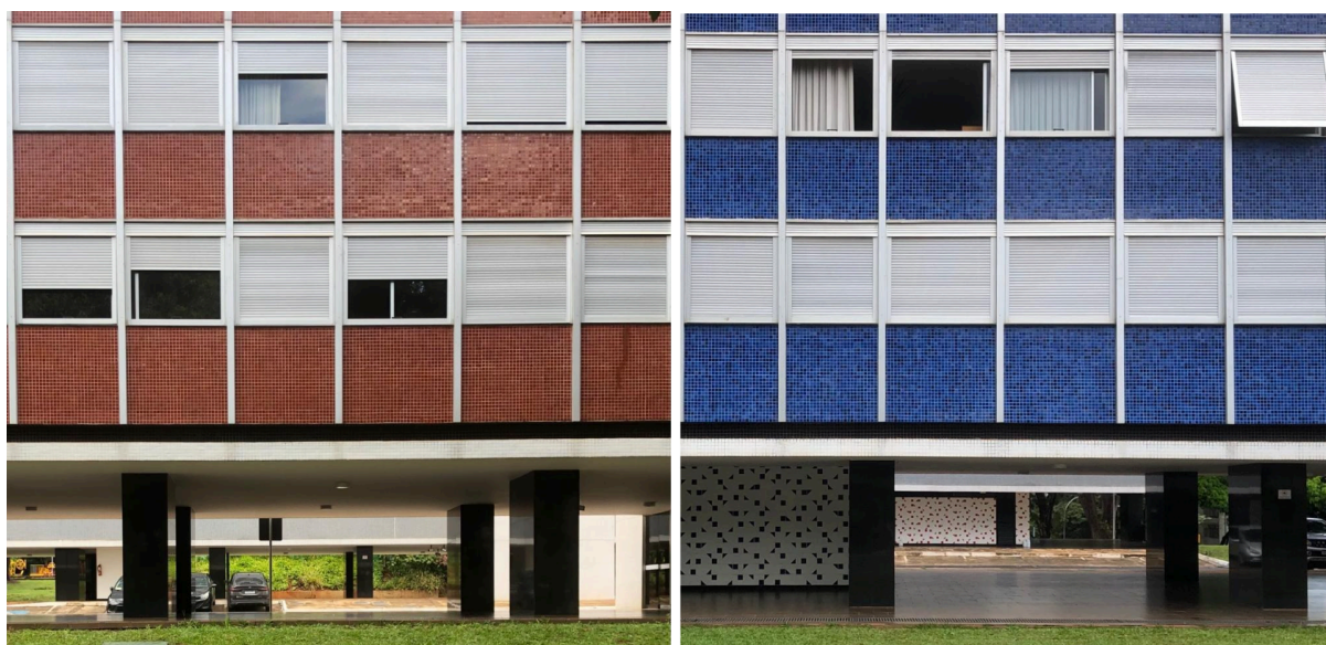
Figura 56. Detalhe do contorno das molduras da fachada frontal dos Blocos A e B da SQN 302. Fonte: Autoria própria, 2025.
