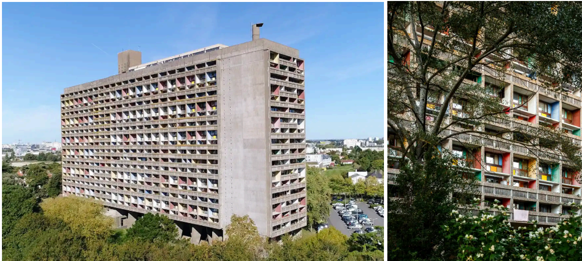
Figura 16. La Maison Radieuse de Rezé.
