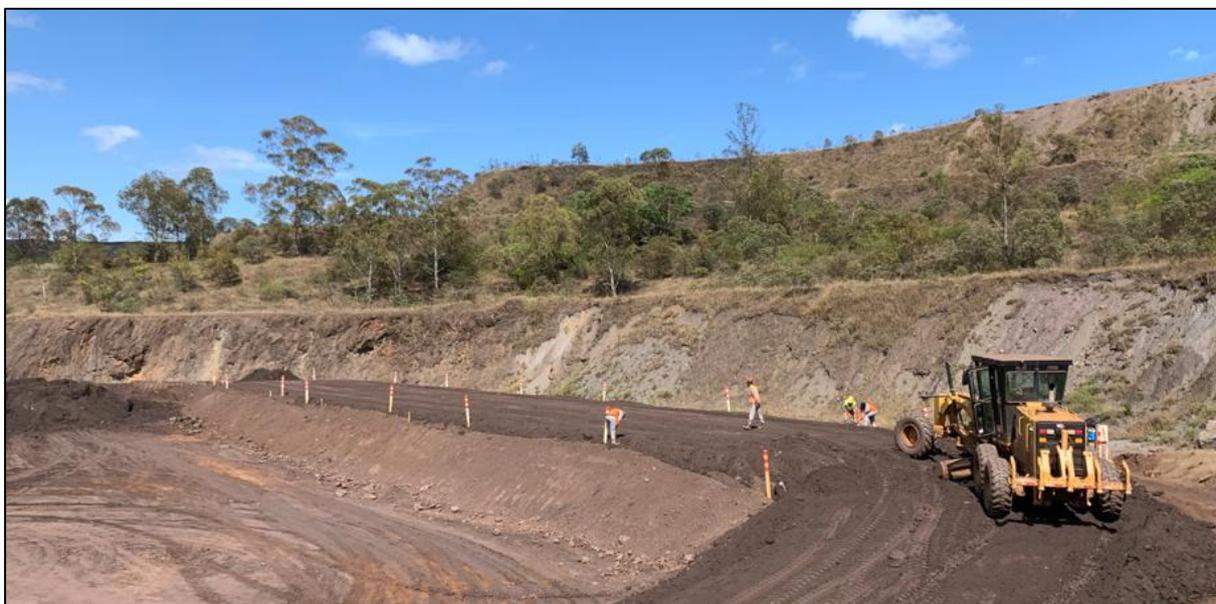
Figura 3.11 – Escarificação da 5ª camada do aterro experimental compactado
