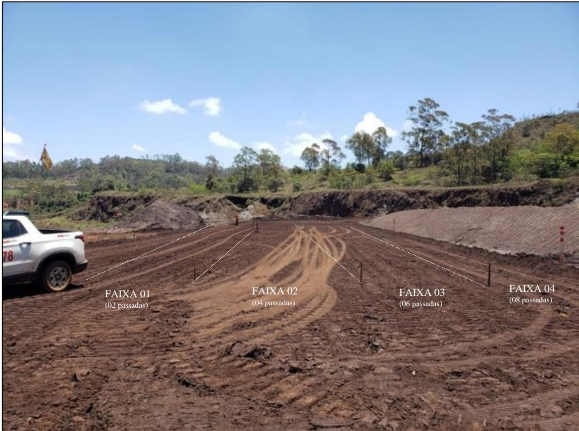
Figura 3.15 – Execução da 1ª camada aterro experimental esteirado, dividida em quatro faixas
