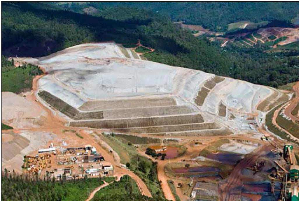
Figura 2.1 – Exemplo de depósito de rejeito pelo método de empilhamento drenado (IBRAM, 2016)
