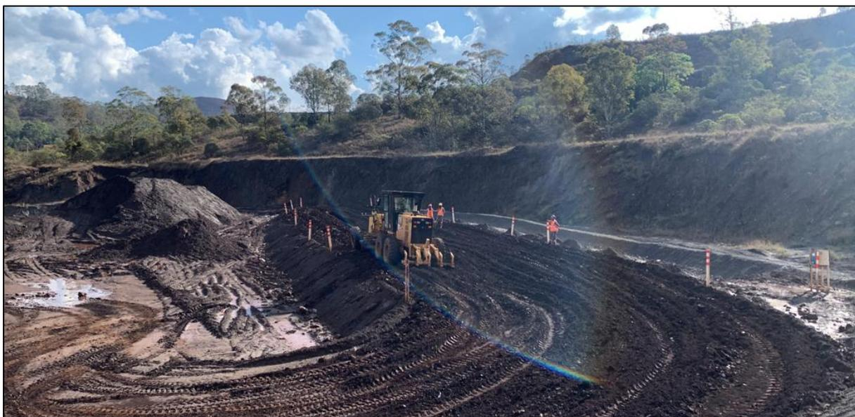
Figura 3.10 – Escarificação da 3ª camada do aterro experimental compactado
