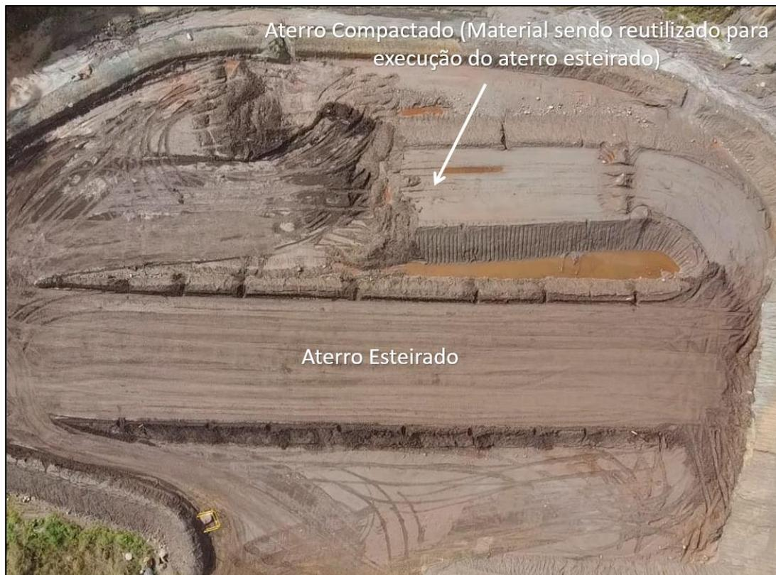
Figura 3.18 – Localização dos aterros experimentais construídos, com foco para a construção do aterro experimental esteirado em andamento
