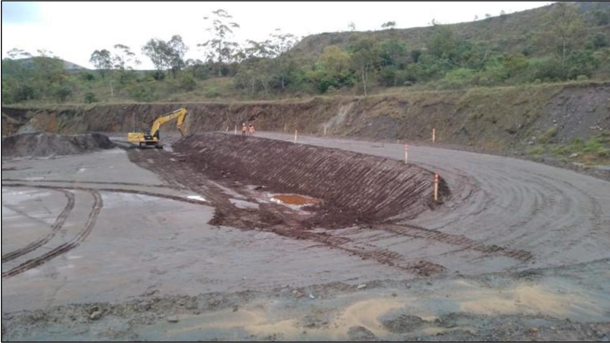
Figura 3.12 – 6ª camada do aterro experimental compactado após o registro de precipitação pluviométrica
