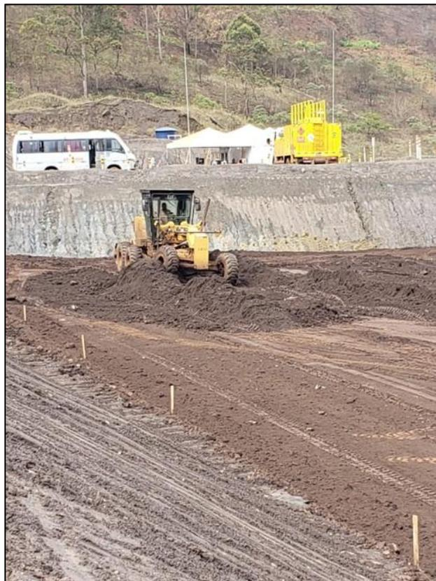
Figura 3.14 – Espalhamento de material para a execução da 1ª camada do aterro experimental esteirado com espessura solta de 40 cm
