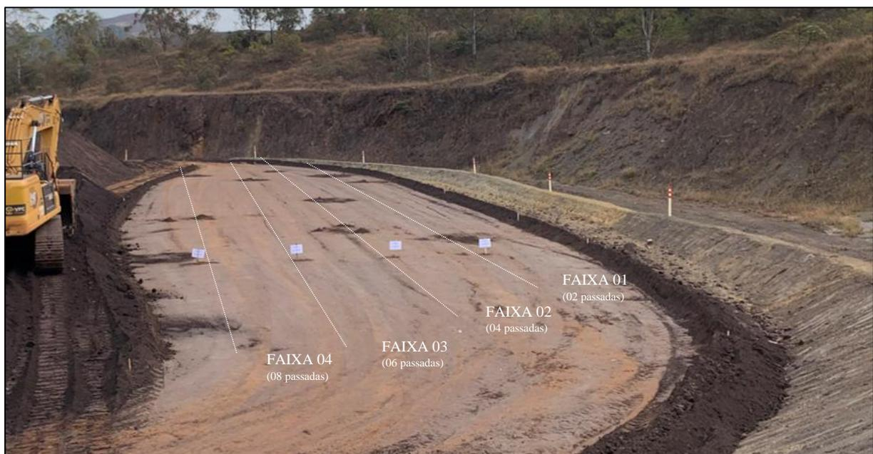
Figura 3.9 – Execução da 1ª camada aterro experimental compactado
