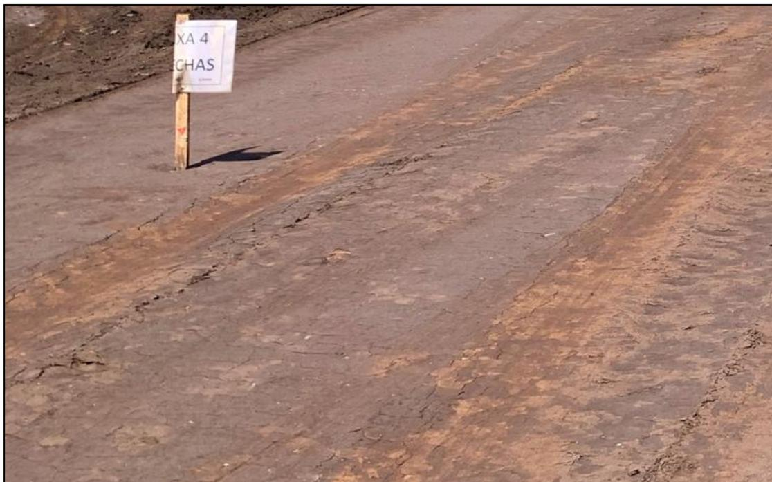
Figura 4.8 – Presença de “borrachudo” na 3ª camada do aterro experimental compactado após a realização de oito passadas
