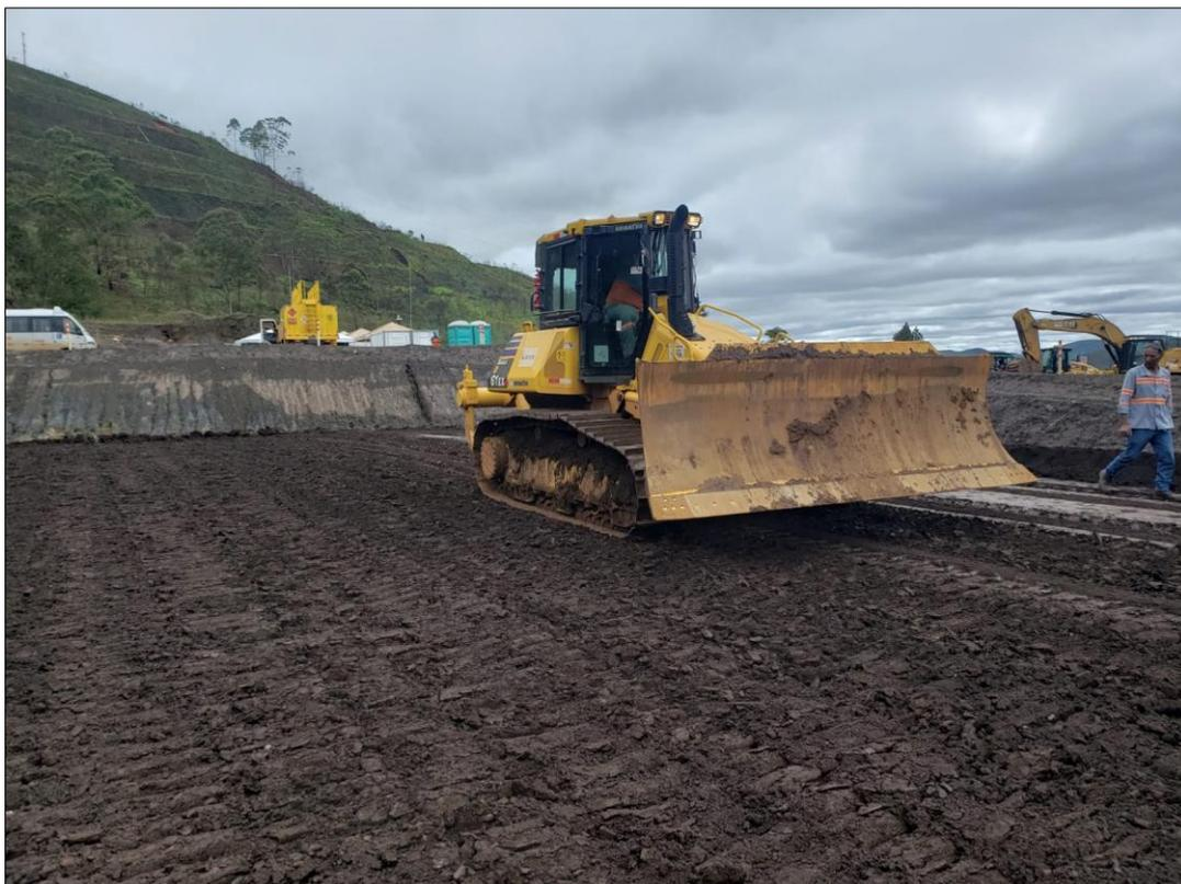
Figura 3.17 – Execução finalizada da 4ª camada aterro experimental esteirado, dividida em quatro faixas
