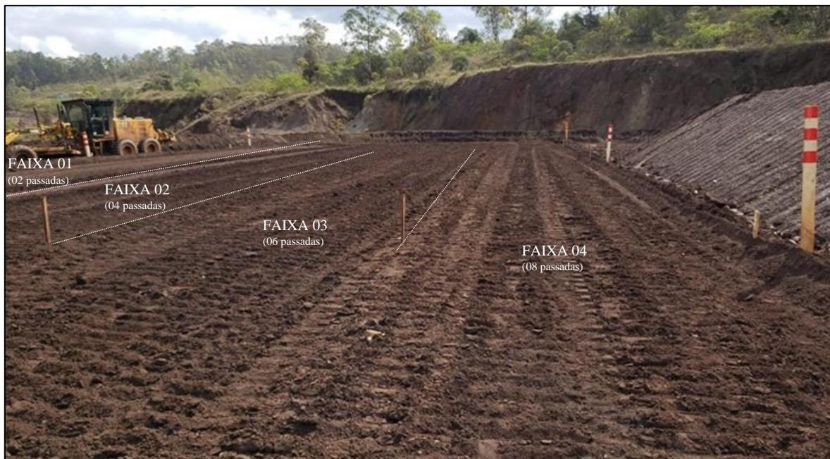
Figura 3.16 – Execução da 2ª camada aterro experimental esteirado, dividida em quatro faixas
