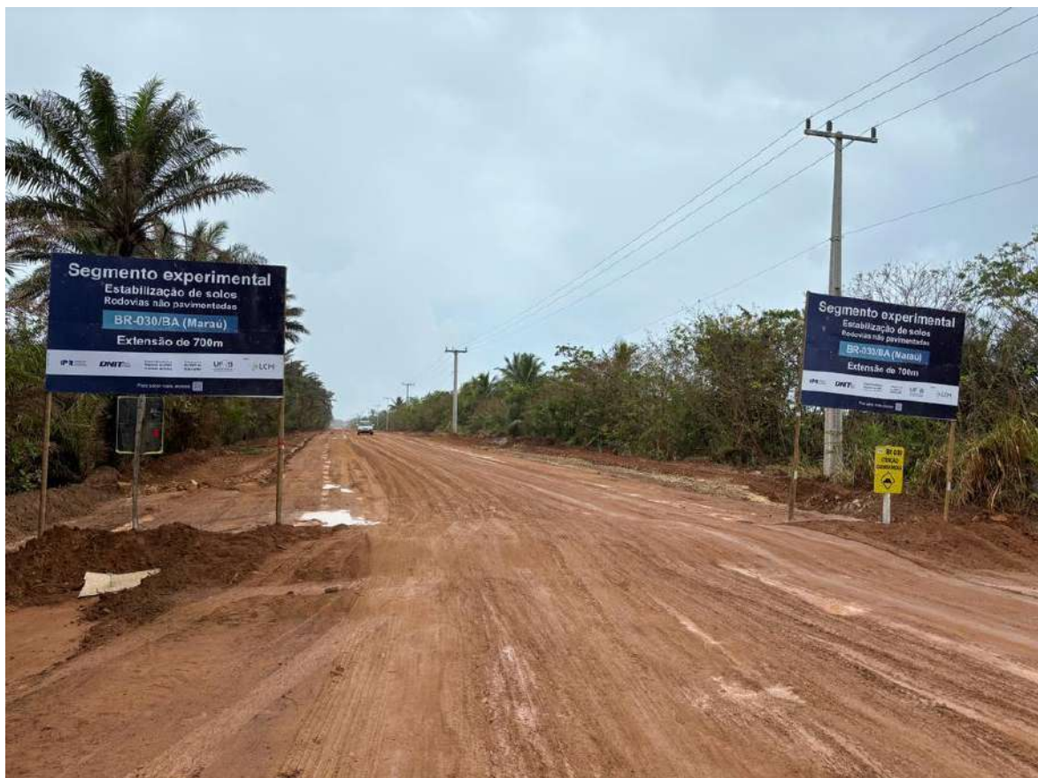
Figura 3.30 - Placas de identificação do segmento experimental instaladas às margens da rodovia.
