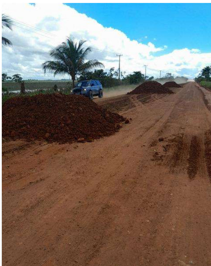
Figura 2.15 - Implantação de camada de revestimento primário (Acervo fotográfico da Unidade Local do DNIT de Itabuna).
