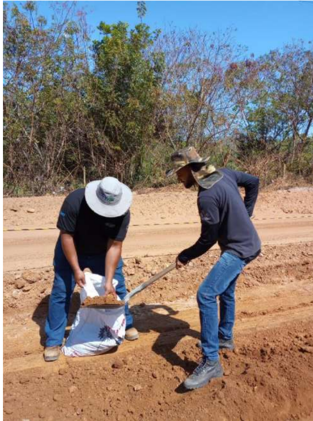
Figura 3.29 - Coleta de amostras para controle de compactação da camada de desgaste na seção 5.
