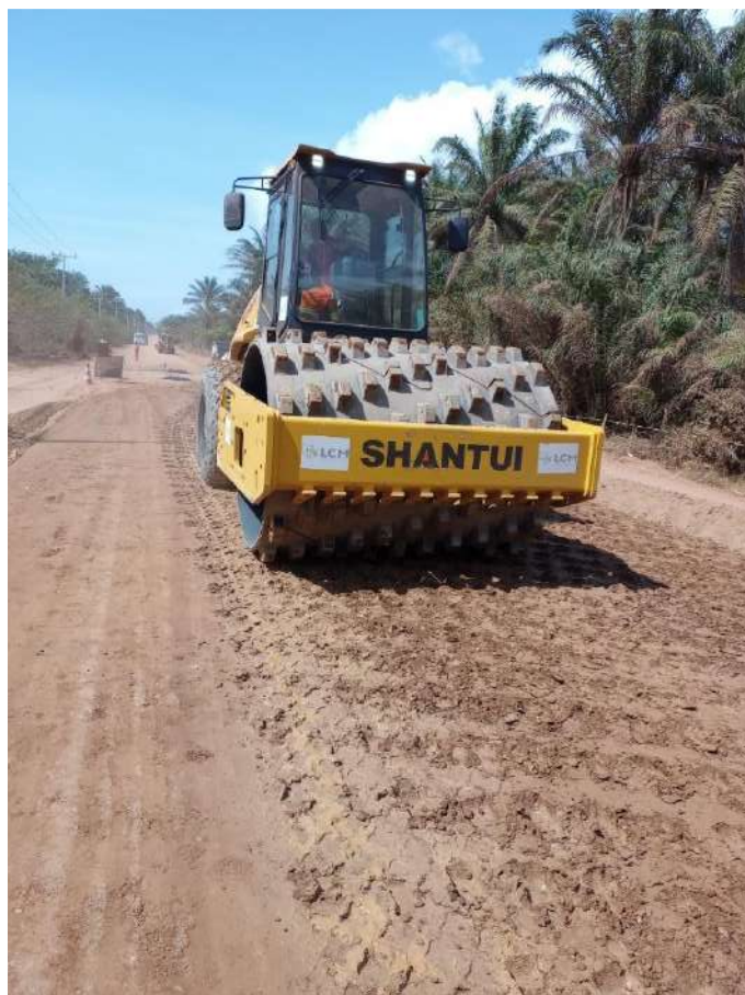
Figura 3.27 - Compactação da camada de desgaste da seção 2.
