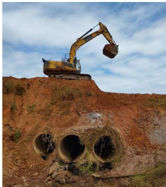
Figura 2.11 - Desobstrução de bueiro e recomposição mecanizada de aterro (Acervo fotográfico da Unidade Local do DNIT de Itabuna).
