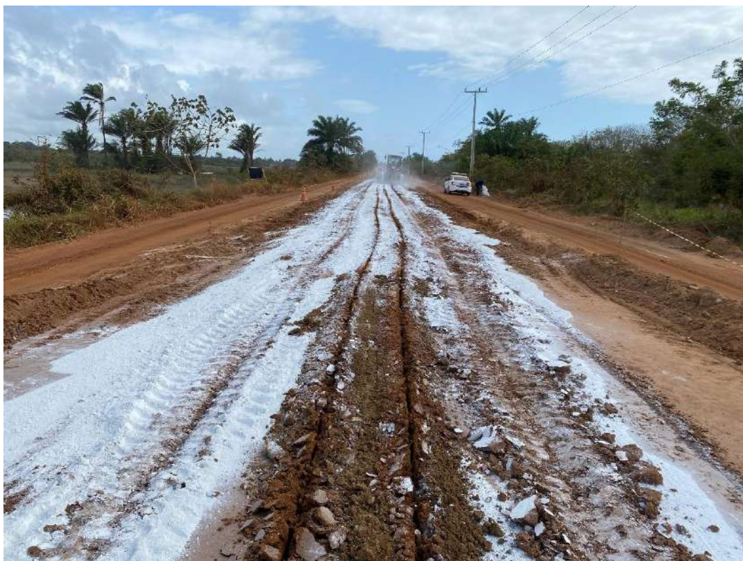
Figura 3.23 - Espalhamento de cal hidratada na pista da seção 6.
