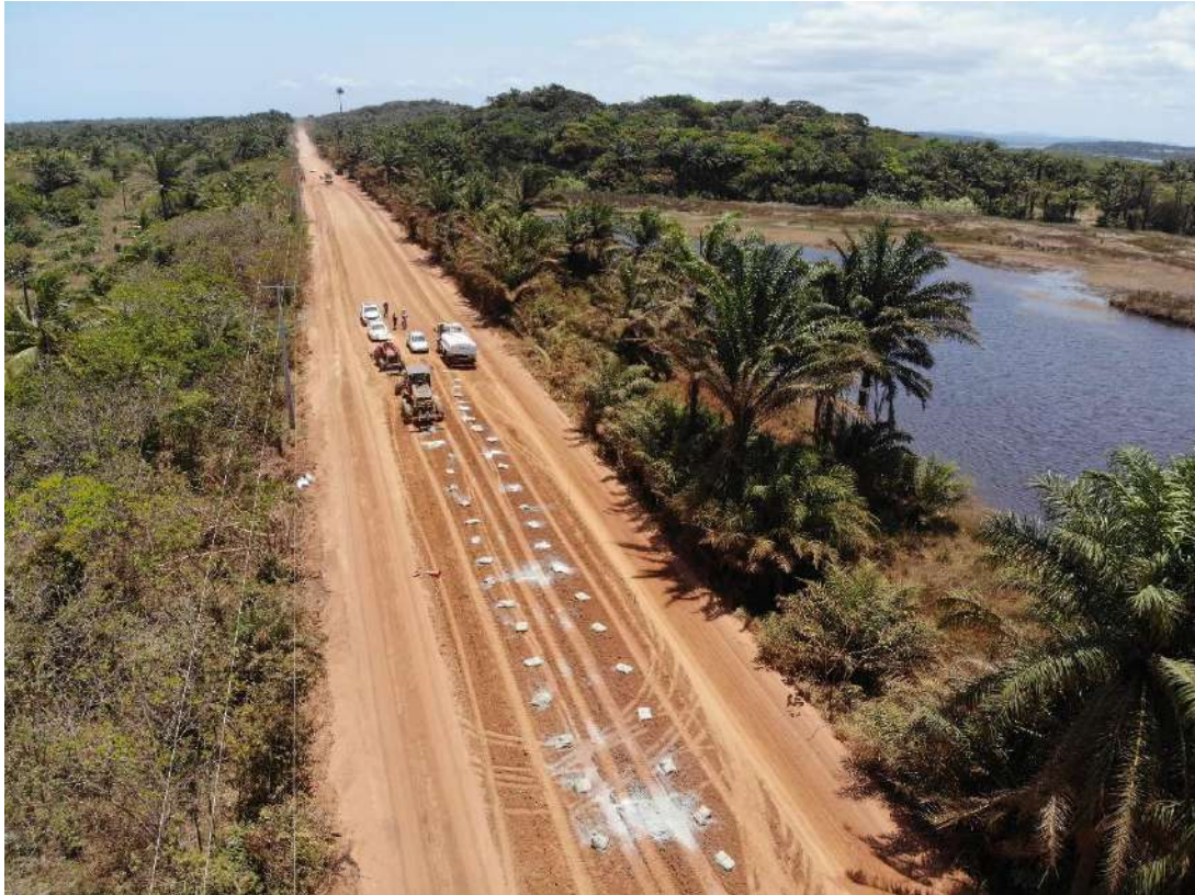
Figura 3.21 - Vista aérea do cimento Portland distribuído na pista da seção 1.
