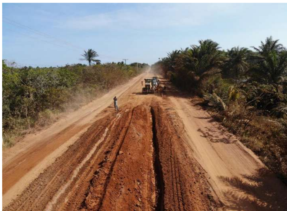
Figura 3.14 - Início da escarificação da camada de desgaste da seção 3.
