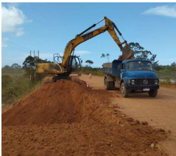
Figura 2.9 - Recomposição lateral do aterro (Acervo fotográfico da Unidade Local do DNIT de Itabuna).
