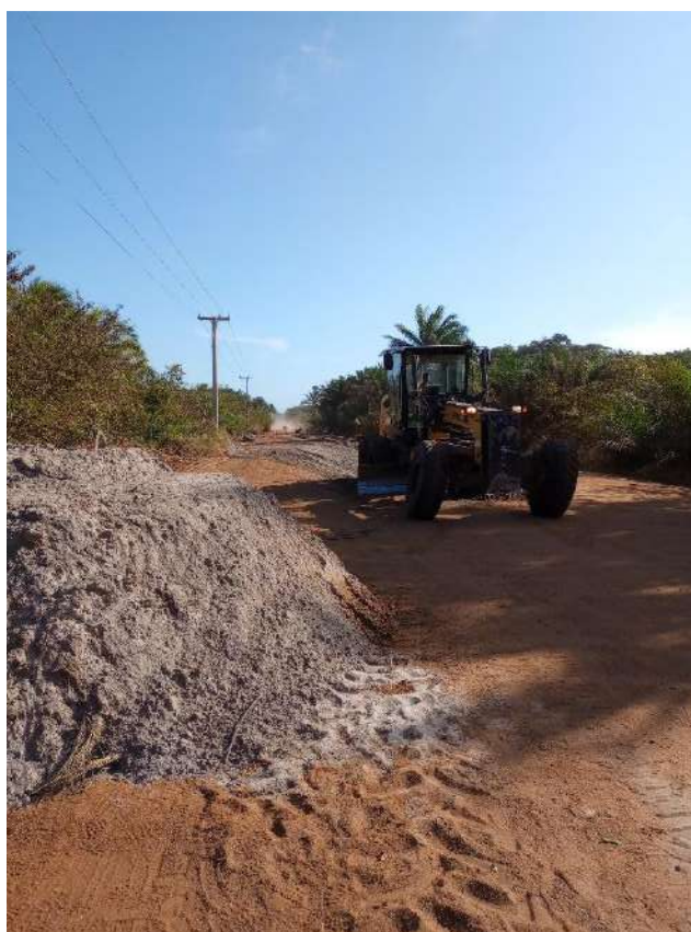
Figura 3.18 - Depósito lateral de areia na seção 2.
