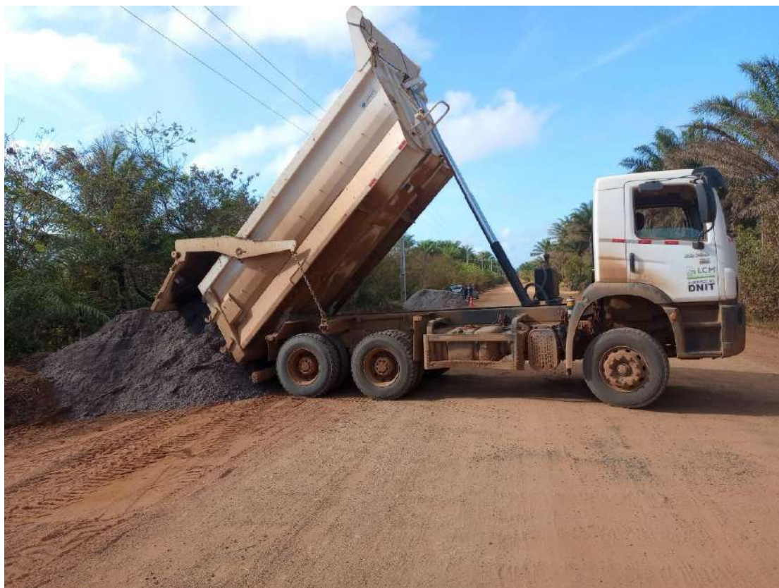
Figura 3.15 - Descarga de areia na lateral da pista da seção 2.
