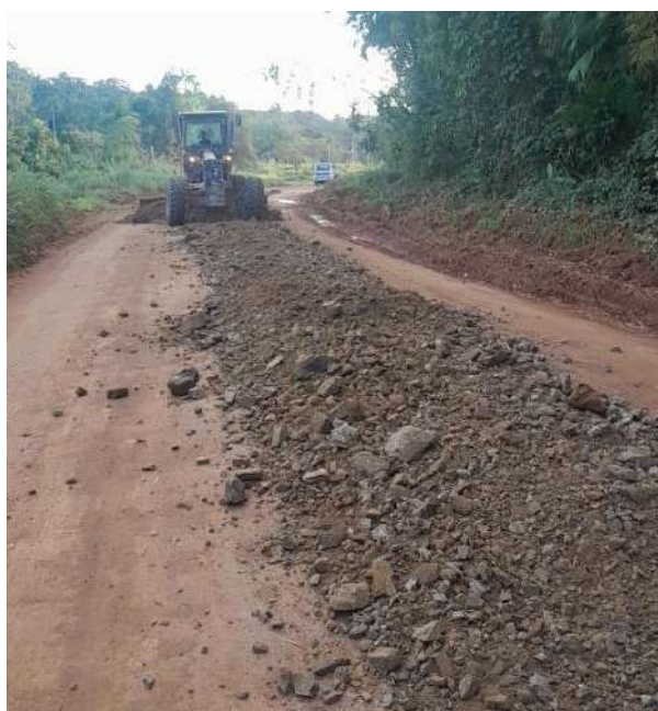
Figura 2.13 - Recomposição do revestimento primário (1).
