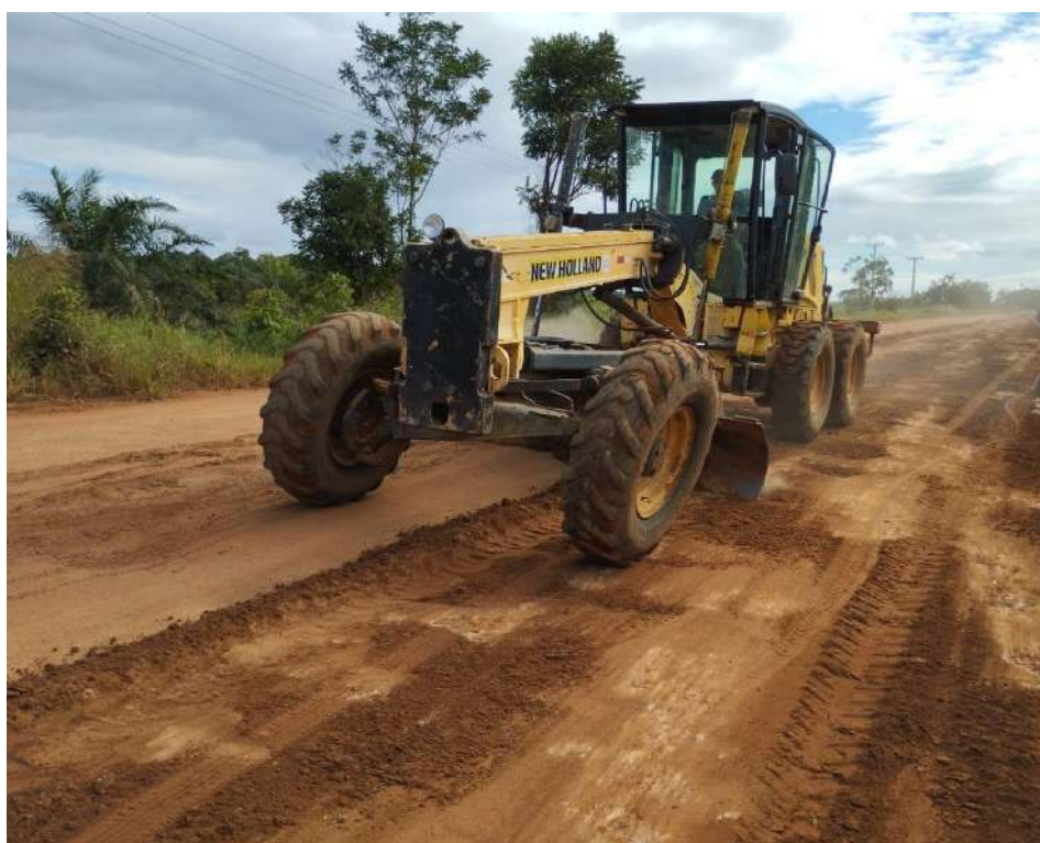
Figura 2.8 - Reconformação da plataforma (Acervo fotográfico da Unidade Local do DNIT de Itabuna).
