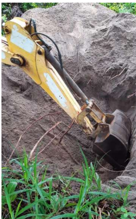
Figura 3.40 - Escavação da trincheira de investigação na faixa de domínio da estrada (T1).
