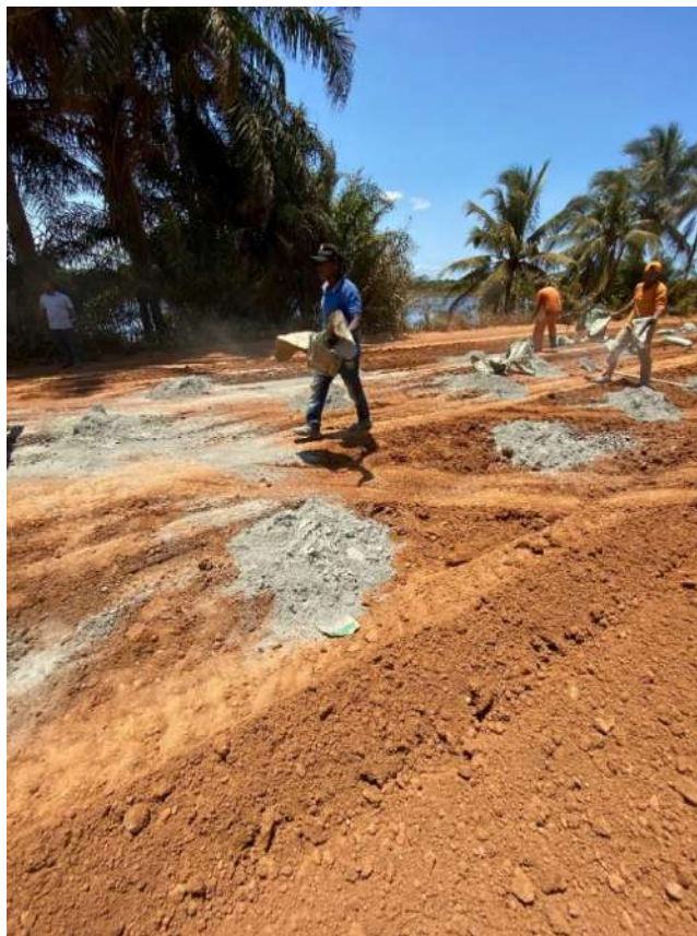
Figura 3.20 - Operação “rasga saco” de cimento Portland na pista da seção 3.
