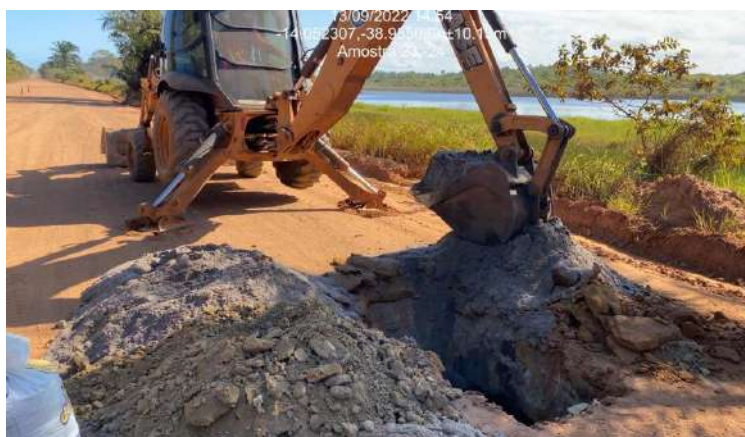
Figura 3.10 - Coleta de amostras de solos do subleito na seção 1.
