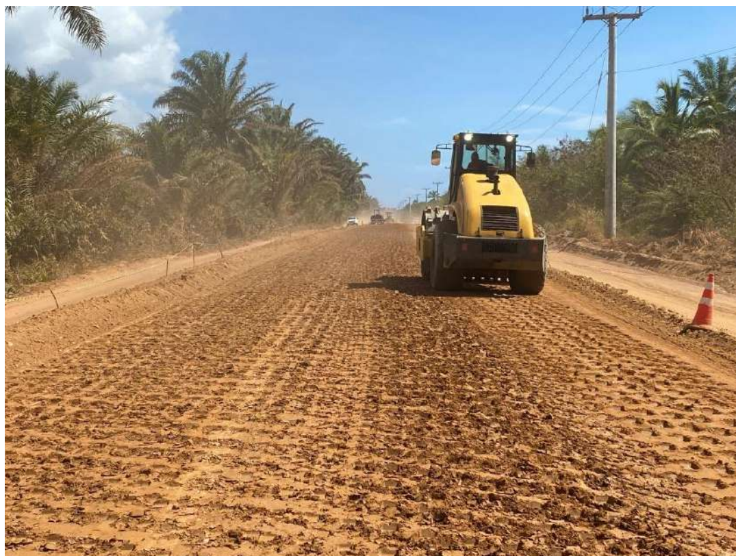
Figura 3.28 - Compactação da camada de desgaste da seção de controle.
