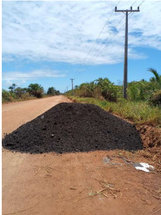
Figura 3.19 - Depósito lateral de RAP na seção 5.
