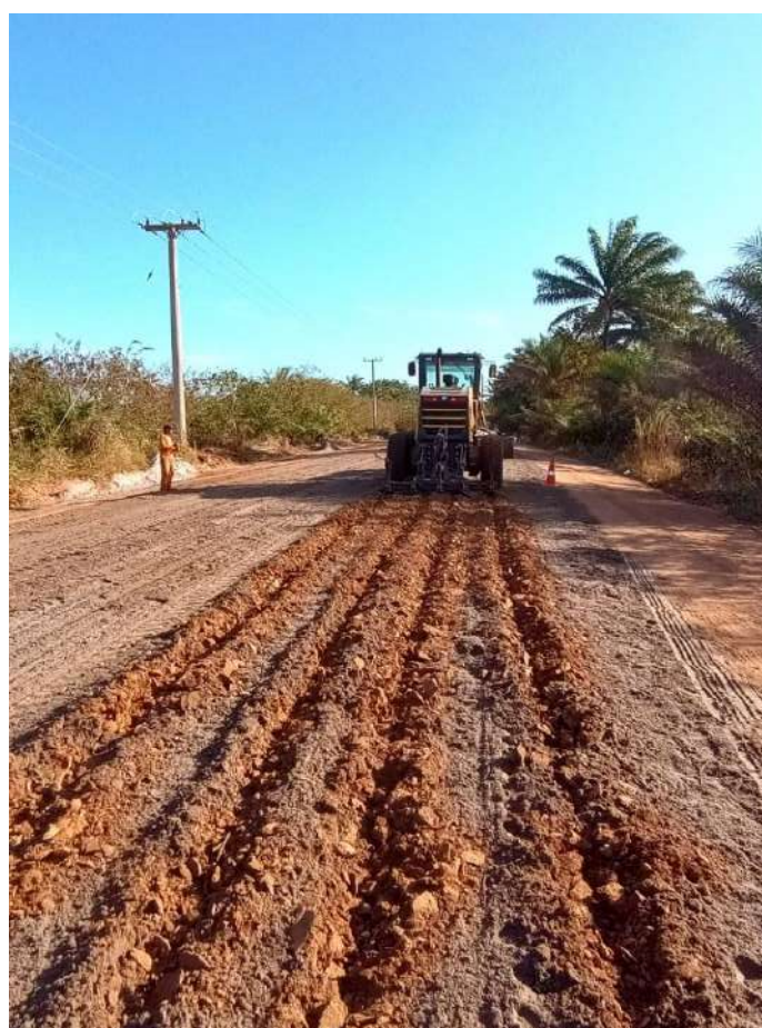
Figura 3.24 - Homogeneização de areia e revestimento primário na pista da seção 2.
