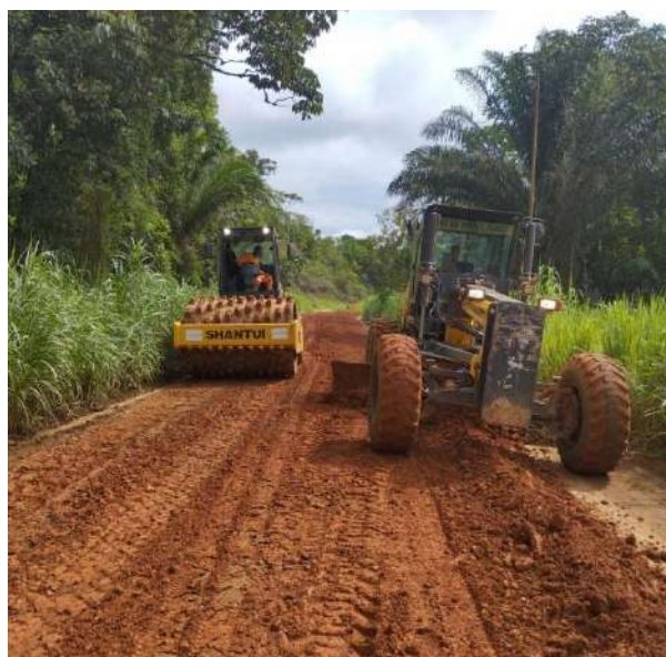
Figura 2.14 - Recomposição do revestimento primário (2).
