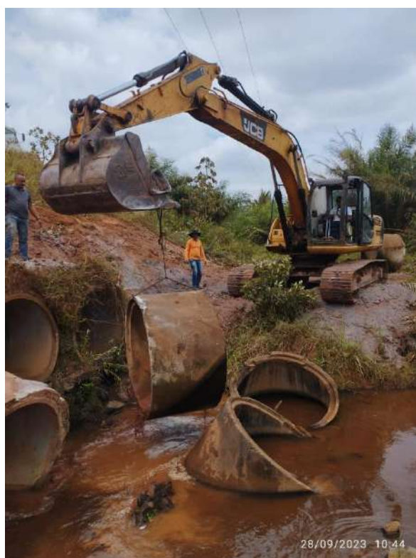
Figura 2.12 - Reconstrução de bueiro e recomposição mecanizada de aterro (Acervo fotográfico da Unidade Local do DNIT de Itabuna).
