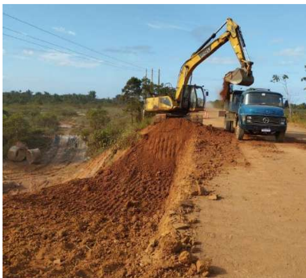
Figura 2.10 - Recomposição lateral do aterro (Acervo fotográfico da Unidade Local do DNIT de Itabuna).
