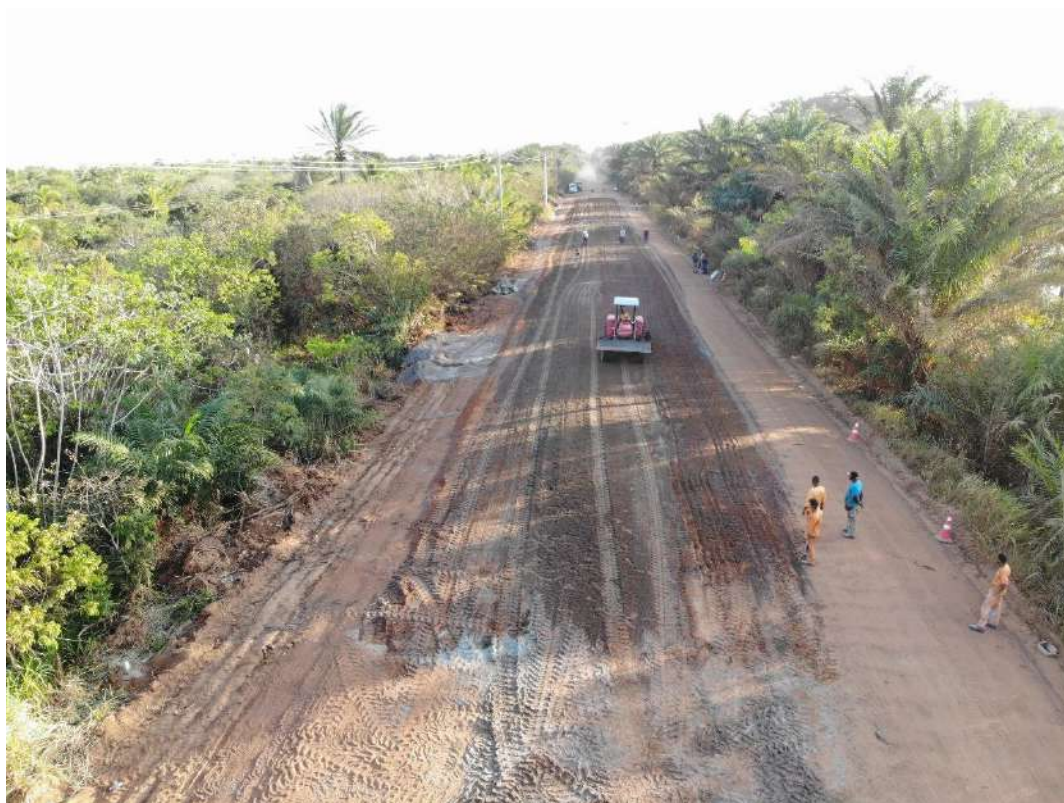
Figura 3.25 - Vista aérea da homogeneização de areia e revestimento primário na pista da seção 2.
