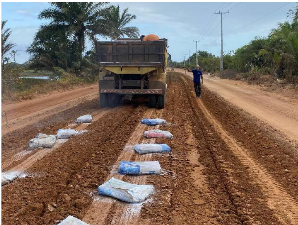
Figura 3.17 - Descarga de cimento na pista da seção 3.
