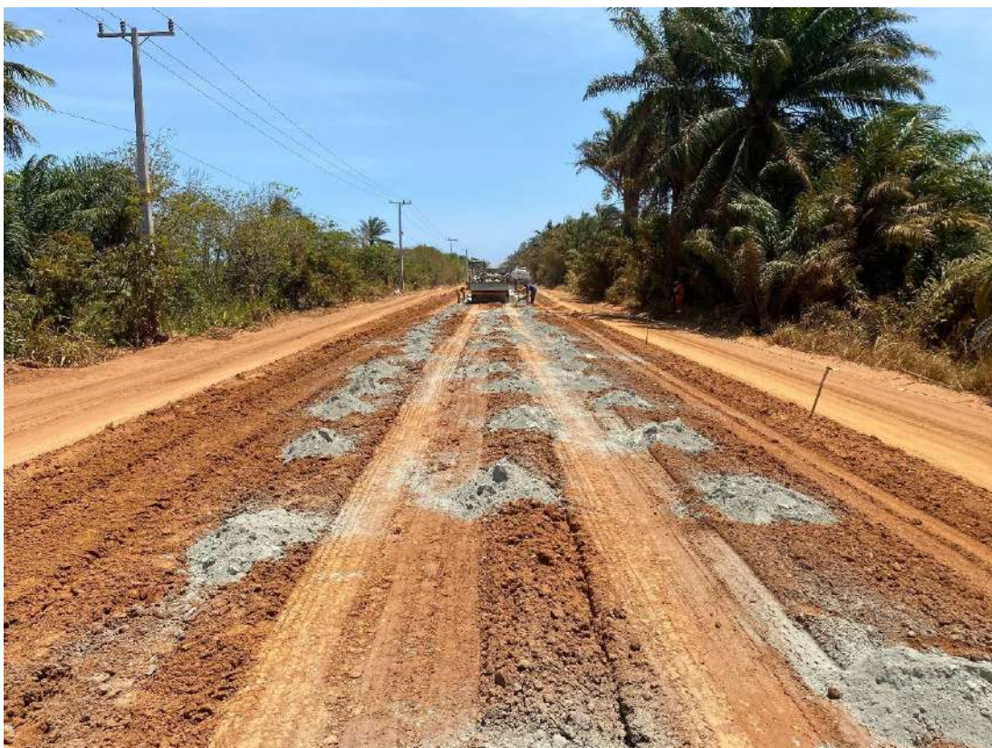
Figura 3.22 - Cimento Portland distribuído na pista da seção 3.
