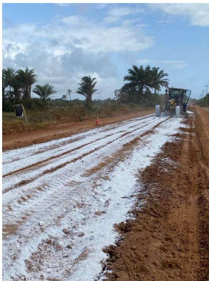
Figura 3.26 - Espalhamento e homogeneização de cal hidratada e revestimento primário na seção 6.
