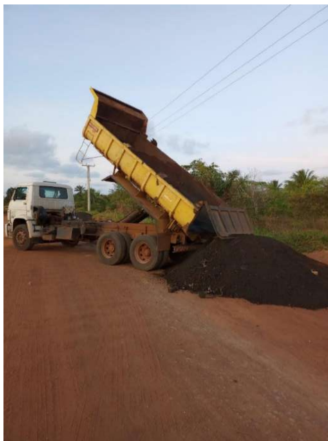
Figura 3.16 - Descarga de RAP na lateral da pista da seção 5.
