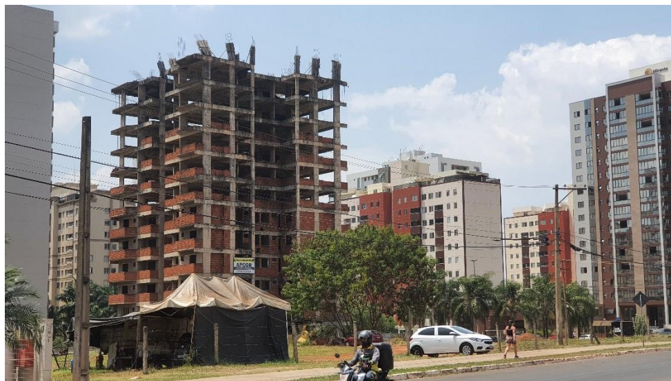
Figura 13: Residencial Coliseu (Q. 101 Norte), abandonado desde 2004.
