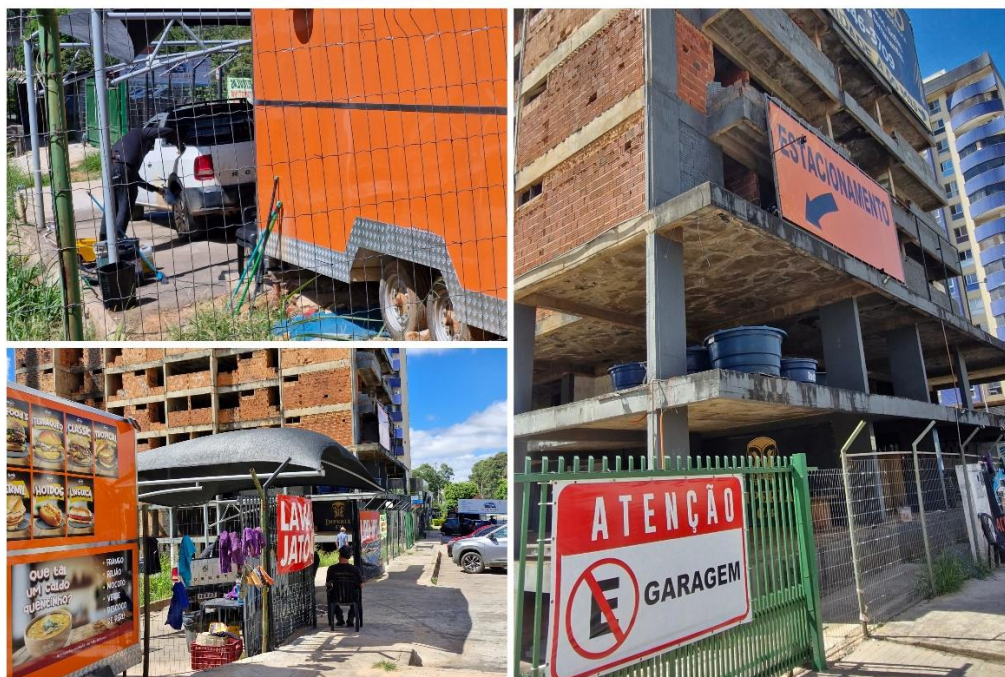
Figura 74: Prédio abandonado da Rua 34 Norte. 1ª foto: homem lava carro; 2ª foto: lava-jato instalado no prédio abandonado e food truck . 3ª foto: placas chamam atenção à função de estacionamento.
