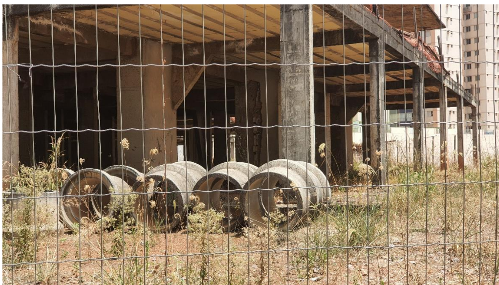
Figura 46: Interior do nível térreo do Res. Park Way. Foto colhida durante a 1ª caminhada (novembro de 2023).
