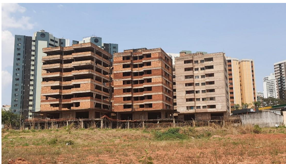
Figura 12: Condomínio abandonado (Res. Park Way) visto à distância.
