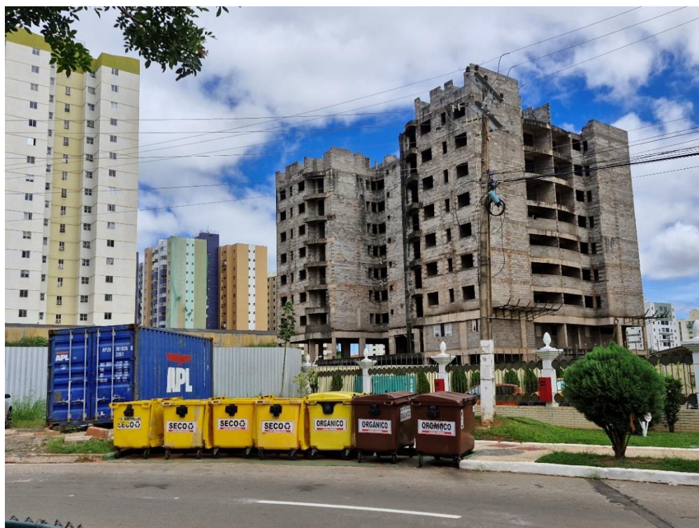
Figura 50: Imagem aproximada do prédio abandonado da Q. 102.
