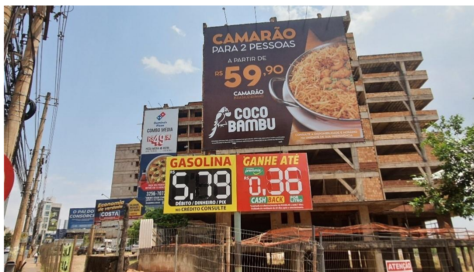
Figura 14: Anúncios expostos nas estruturas do Residencial Park Way (Av. das Castanheiras).
