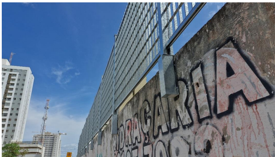
Figura 83: Grades instaladas acima das muretas nas pontes sobre a linha do metrô.
