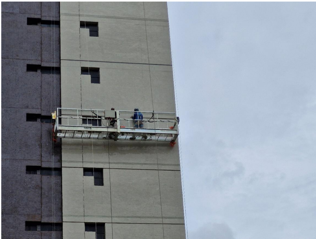
Figura 24: Trabalhadores realizam manutenção em um dos condomínios da Quadra 203.
