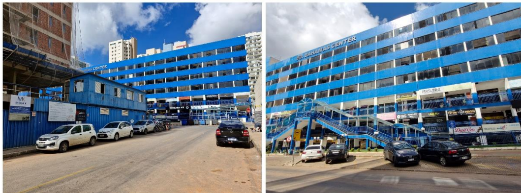
Figura 38: Vista de minha chegada e fachada do Bahamas Center (R. 36 Sul e Av. Jequitibá).
