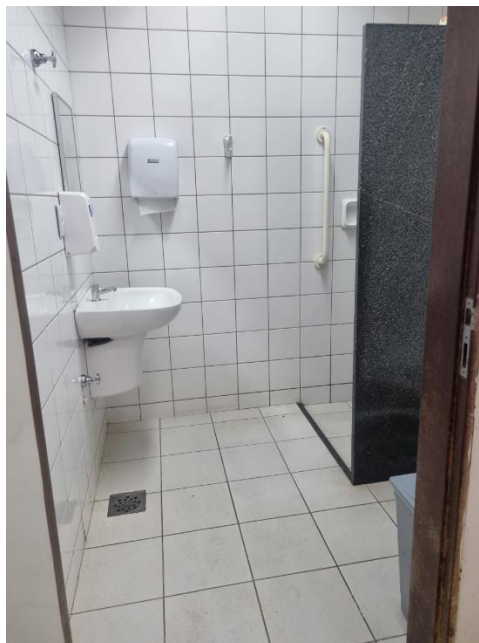
Figura 7 - Banheiro da enfermaria
