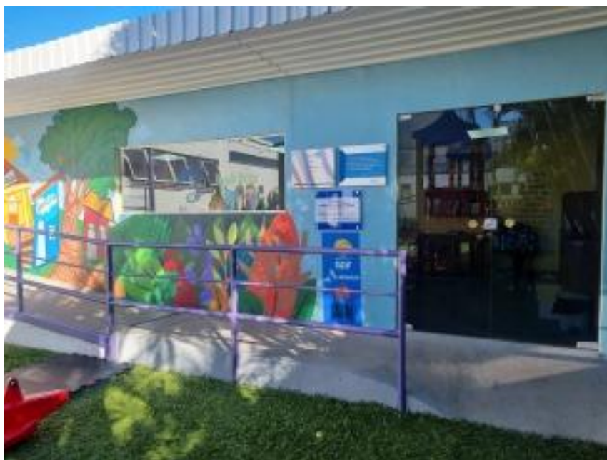
Figura 16 - Fachada da Classe Hospitalar
