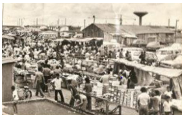
Figura 14 - Primeiros movimentos para a construção de Ceilândia
