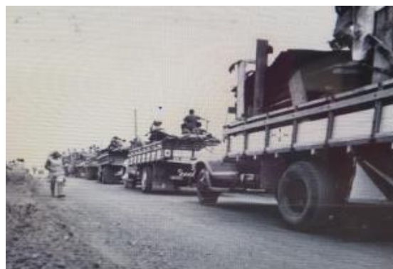
Figura 13 - Primeiros movimentos para a construção de Ceilândia
