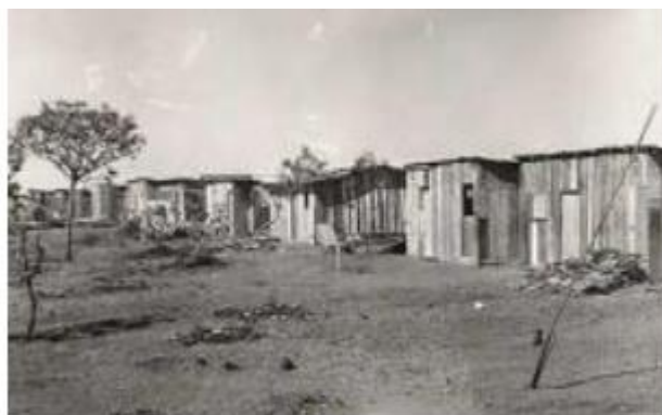
Figura 12 - Primeiros movimentos para a construção de Ceilândia
