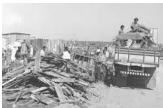
Figura 15 - Primeiros movimentos para a construção de Ceilândia
