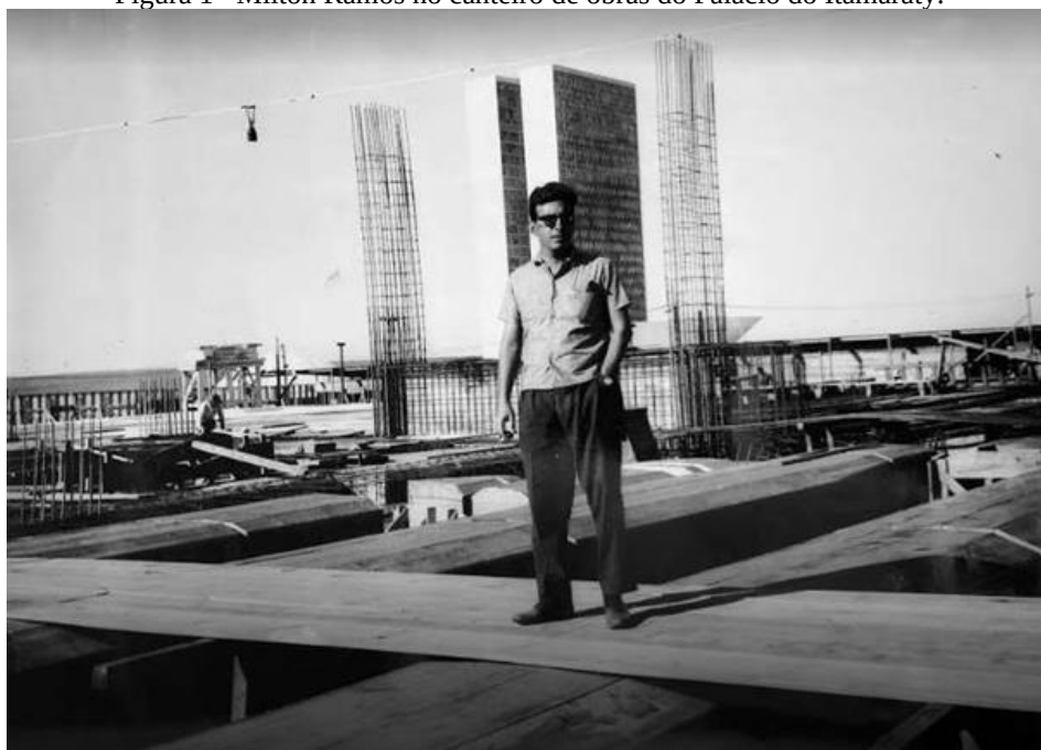
Figura 1 –Milton Ramos no canteiro de obras do Palácio do Itamaraty.
