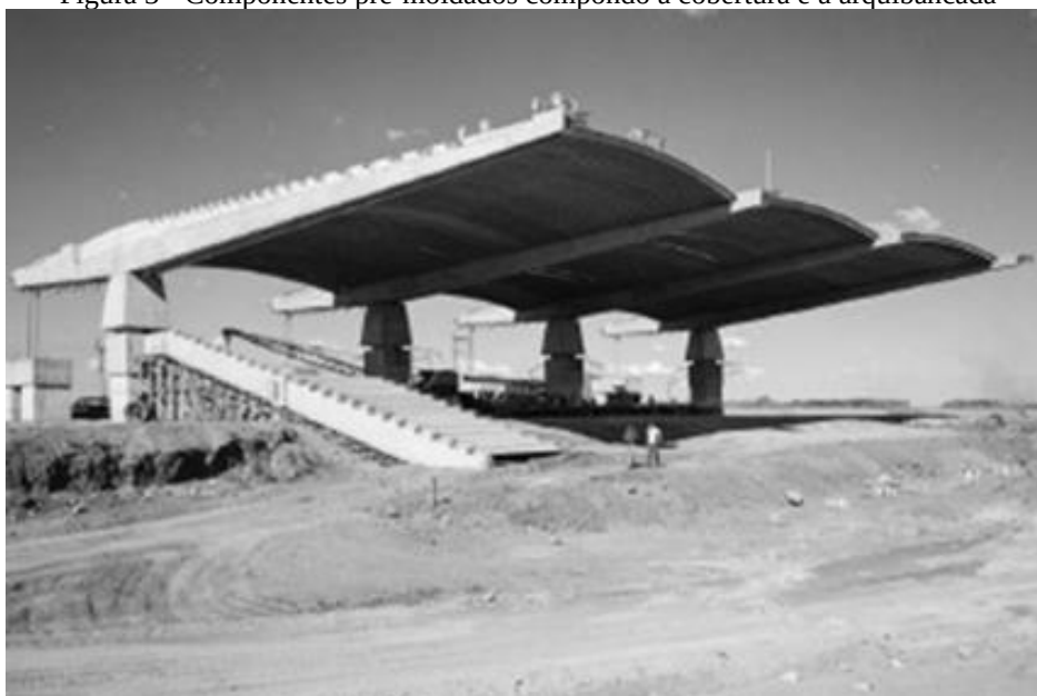
Figura 3 - Componentes pré-moldados compondo a cobertura e a arquibancada
