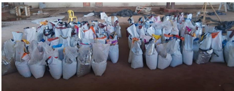
Figura 3.14 – Materiais pesados e ensacados para o controle da dosagem
