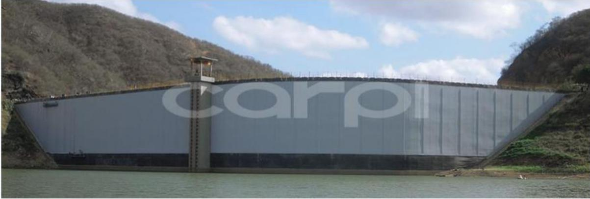
Figura 2.17 - Reabilitação a seco de barragem no Brasil em 2011 (Carpi, 2023).
