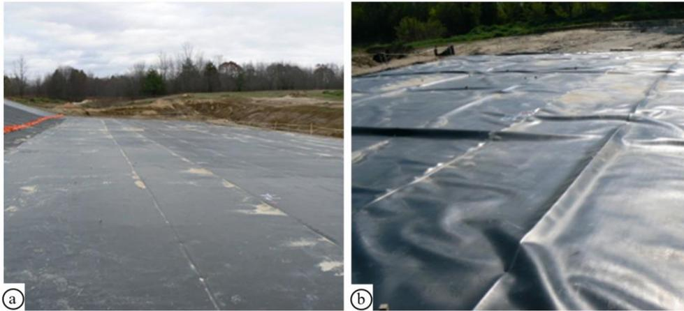
Figura 2.28 - GM instalada em contato direto com CCL: a) nublado no início da manhã de novembro, quando a temperatura ambiente foi de 3°C; b) rugas interconectadas, a meio dia de novembro, quando a temperatura ambiente chegou a 17°C (Rowe & Hosney, 2010).
