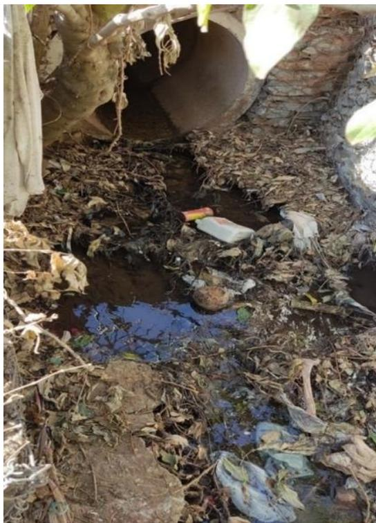
**Figura 9.** Ponto de lançamento de drenagem próximo ao Córrego Currais no Distrito Federal.
