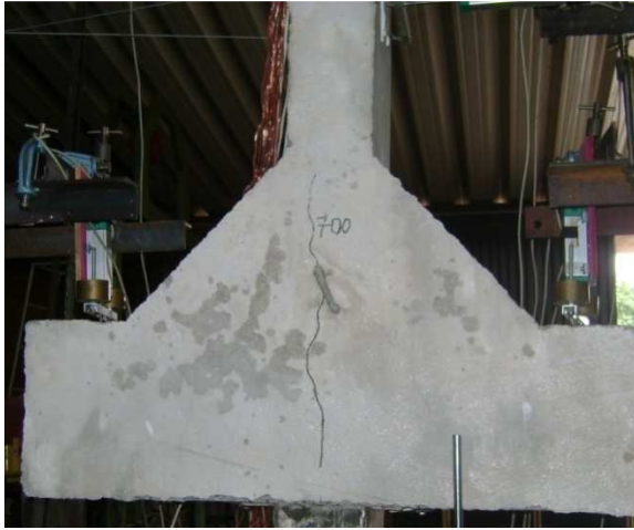
Figura 4.2 - Fissura no modelo PFN 0 - 2,0
