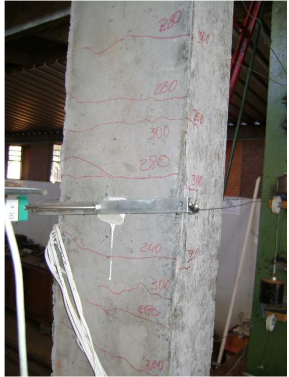
Figura 4.9 - Fissuras no Pilar PFN 30 - 2,5
