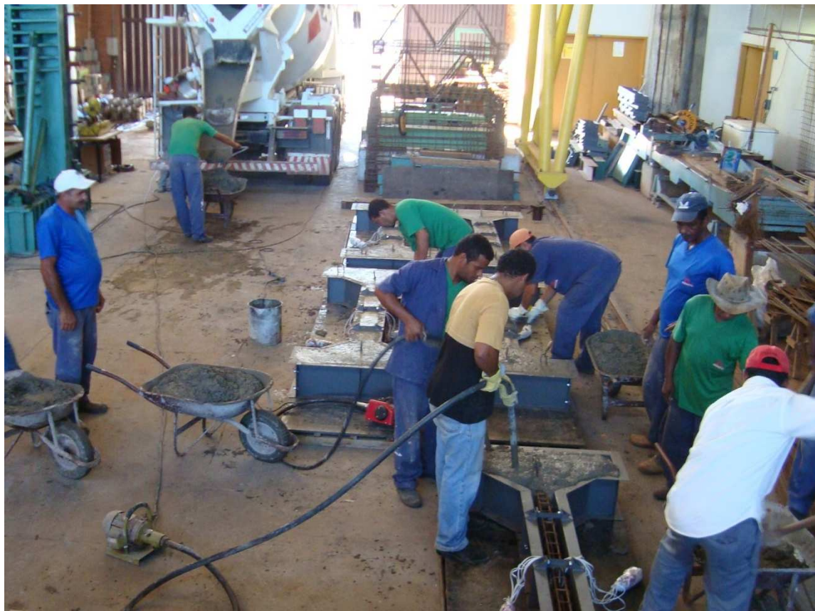
Figura 3.6 - Concretagem dos pilares
