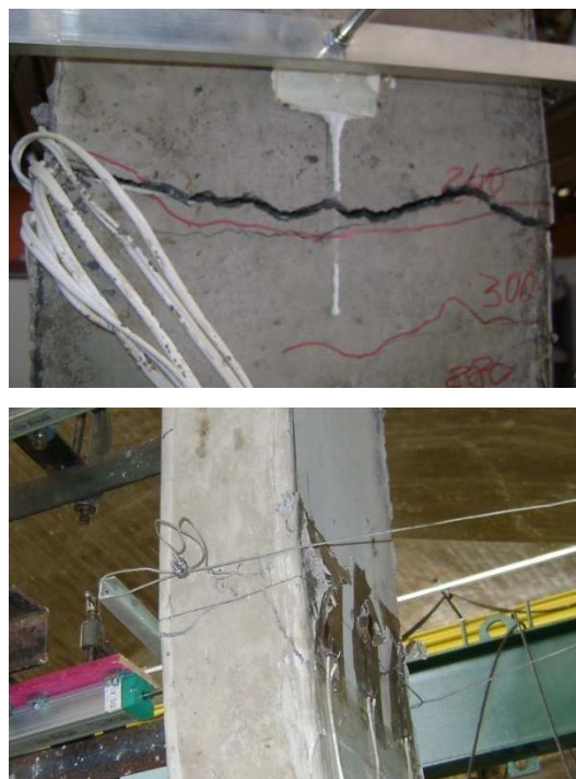
Figura 4.21– Detalhe das faces tracionada e comprimida do pilar PFN 30 – 2,5
