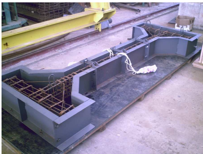
Figura 3.5 - Formas montadas com as armaduras posicionadas
