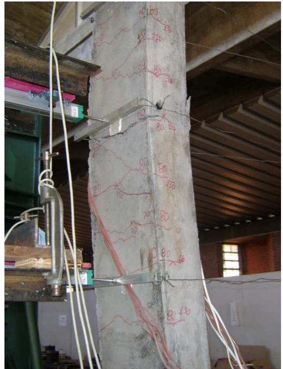
Figura 4.15-Fissuras no Pilar PFN 60 - 2,5
