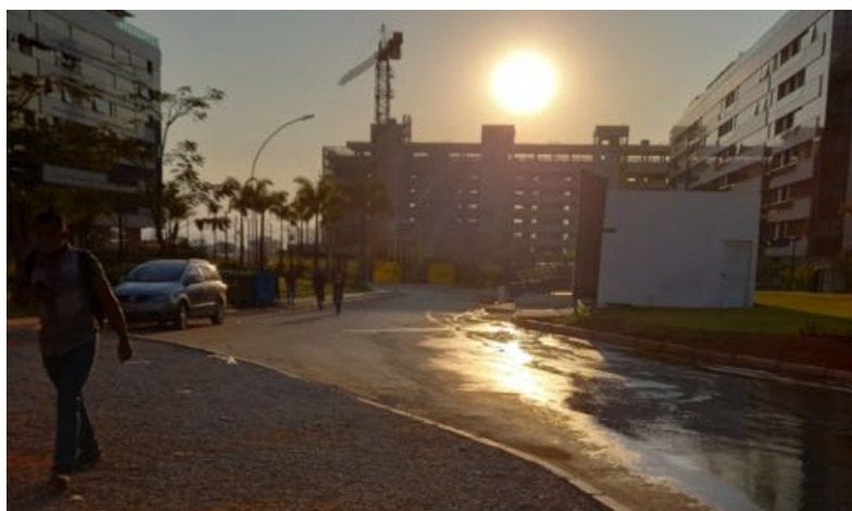
Figura 1.1: fotografia do Setor Noroeste às 6h30 - silhuetas de trabalhadores em edificações chegando nos canteiros de obra, edifícios habitados com árvores e palmeiras e um edifício em construção com uma grua, rua asfaltada com meio-fio e sem calçada, solo coberto com brita, um contêiner de armazenagem e o sol raiando ao fundo. Fonte: foto da autora, agosto de 2021.
