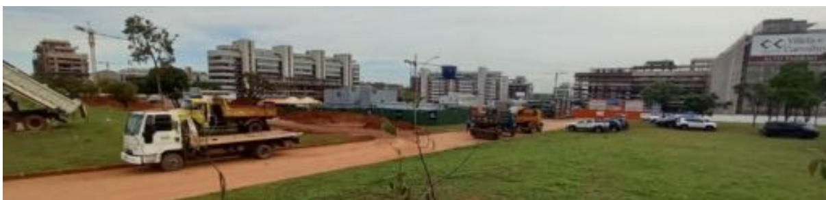
Figura 3.15: fotografia de visão geral entre canteiros com 4 caminhões de carga e 1 guincho na etapa 2. Fonte: fotografia tirada pela autora em novembro de 2021.
