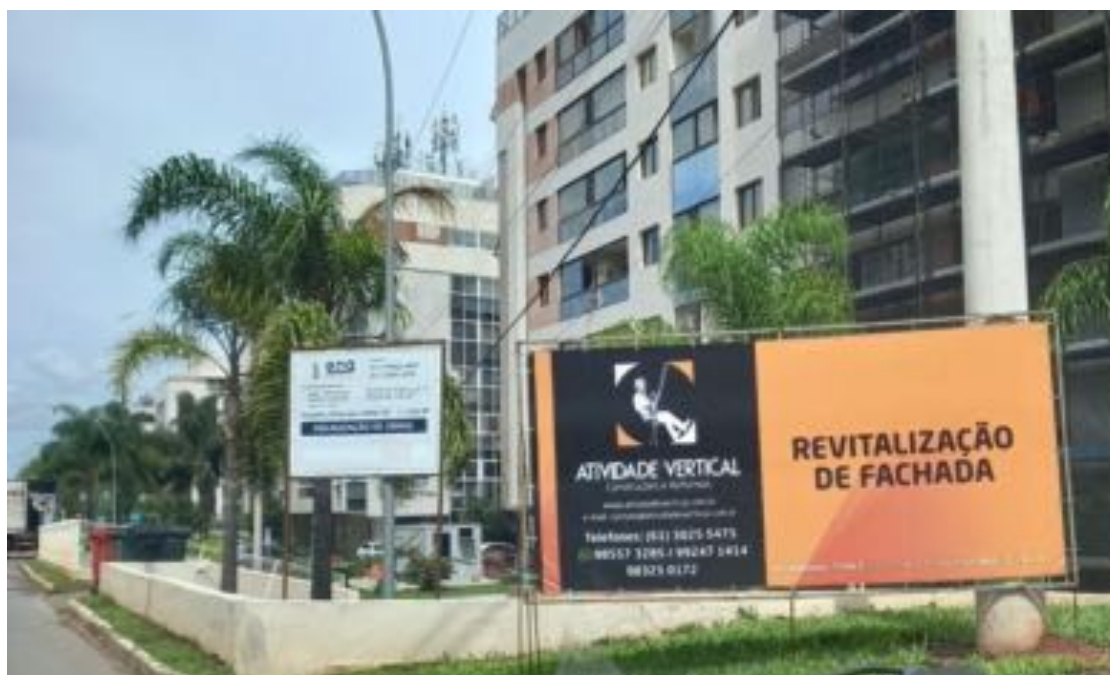
Figura 3.14: fotografia de placas de obra indicando reformas de fachada em frente a edifícios da etapa 1. Fonte: fotografia tirada pela autora em novembro de 2021.
