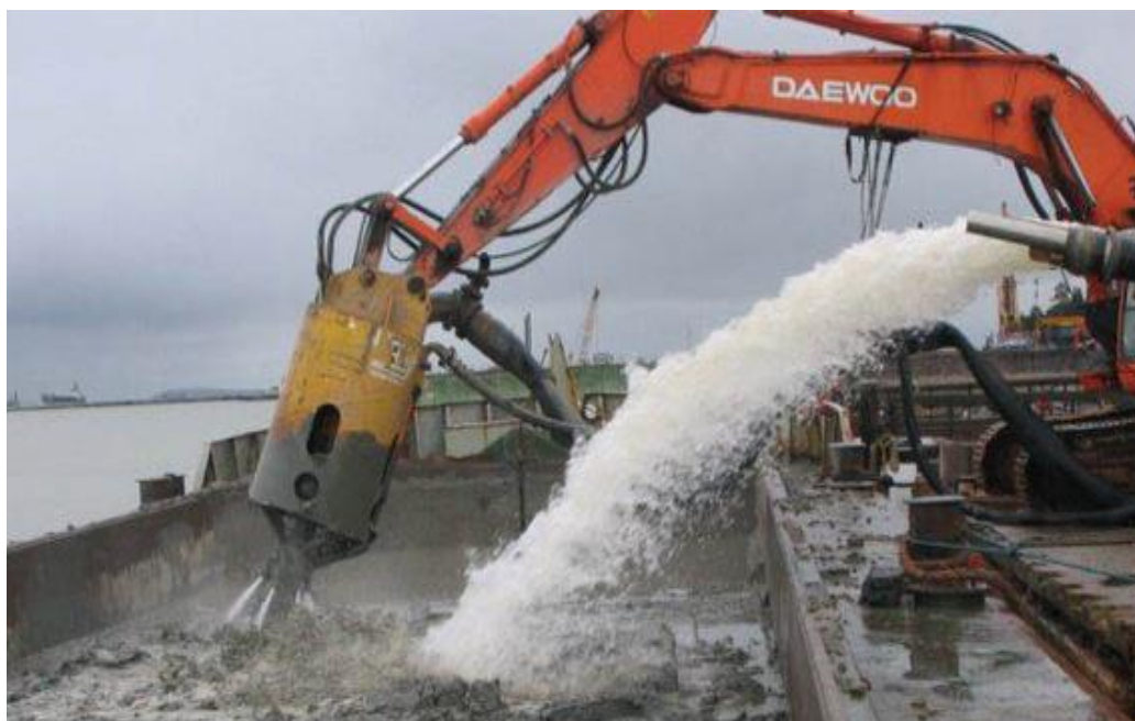
Figura 21 – Atividade de dragagens no Porto de Santos
