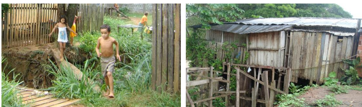
Figuras 10 e 11. Falta de habitabilidade das invasões em Corpos Hídricos. Fonte: Governo do Estado.
