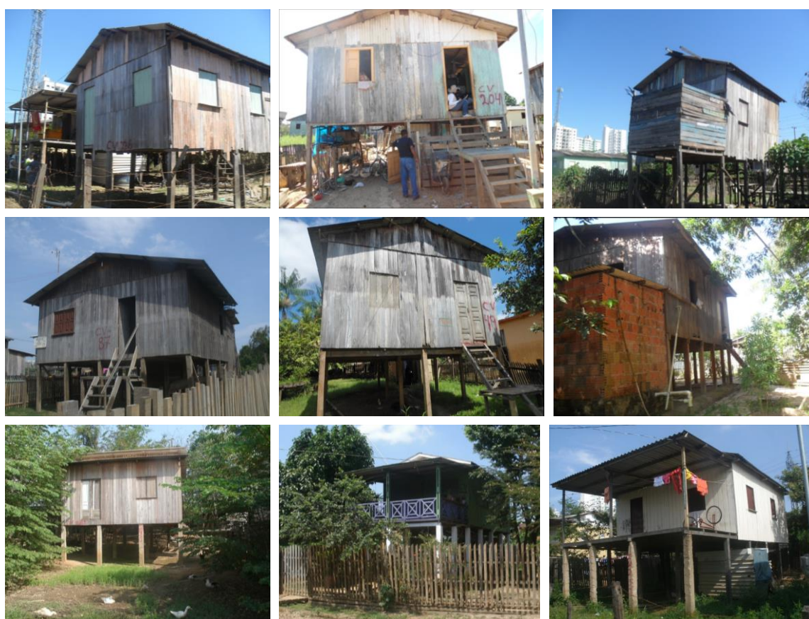
Figura 59. Fotos de casas sobre palafitas no bairro Cadeia Velha. Fonte: SEHAB (2014).
